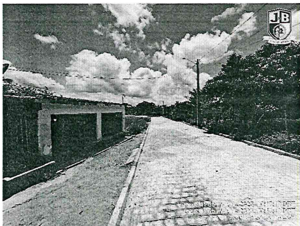
FOTO 9: Rua Projetada 6 - Encruzilhada
