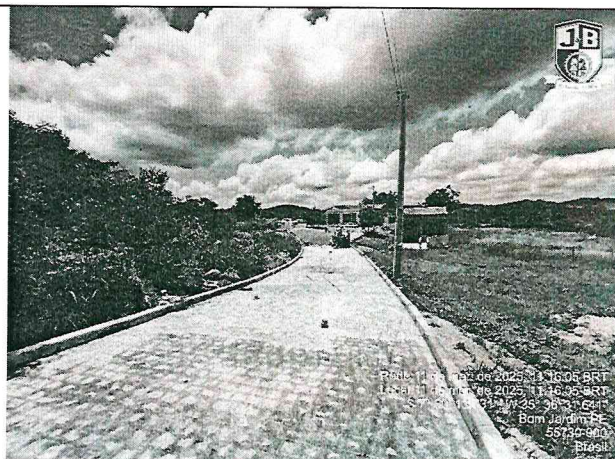
FOTO 14: Rua Projetada 6 - Encruzilhada
