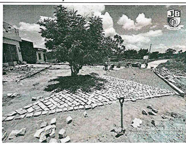
FOTO 18: Rua Projetada 6 - Encruzilhada
