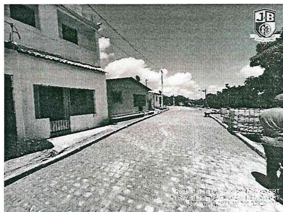
FOTO 8: Rua Projetada 6 - Encruzilhada
