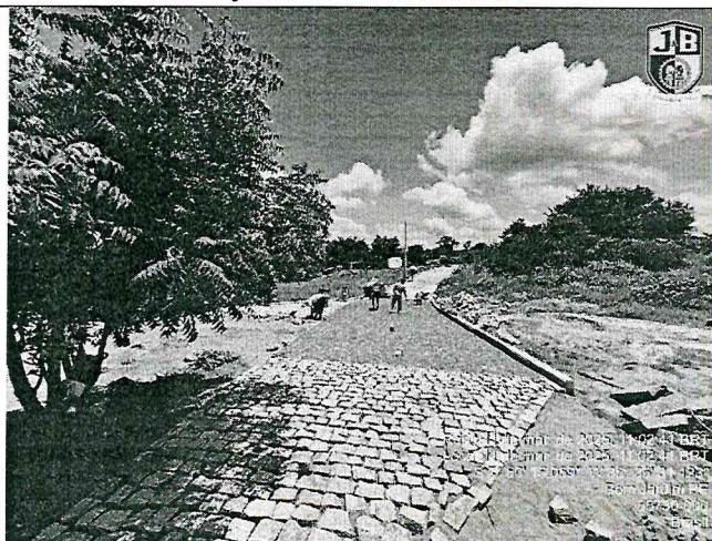
FOTO 17: Rua Projetada 6 - Encruzilhada
