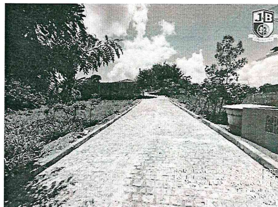
FOTO 2: Rua Projetada 5 - Encruzilhada
