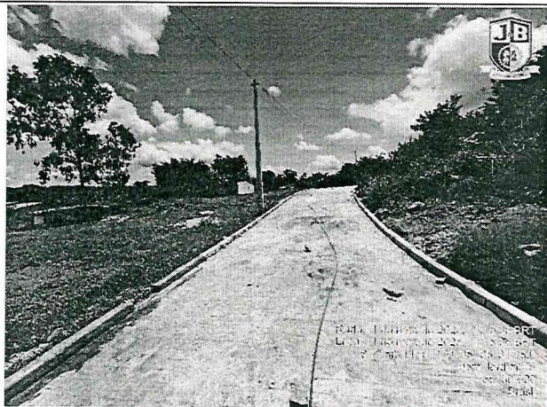
FOTO 13: Rua Projetada 6 - Encruzilhada
