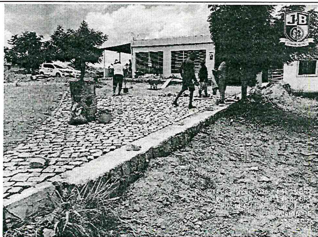
FOTO 21: Muro de Contenção - Rua Projetada 6 - Encruzilhada
