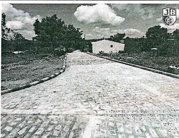
FOTO 6: Rua Projetada 5 - Encruzilhada
