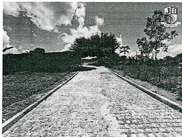
FOTO 3: Rua Projetada 5 - Encruzilhada
