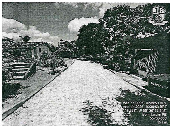
FOTO 1: Rua Projetada 5 - Encruzilhada
