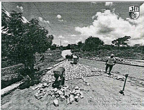
FOTO 19: Rua Projetada 6 - Encruzilhada
