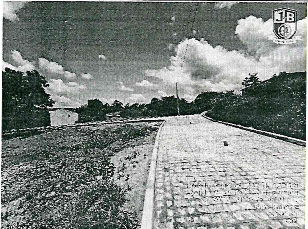
FOTO 15: Rua Projetada 6 - Encruzilhada
