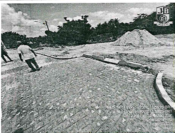
FOTO 11: Rua Projetada 6 - Encruzilhada
