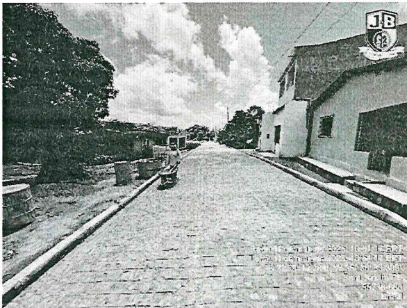
FOTO 10: Rua Projetada 6 - Encruzilhada
