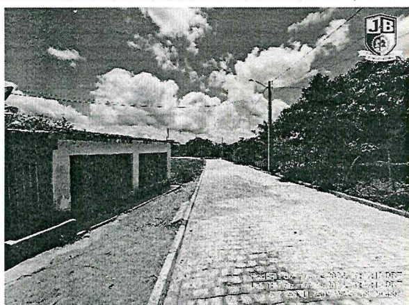
FOTO 7: Rua Projetada 6 - Encruzilhada
