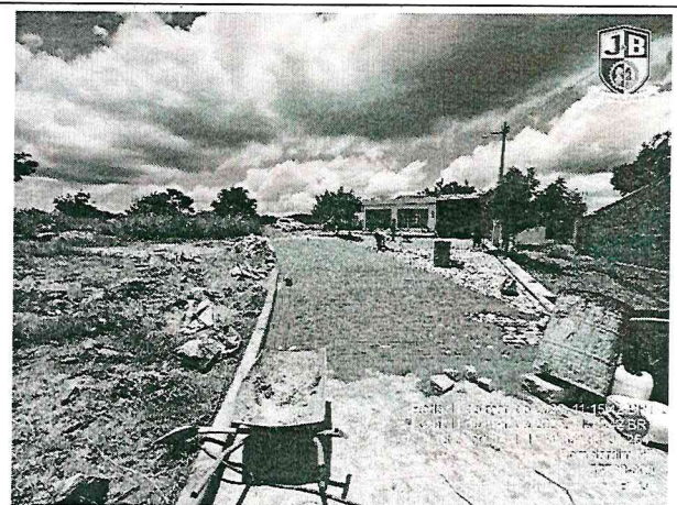
FOTO 16: Rua Projetada 6 - Encruzilhada
