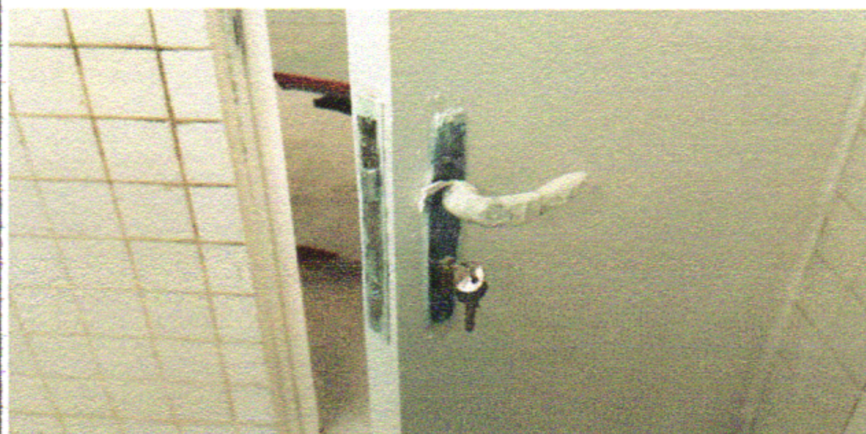
INSTALAÇÃO DE FECHADURAS EXTERNA
