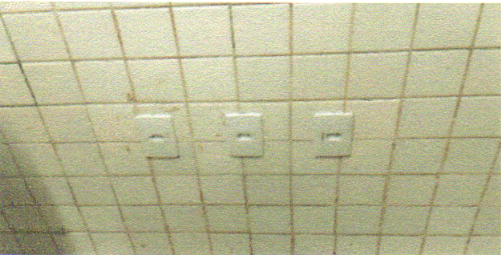
INSTALAÇÃO DAS TOMADAS BAIXA DE EMBUTIR 10A NA SALA DE AULA
