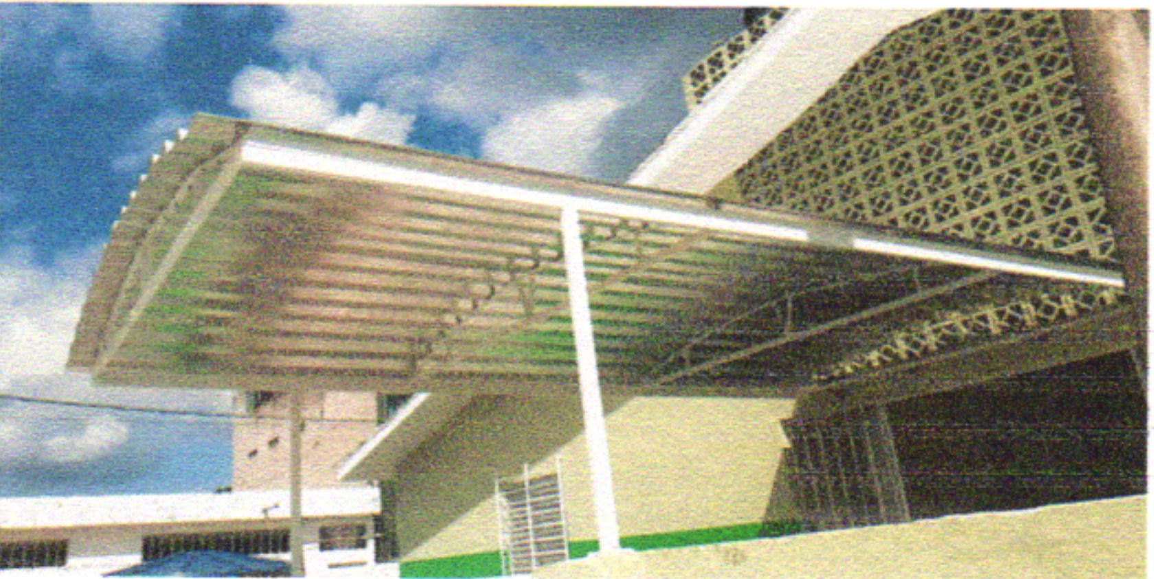
NOVA COBERTA COM ESTRUTURA METÁLICA E TELHA DE AÇO
