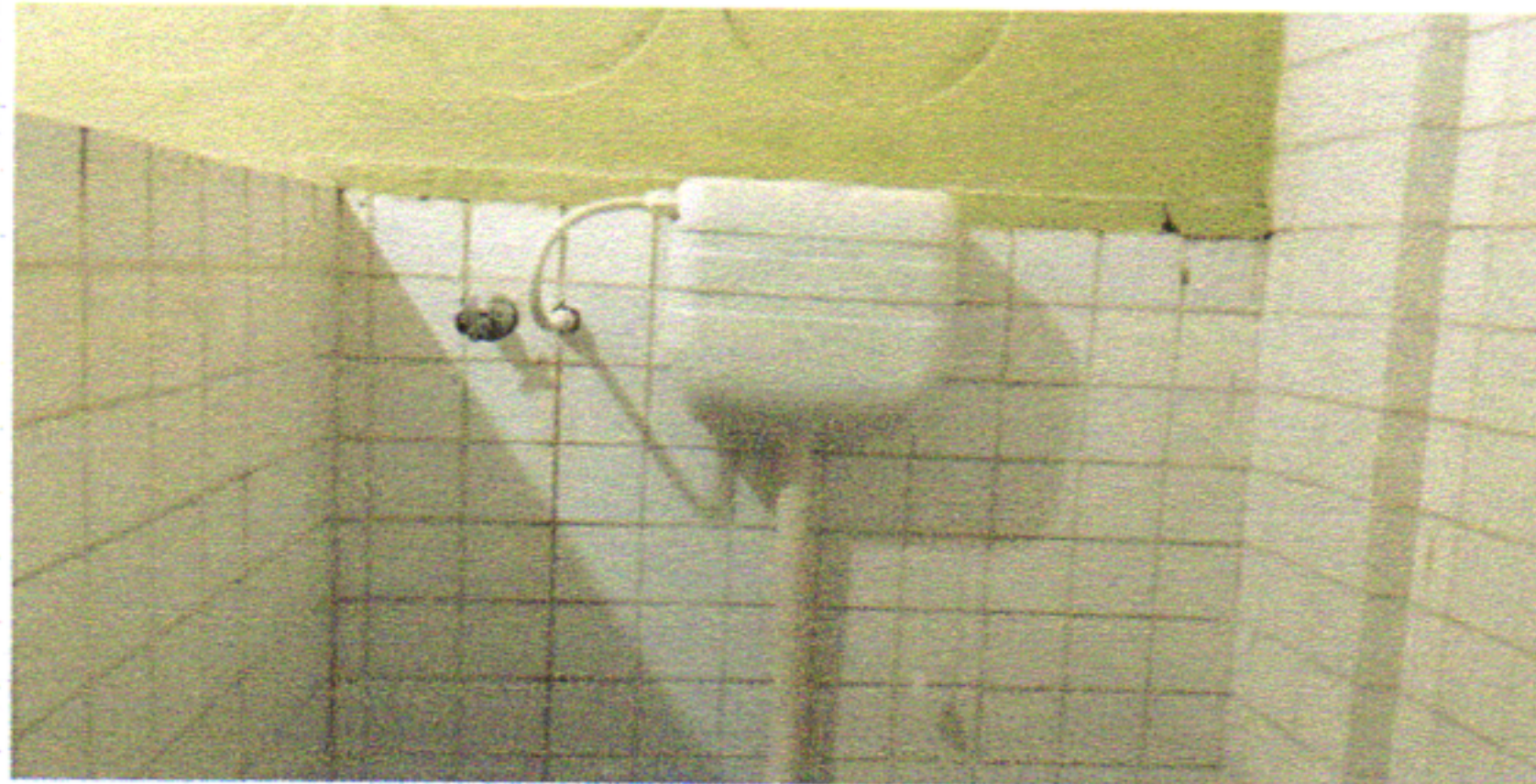
INSTALAÇÃO DA CAIXA DE DESCARGA DE SOBREPOR, ENGATE E KIT SALVA REGISTRO
