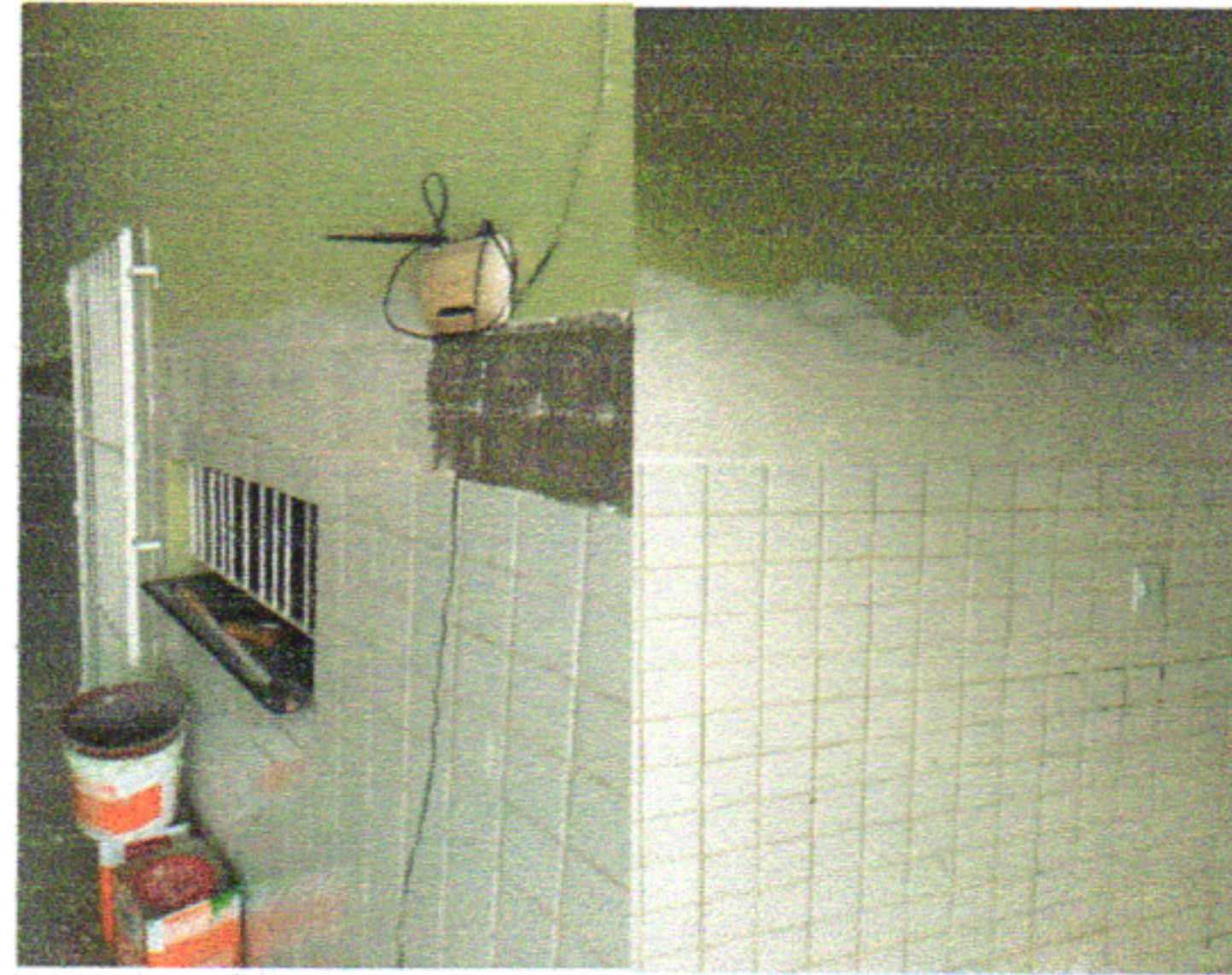
DEMOLIÇÃO DO REVESTIMENTO CERÂMICO 10X10 CM, REFERENTE AO UMA FAIXA COM ALTURA DE 20CM PARA A APLICAÇÃO DE MASSA CORRIDA
