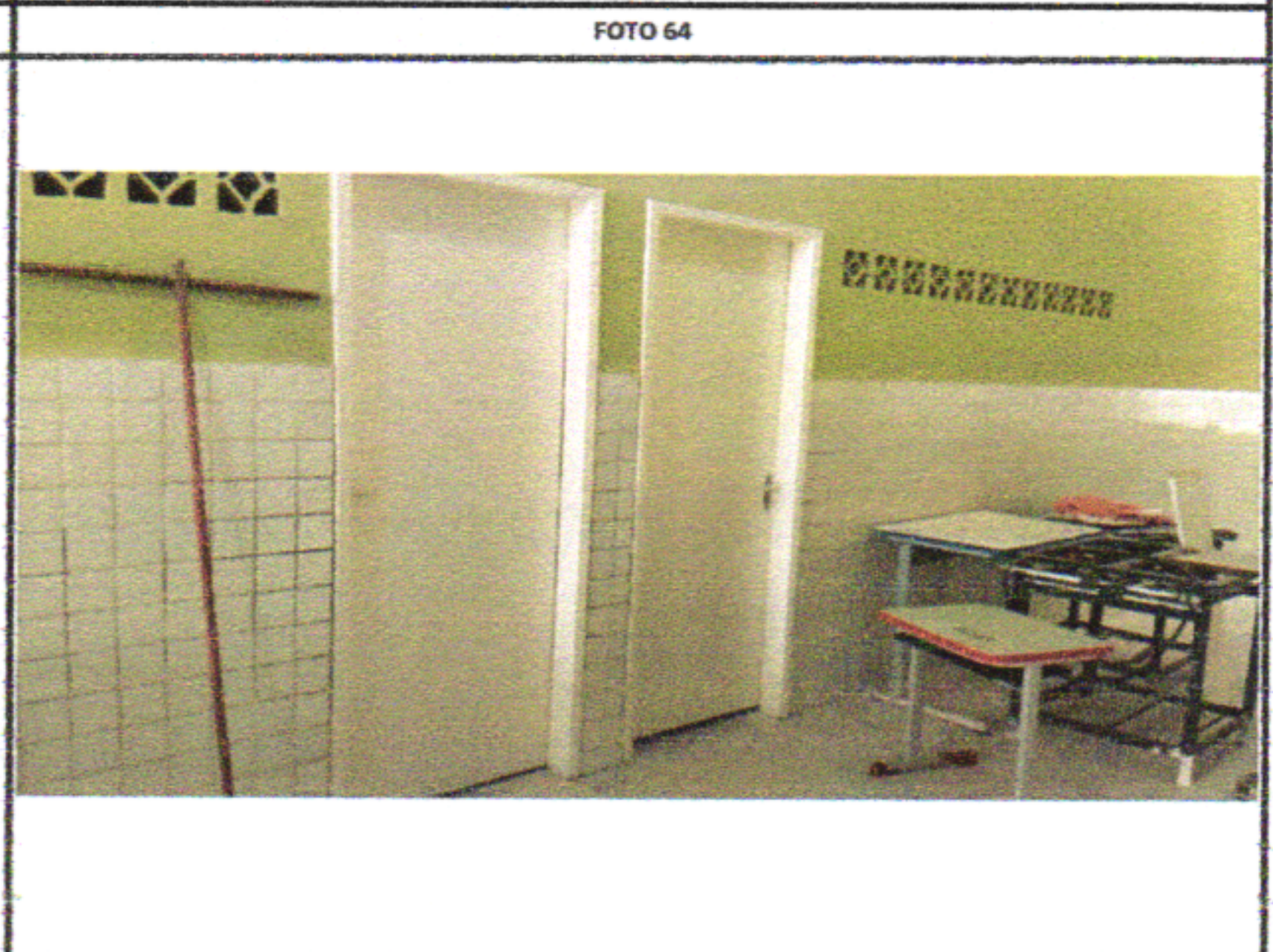
INSTALAÇÃO DE NOVAS PORTAS DE MADEIRA COM FECHADURA NAS SALAS DE AULA, PINTADA COM TINTA ESMALTE BRANCO NEVE
