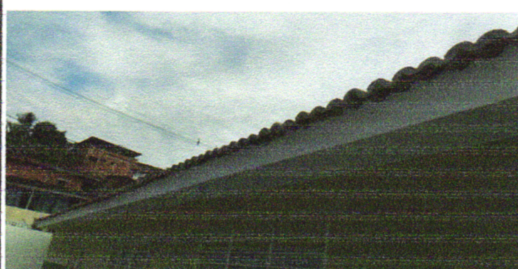
BEIRA E BICA COM TELHA CERÂMICA TIPO CONONIAL
