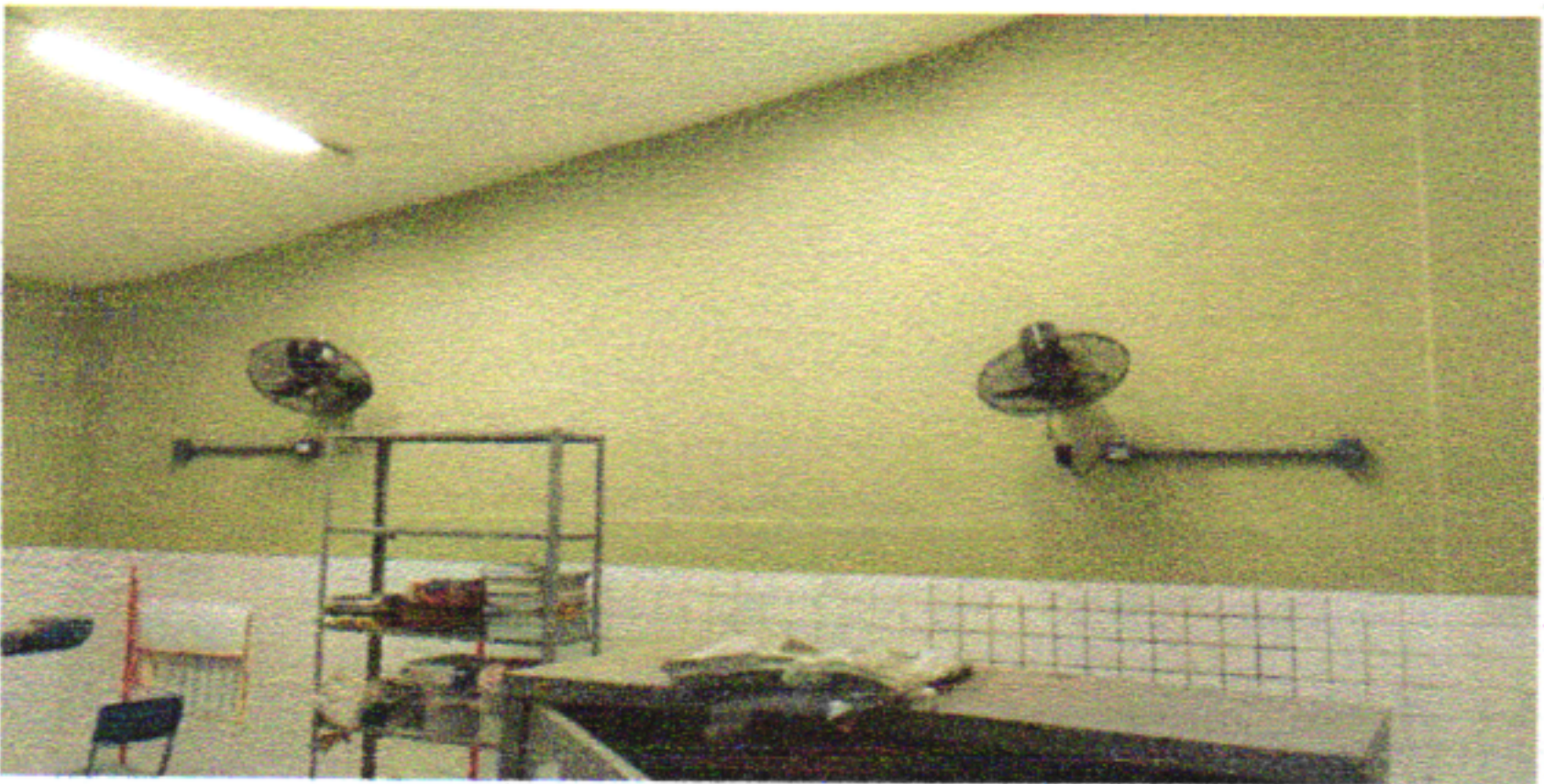
INSTALAÇÃO DOS VENTILADORES COM UTILIZAÇÃO DE ELETRODUTO RÍGIDO 3/4", CABO ELÉTRICO 2,5MM², ABRAÇADEIRAS, PARAFUSOS, CONDULETE PVC MULTIPLA TIPO X, TOMADAS E PLUG MACHO
