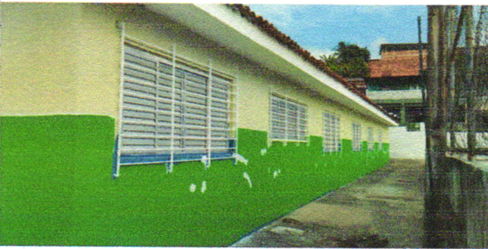
REPAROS NA PINTURA COM MASSA CORRIDA E PINTURA COM TINTA ACRÍLICA EM PAREDES
