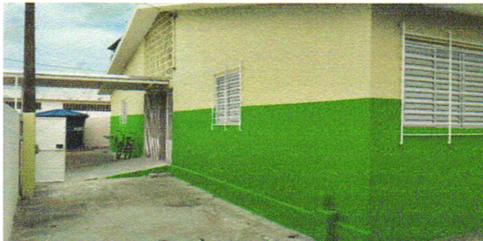
PINTURA ACRÍLICA EM PAREDES, PINTURA ESMALTE NAS GRADES DE PROTEÇÃO DAS JANELAS E PINTURA DE CAIAÇÃO NA PARTE INTERNA DO MURO
