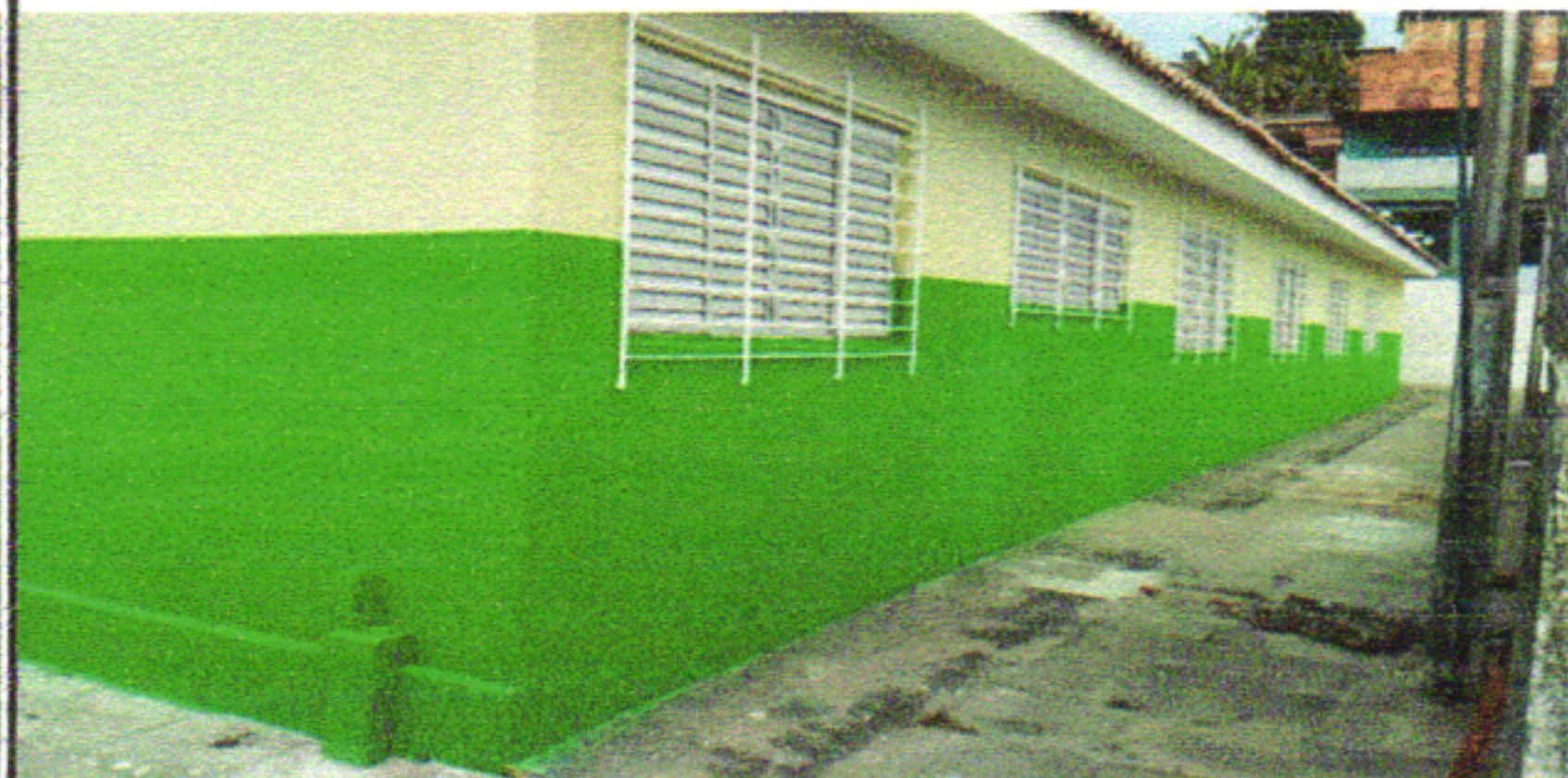
PINTURA ACRÍLICA EM PAREDES E PINTURA ESMALTE NAS GRADES DE PROTEÇÃO DAS JANELAS
