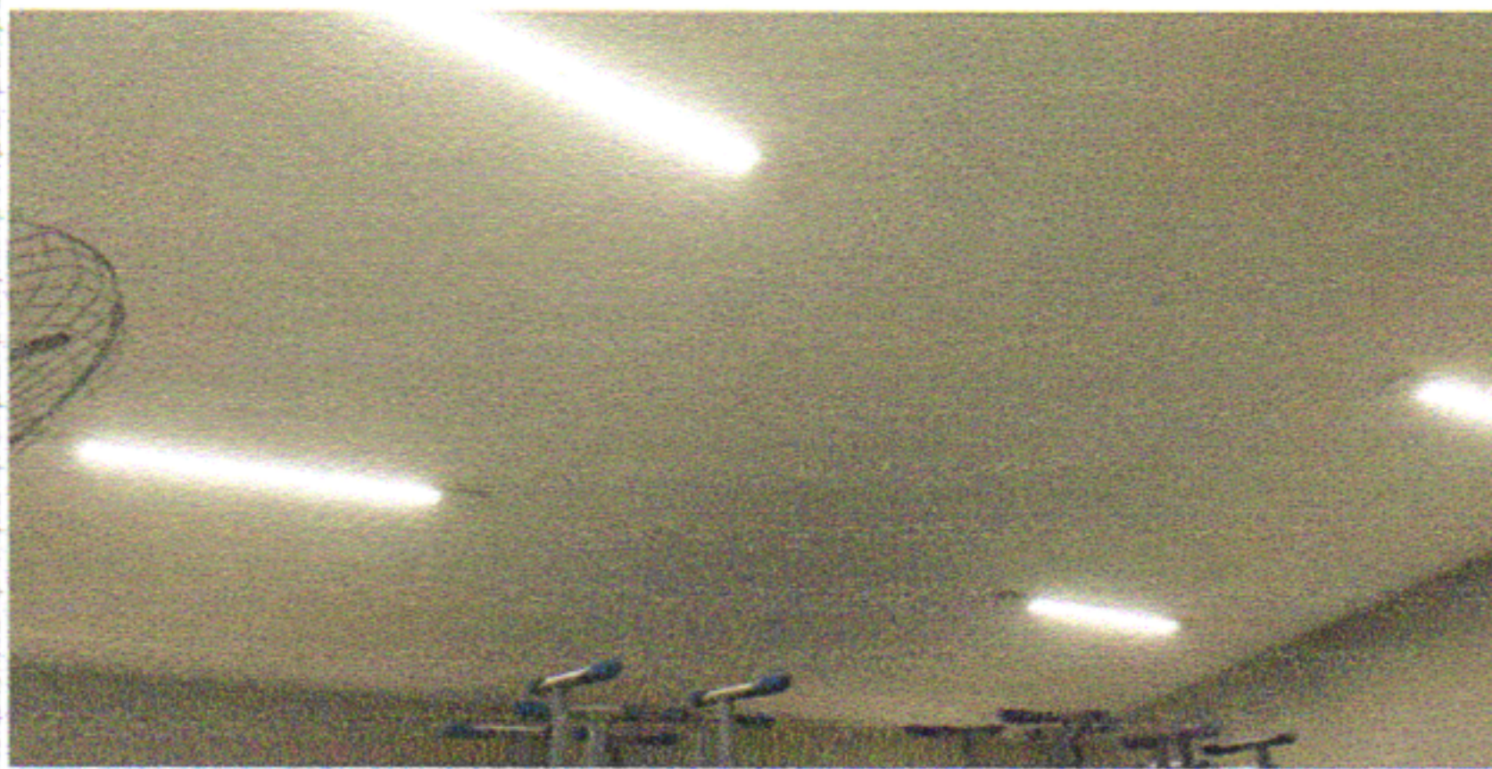
INSTALAÇÃO DE LÂMPADAS LED TUBULAR E PINTURA ACRÍLICA NO TETO
