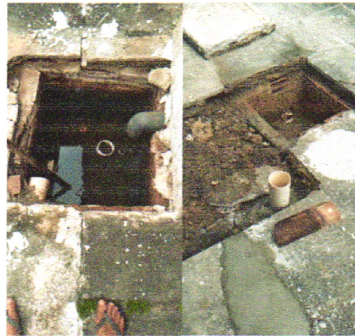
DESOBSTRUÇÃO DAS CAIXAS DE PASSAGEM / ESGOTO
