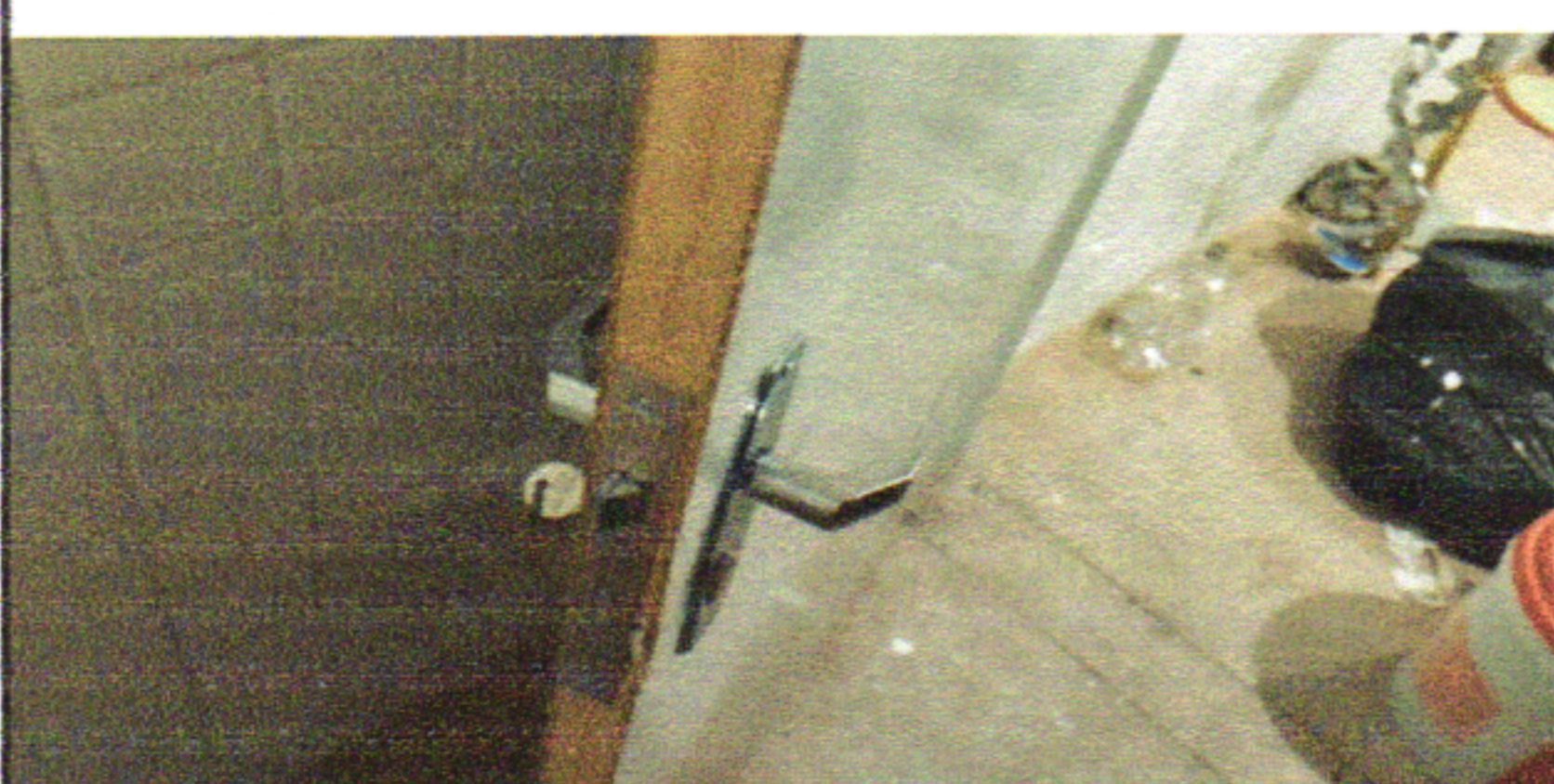
INSTALAÇÃO DE FECHADURAS EXTERNA
