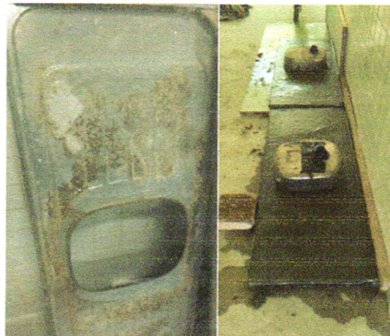
REMOÇÃO DA PIA DE INOX DA COZINHA PARA REALIZAR A CONCRETAGEM
