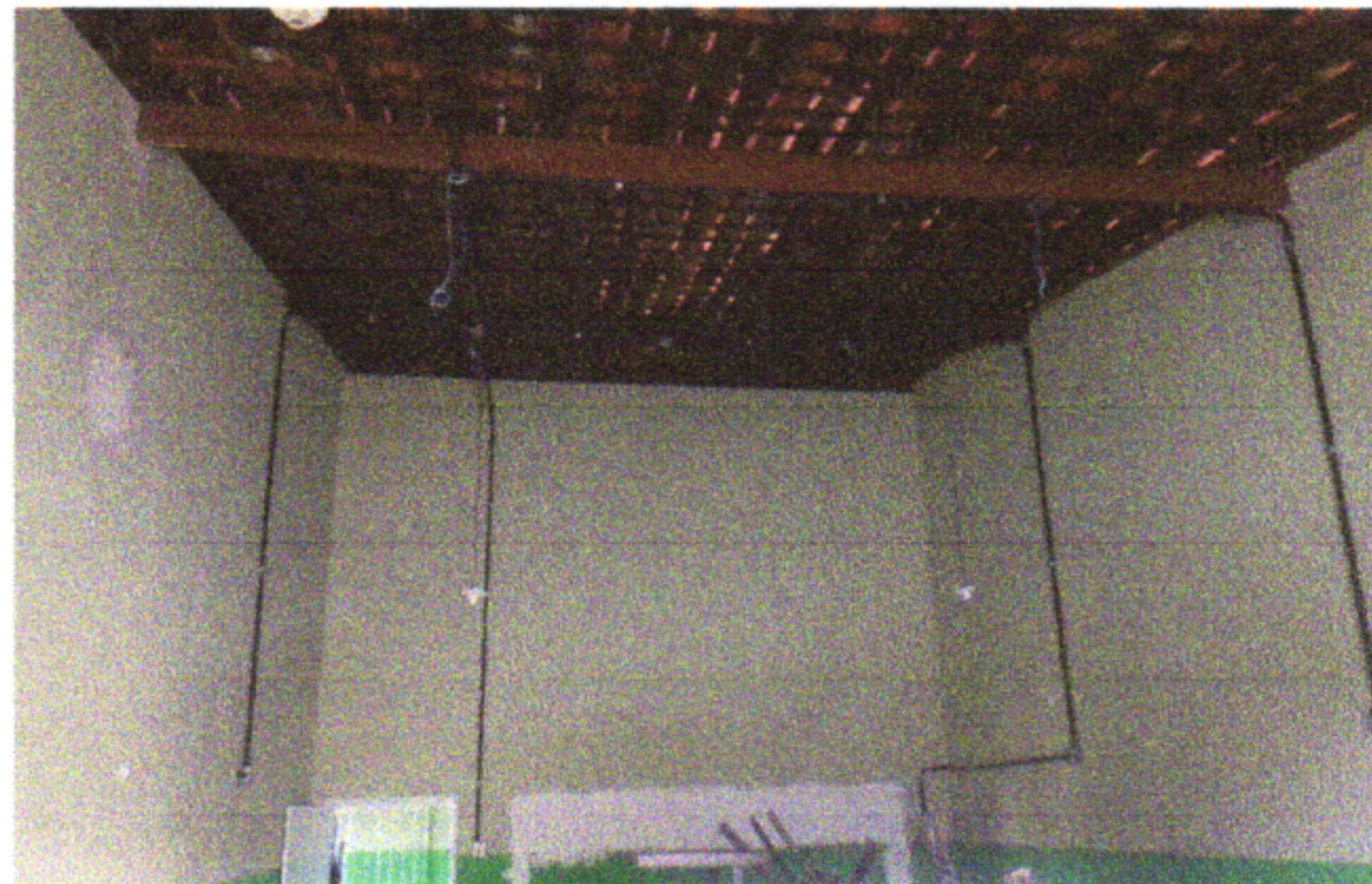
RETELHAMENTO DO PRÉDIO
