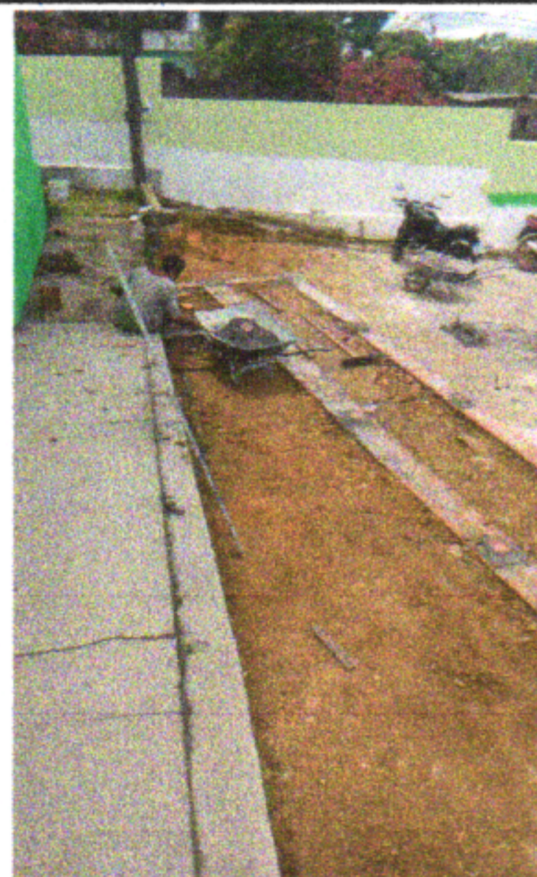
REMOÇÃO DO GUARDA CORPO
