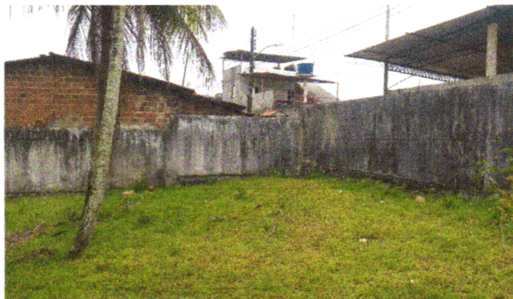
EXECUTAR PINTURA EXTERNA - MURO
