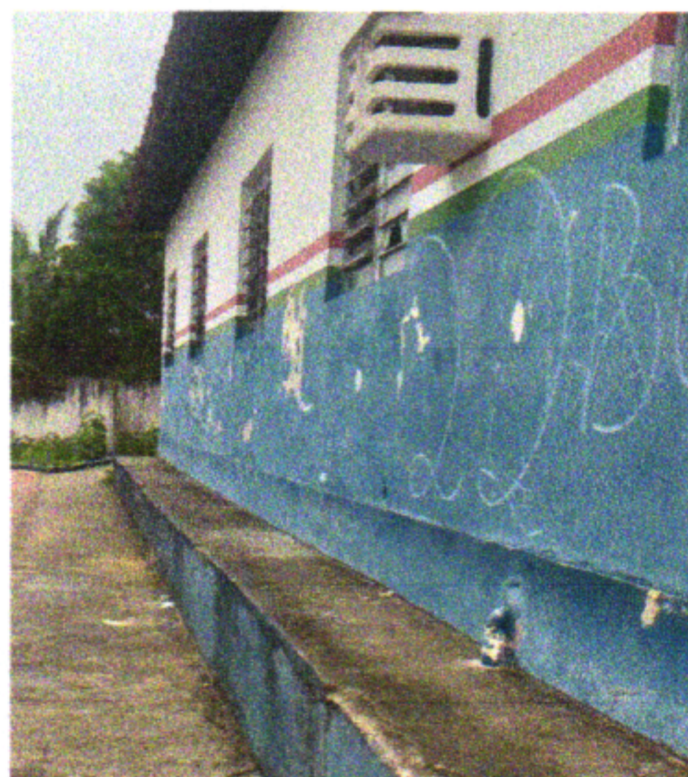
EXECUTAR PINTURA EXTERNA E EMASSAMENTO - FACHADA
