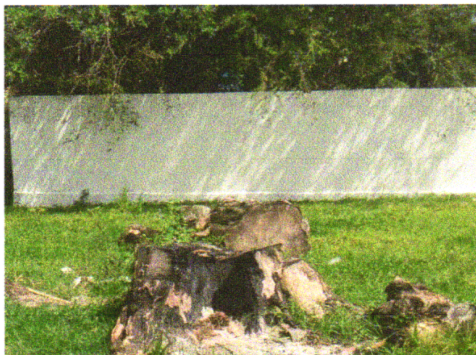
EXECUÇÃO DE PINTURA EXTERNA - MURO
