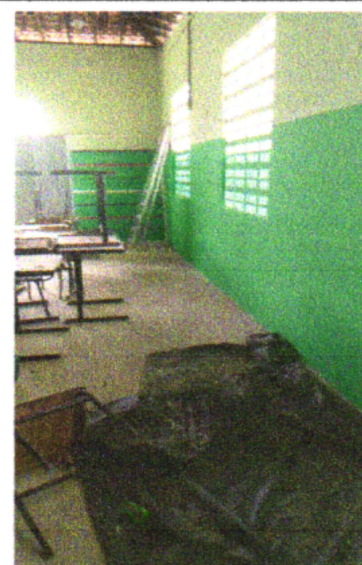
EXECUÇÃO DE PINTURA INTERNA - SALA DE AULA
