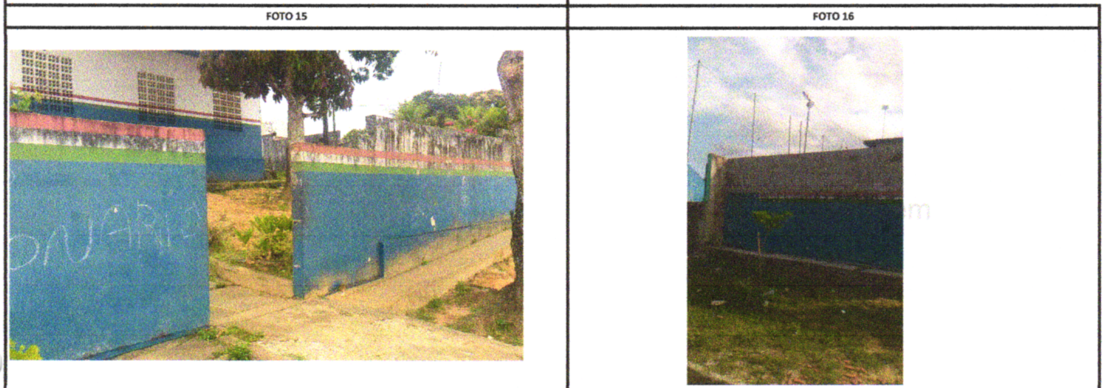
EXECUTAR ALVENARIA DO MURO, INCLUSO CHAPISCO E MASSA ÚNICA
