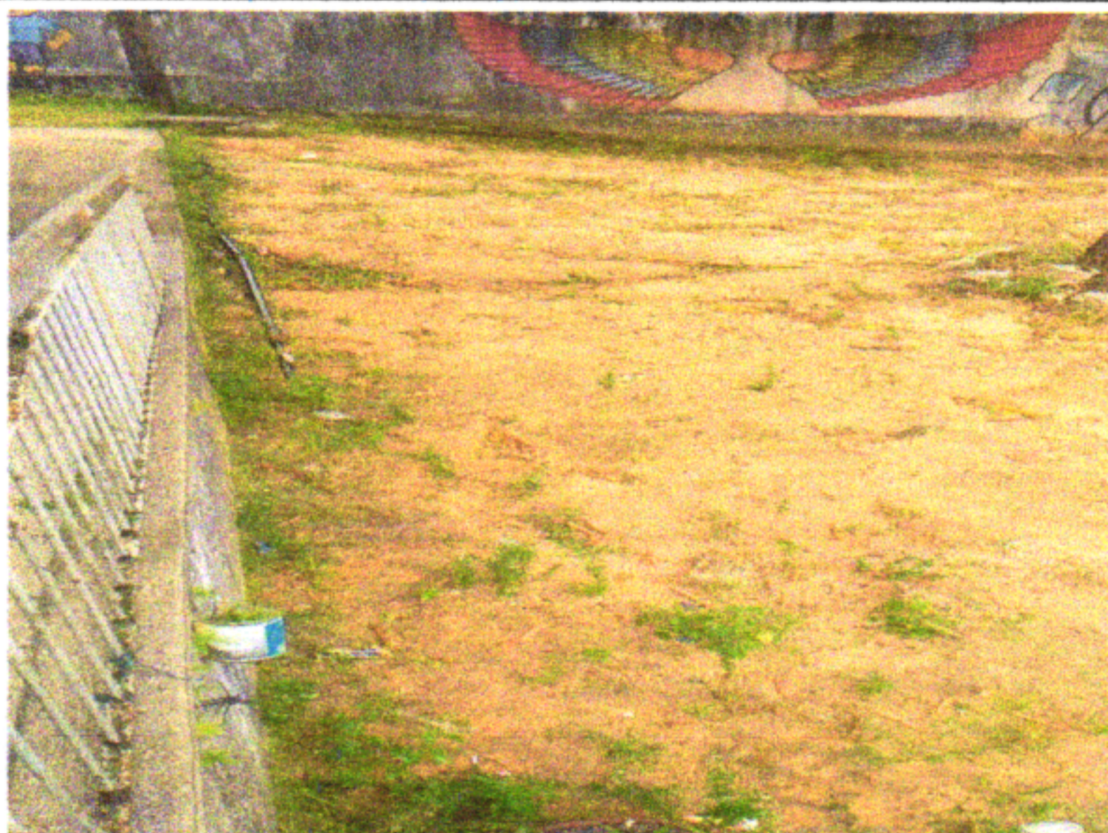
EXECUTAR A ESCAVAÇÃO, REATERRO E LASTRO DE CONCRETO
