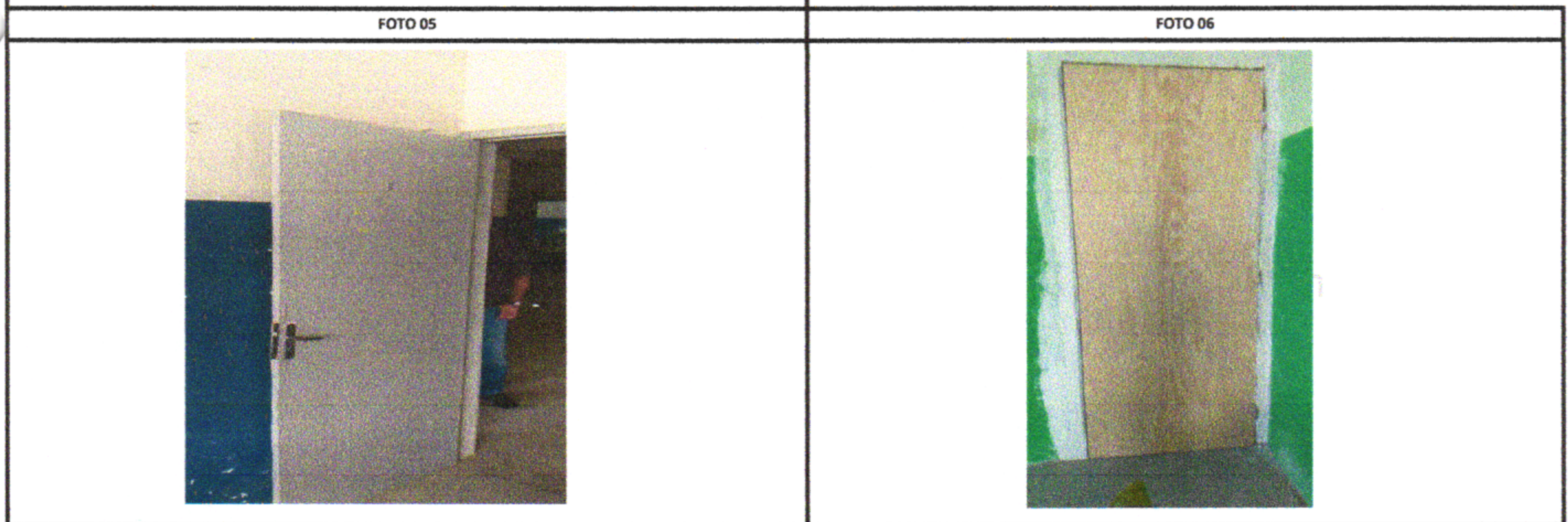
REMOVER PORTA E PINTURA
