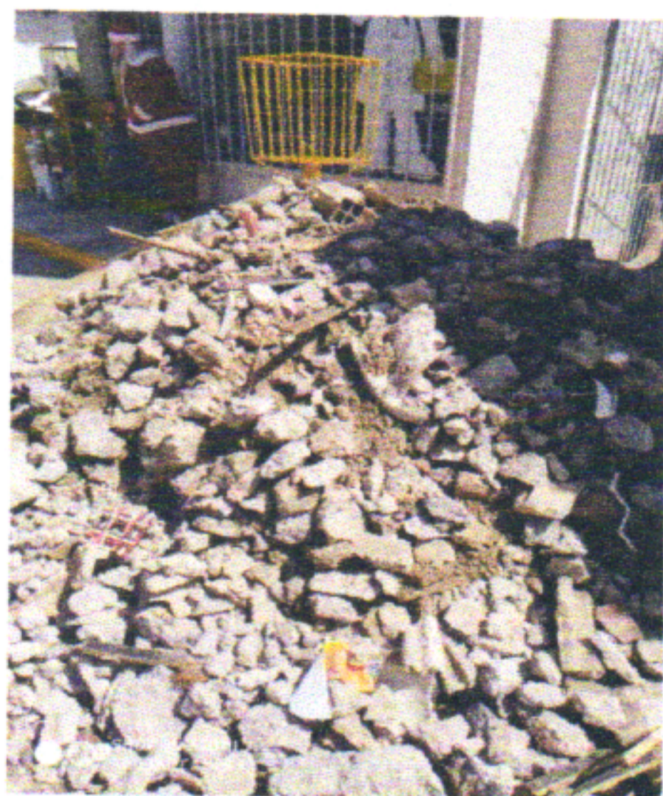
ENTULHO DAS DEMOLIÇÕES
