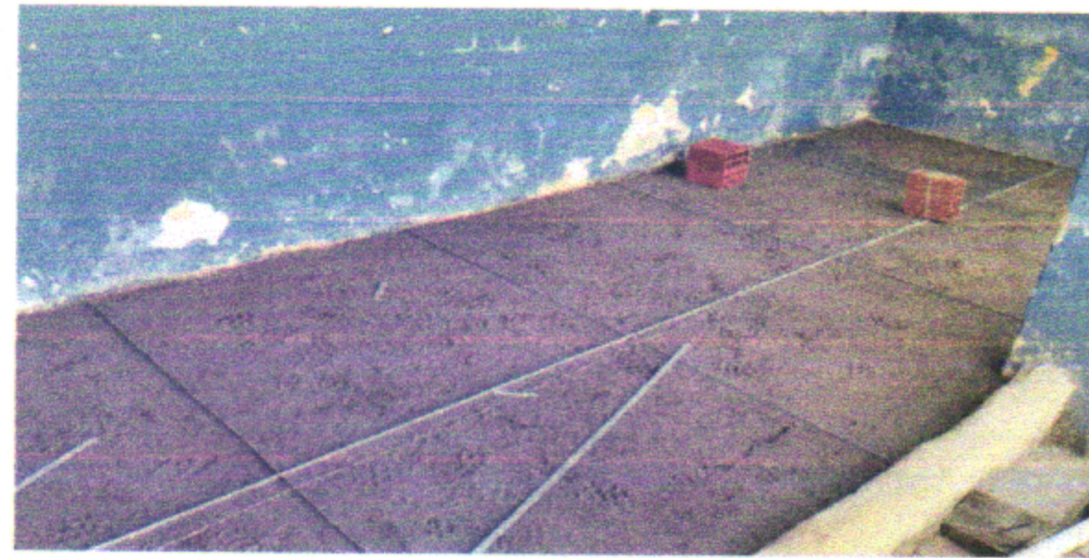
APLICAÇÃO DO PISO CIMENTADO PARA APLICAÇÃO DO PISO EM GRANILITE
