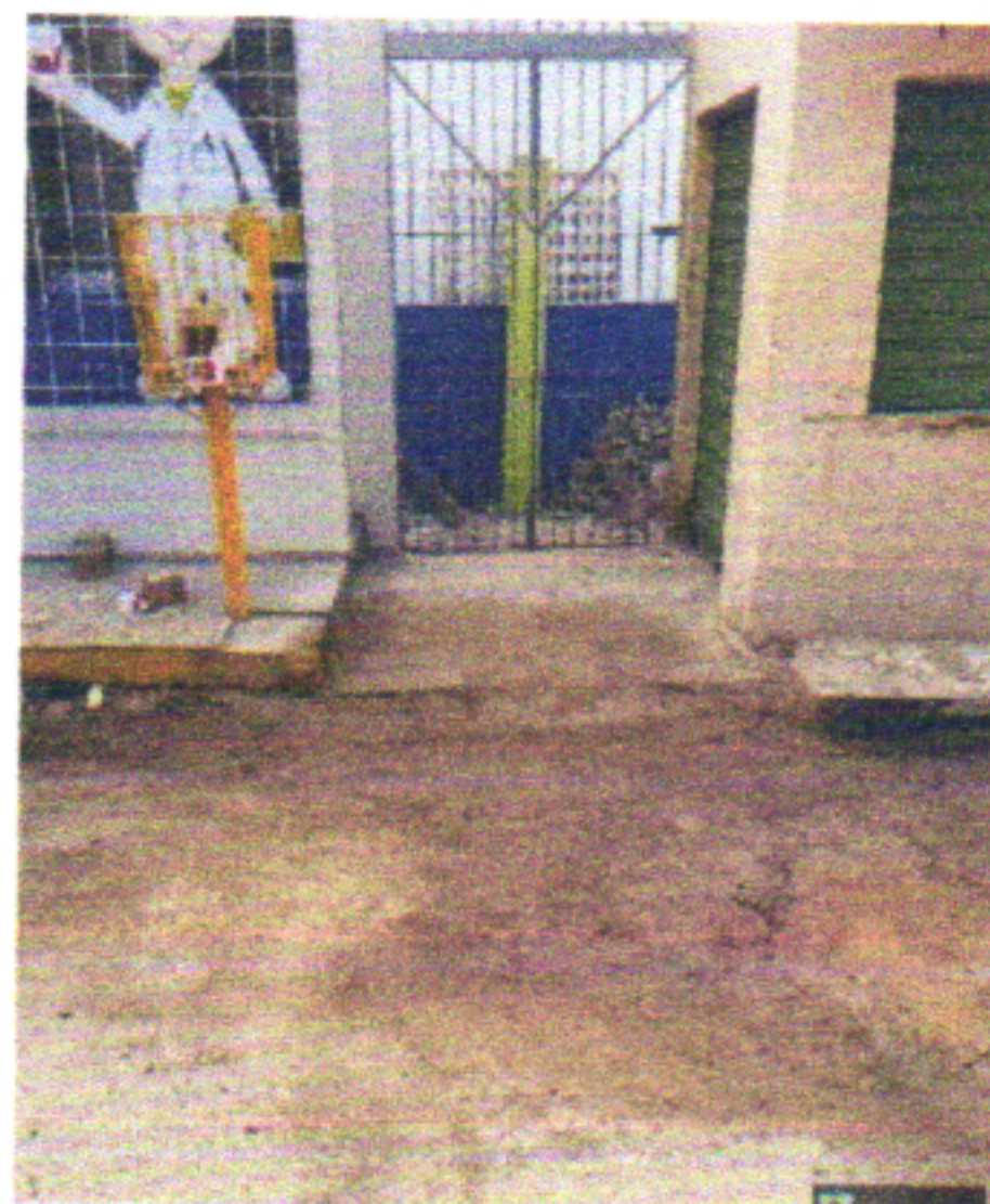
REMOÇÃO DOS ENTULHOS
