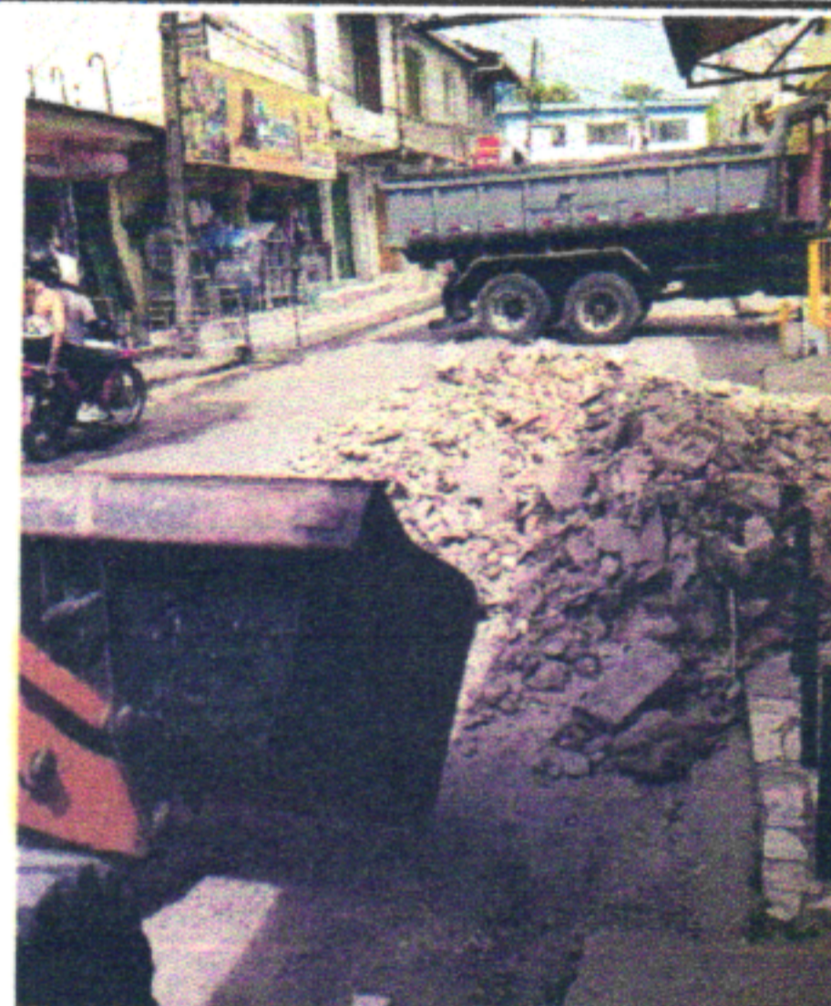
REMOÇÃO DOS ENTULHOS EM CAMINHÃO BASCULANTE
