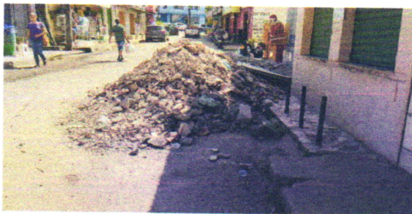
ENTULHO DAS DEMOLIÇÕES
