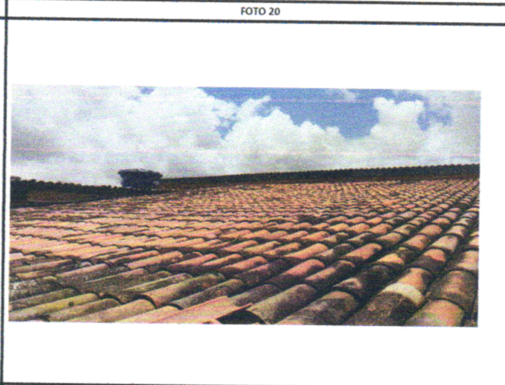
RETELHAMENTO COM TELHA CERÂMICA TIPO CANAL
