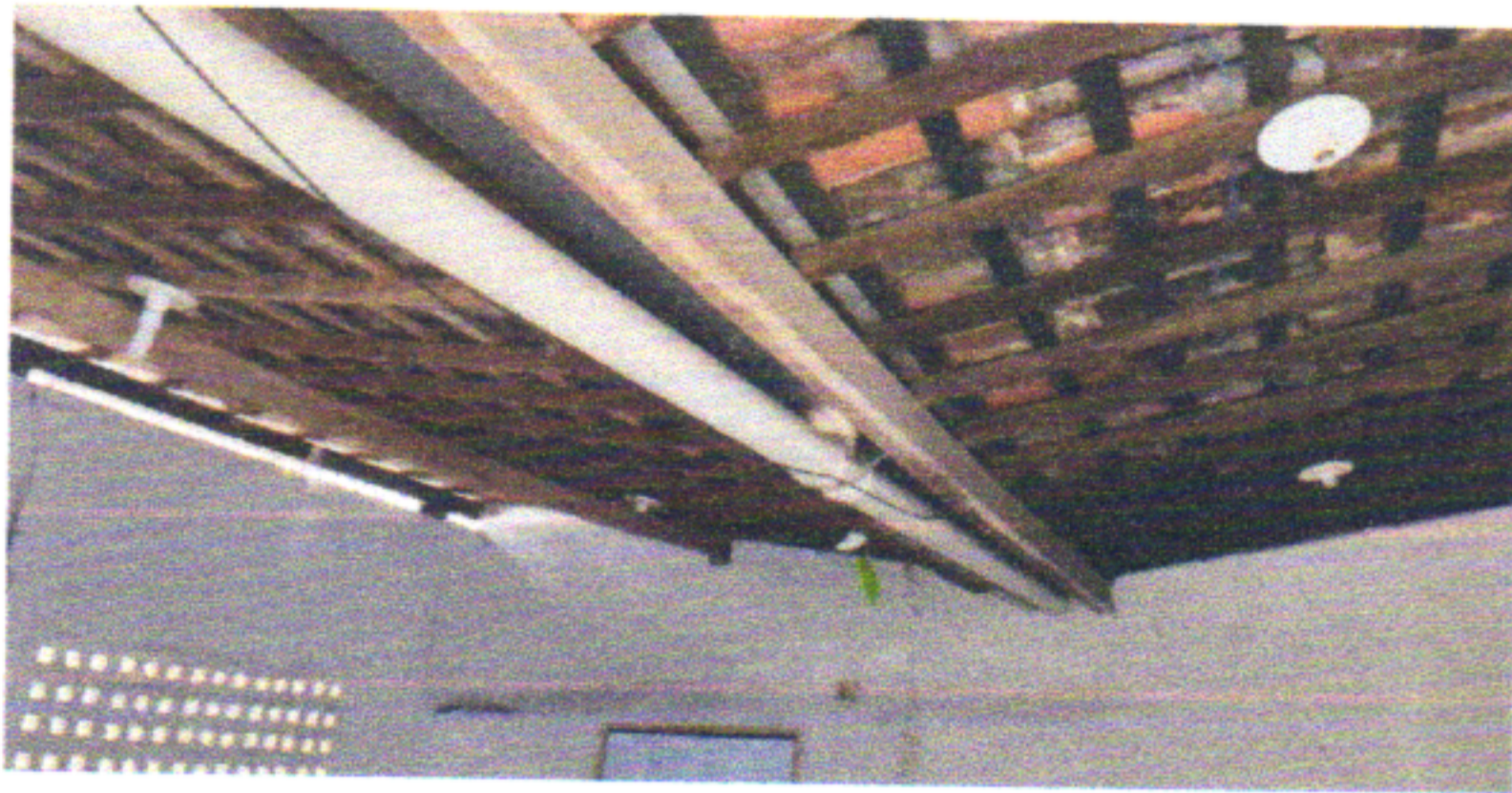
ANTES DA REMOÇÃO DE TELHAS CERÂMICAS TIPO CANAL, TRAMA DE MADEIRA, LUMINÁRIA E CALHA
