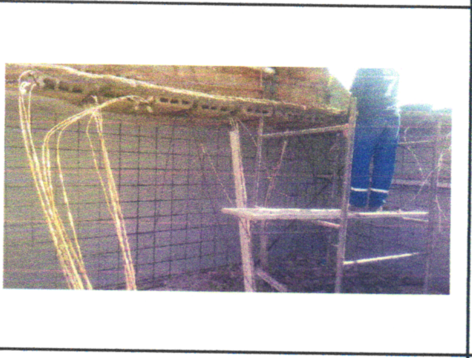
DEMOLIÇÃO DA LAJE DA DIRETORIA
