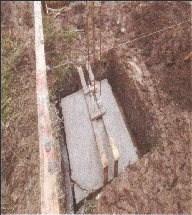
EXECUÇÃO DE ESTRUTURAS DE CONCRETO ARMADO
