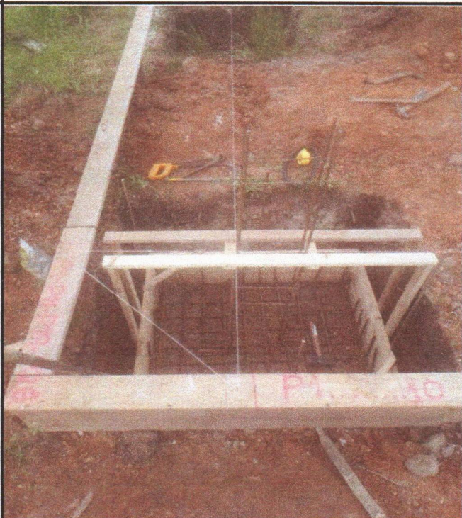
EXECUÇÃO DE ESTRUTURAS DE CONCRETO ARMADO
