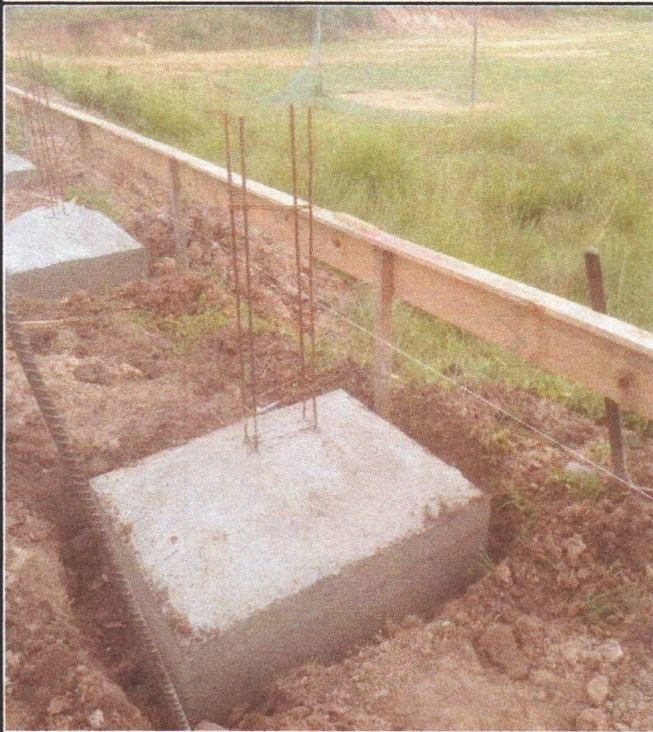
EXECUÇÃO DE ESTRUTURAS DE CONCRETO ARMADO
