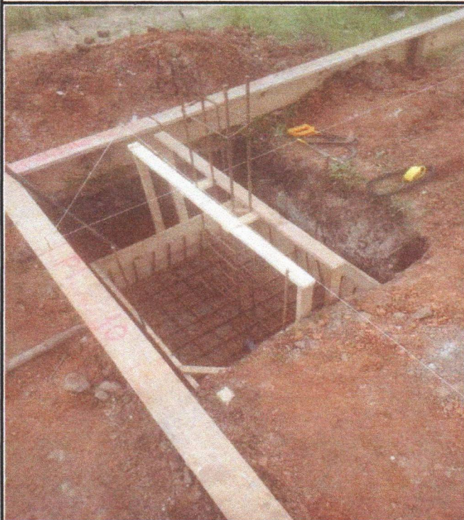
EXECUÇÃO DE ESTRUTURAS DE CONCRETO ARMADO
