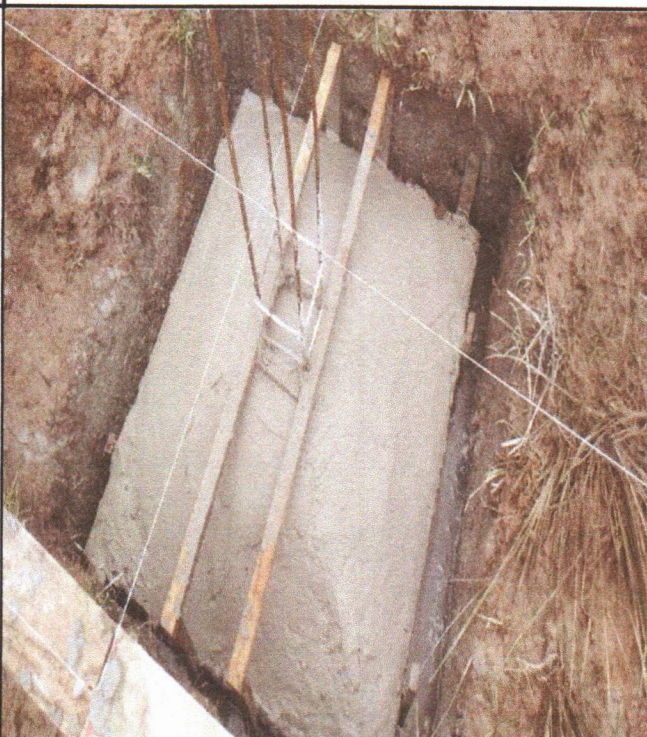
EXECUÇÃO DE ESTRUTURAS DE CONCRETO ARMADO
