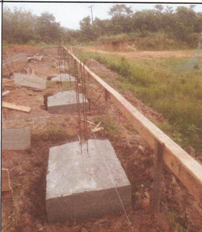
EXECUÇÃO DE ESTRUTURAS DE CONCRETO ARMADO
