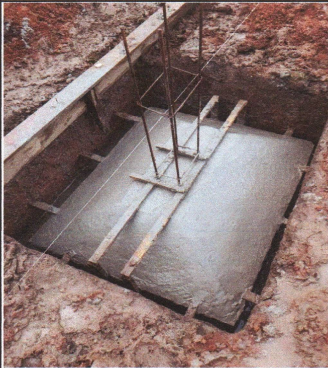
EXECUÇÃO DE ESTRUTURAS DE CONCRETO ARMADO
