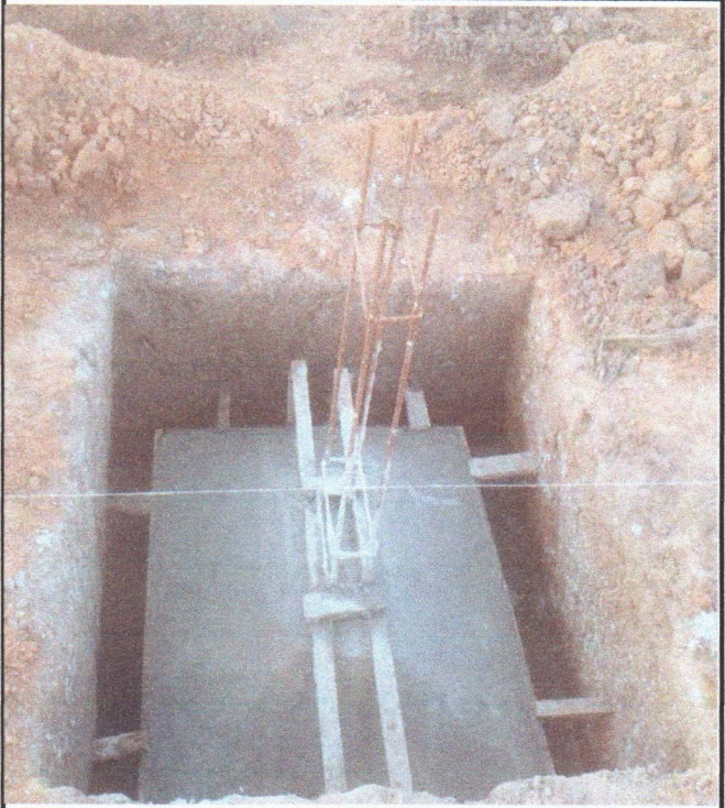
EXECUÇÃO DE ESTRUTURAS DE CONCRETO ARMADO
