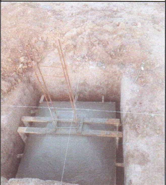
EXECUÇÃO DE ESTRUTURAS DE CONCRETO ARMADO
