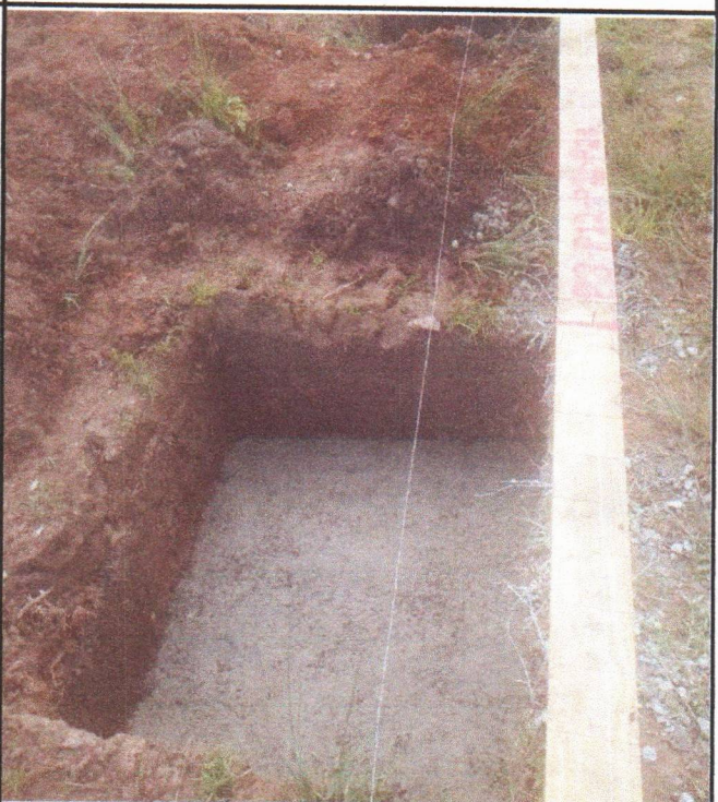
LASTRO DE CONCRETO MAGRO, APLICADO EM BLOCOS DE COROAMENTO OU SAPATAS
