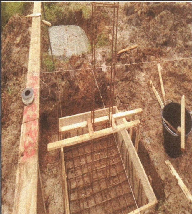
EXECUÇÃO DE ESTRUTURAS DE CONCRETO ARMADO
