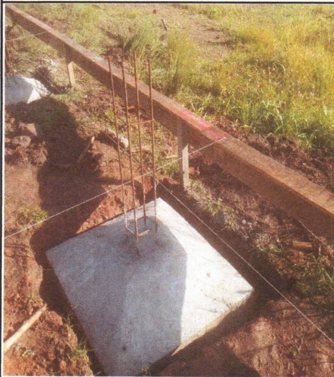
EXECUÇÃO DE ESTRUTURAS DE CONCRETO ARMADO
