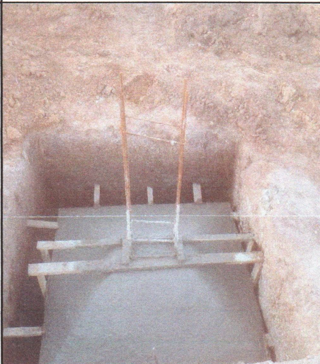
EXECUÇÃO DE ESTRUTURAS DE CONCRETO ARMADO
