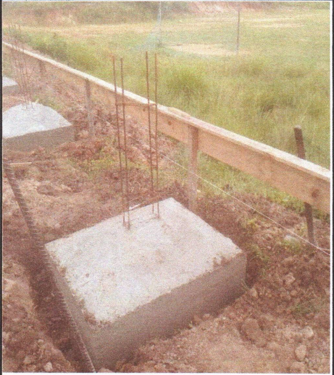
EXECUÇÃO DE ESTRUTURAS DE CONCRETO ARMADO
