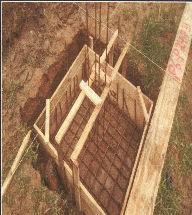
EXECUÇÃO DE ESTRUTURAS DE CONCRETO ARMADO
