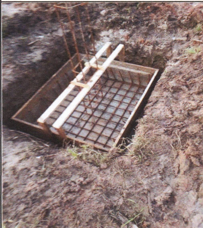
EXECUÇÃO DE ESTRUTURAS DE CONCRETO ARMADO
