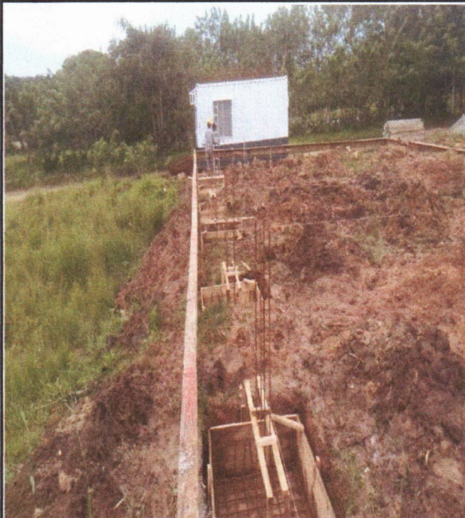
EXECUÇÃO DE ESTRUTURAS DE CONCRETO ARMADO
