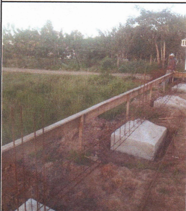
EXECUÇÃO DE ESTRUTURAS DE CONCRETO ARMADO
