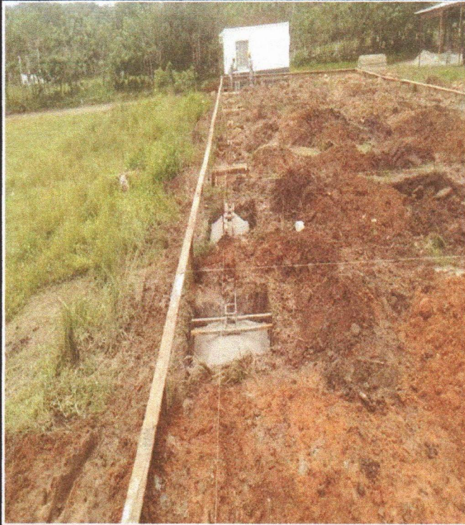
EXECUÇÃO DE ESTRUTURAS DE CONCRETO ARMADO
