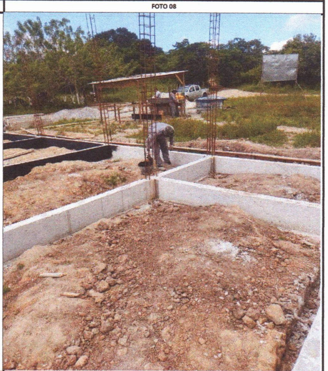
IMPERMEABILIZAÇÃO DE VIGA BALDRAME
