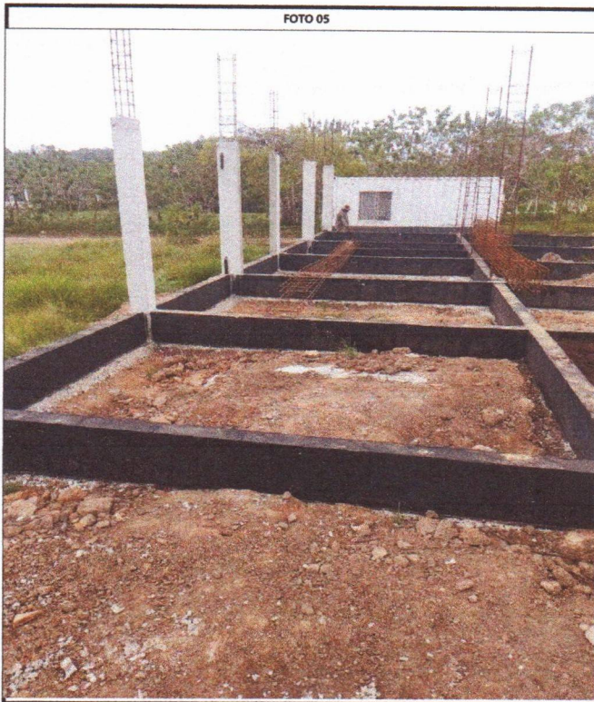
IMPERMEABILIZAÇÃO DE VIGA BALDRAME
