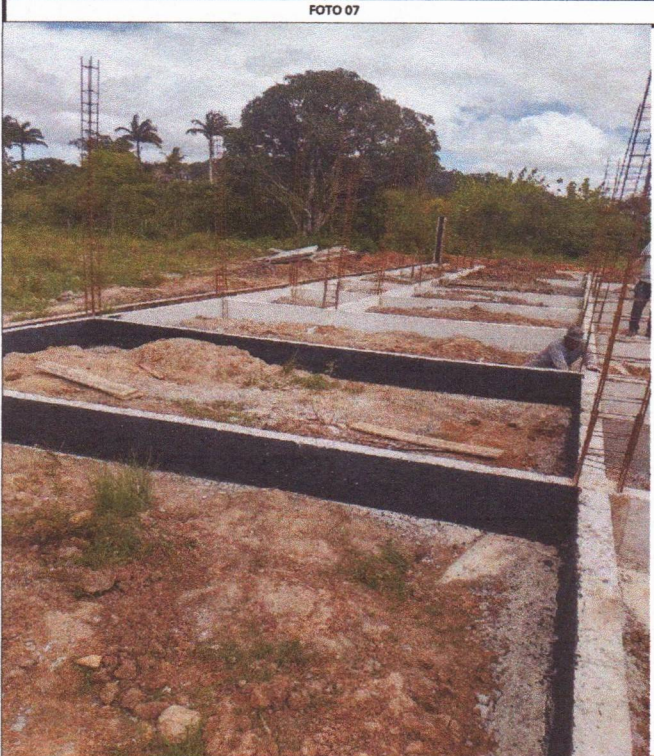
IMPERMEABILIZAÇÃO DE VIGA BALDRAME
