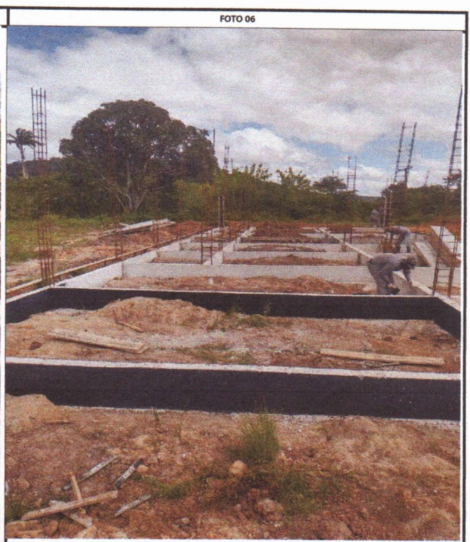
IMPERMEABILIZAÇÃO DE VIGA BALDRAME
