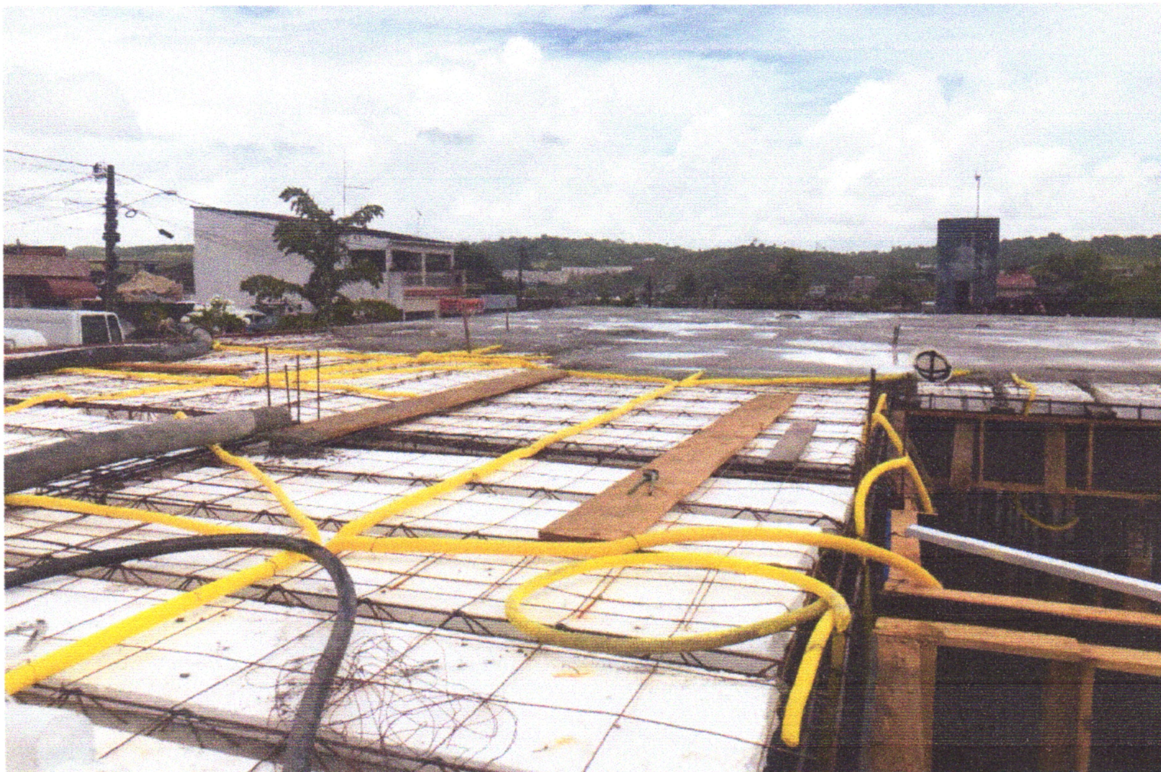
FOTO 10 (CONCRETAGEM DE VIGAS E LAJE)
