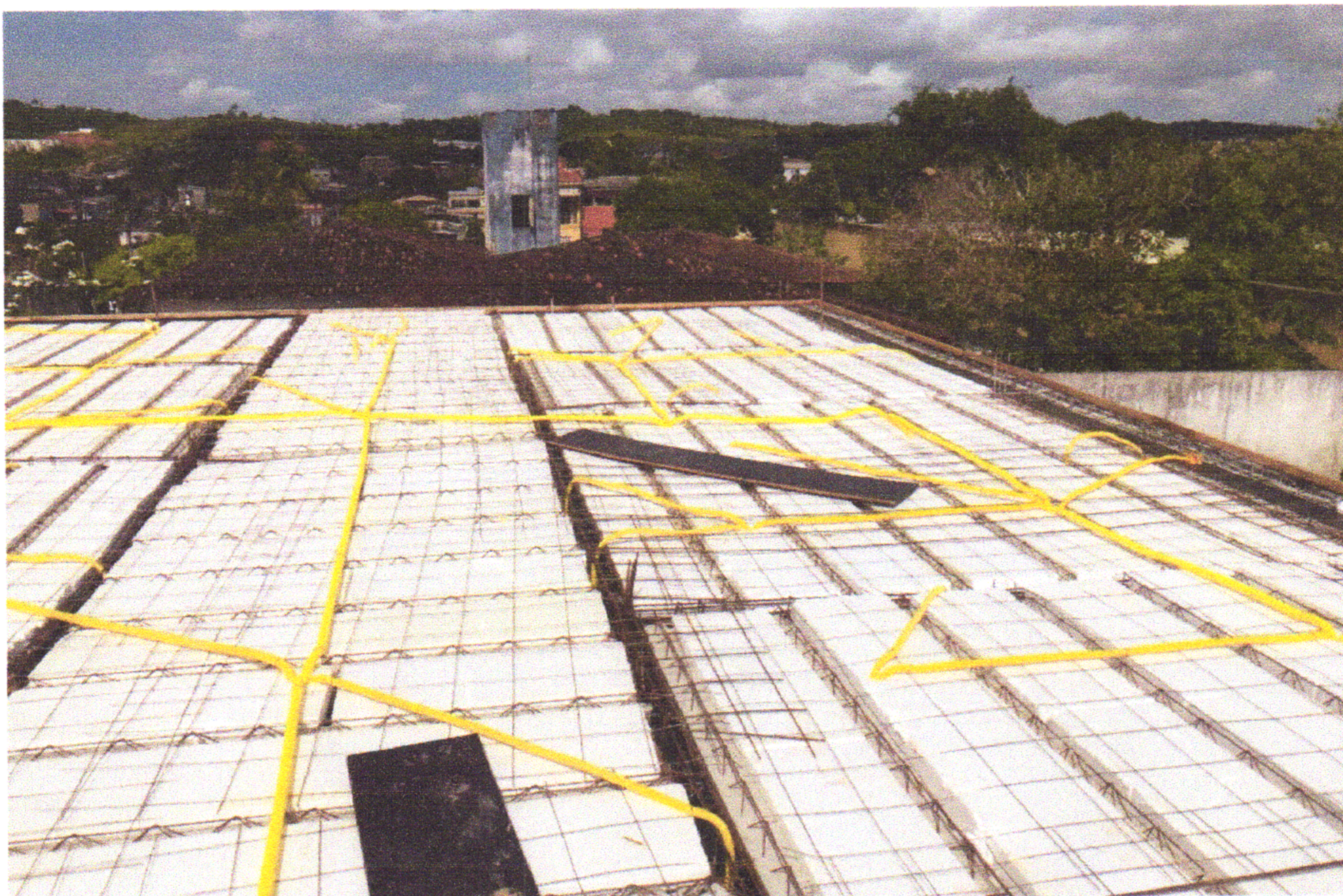
FOTO 04 (ARMAÇÃO DE VIGAS E LAJE E INSTALAÇÃO DOS ELETRODUTOS)
