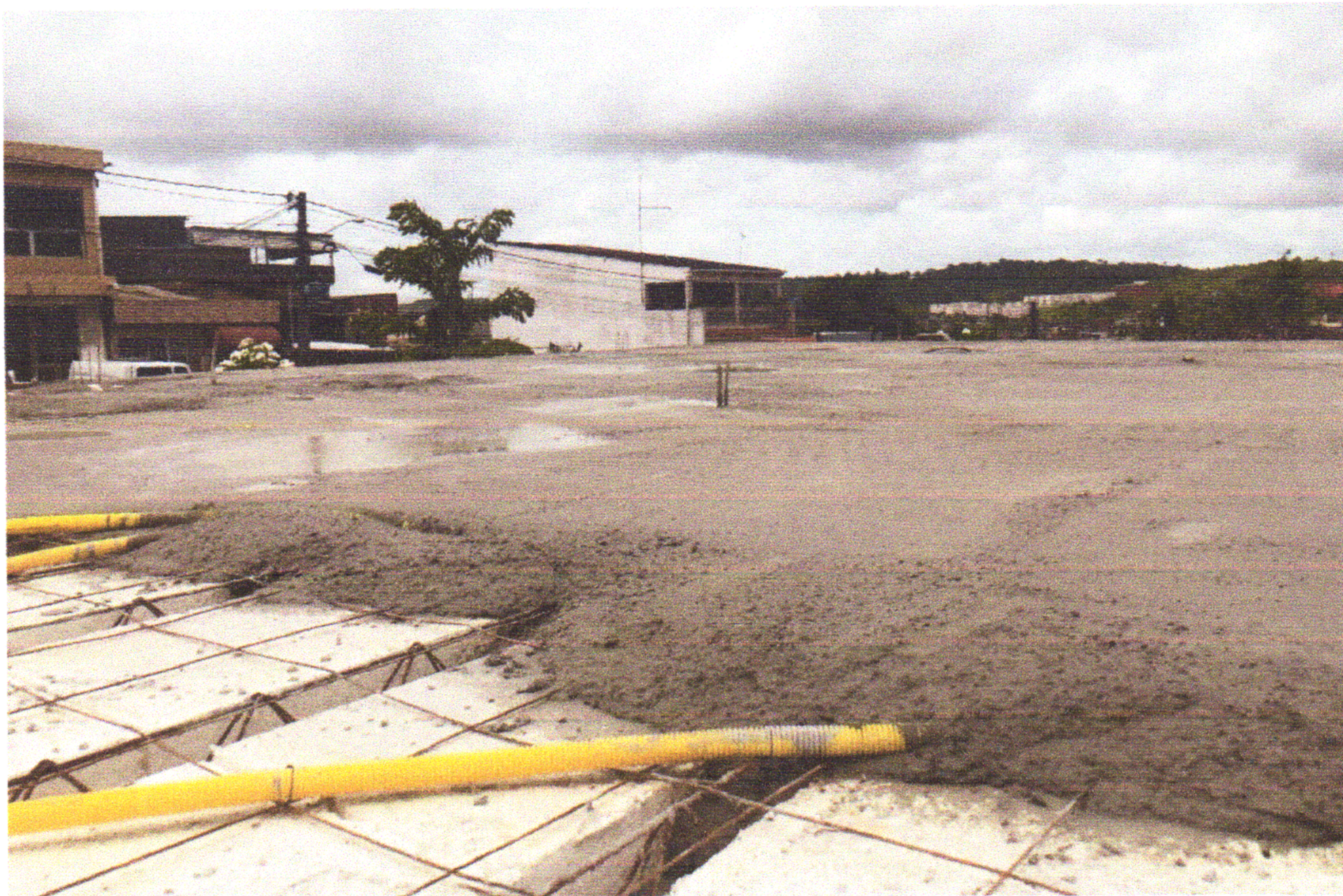
FOTO 12 (CONCRETAGEM DE VIGAS E LAJE)
