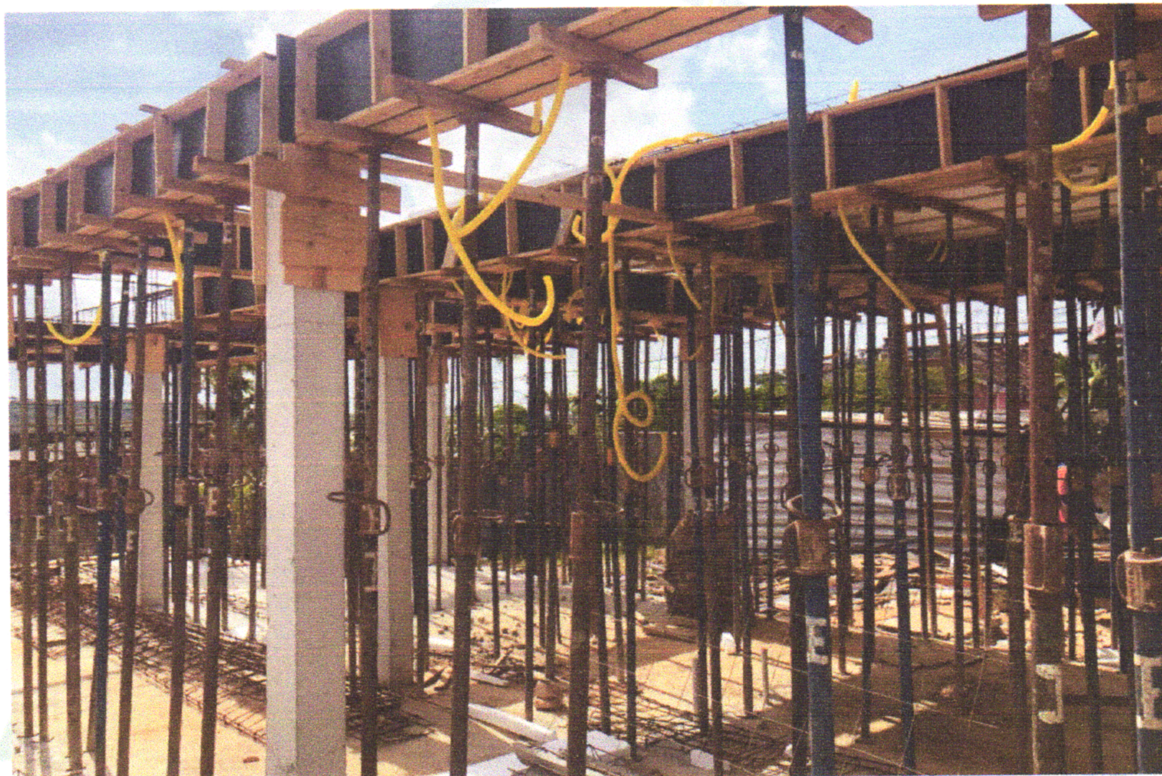
FOTO 01 (ESCORAMENTO E FÔRMA DAS VIGAS E LAJE E INSTALAÇÃO DOS ELETRODUTOS)
