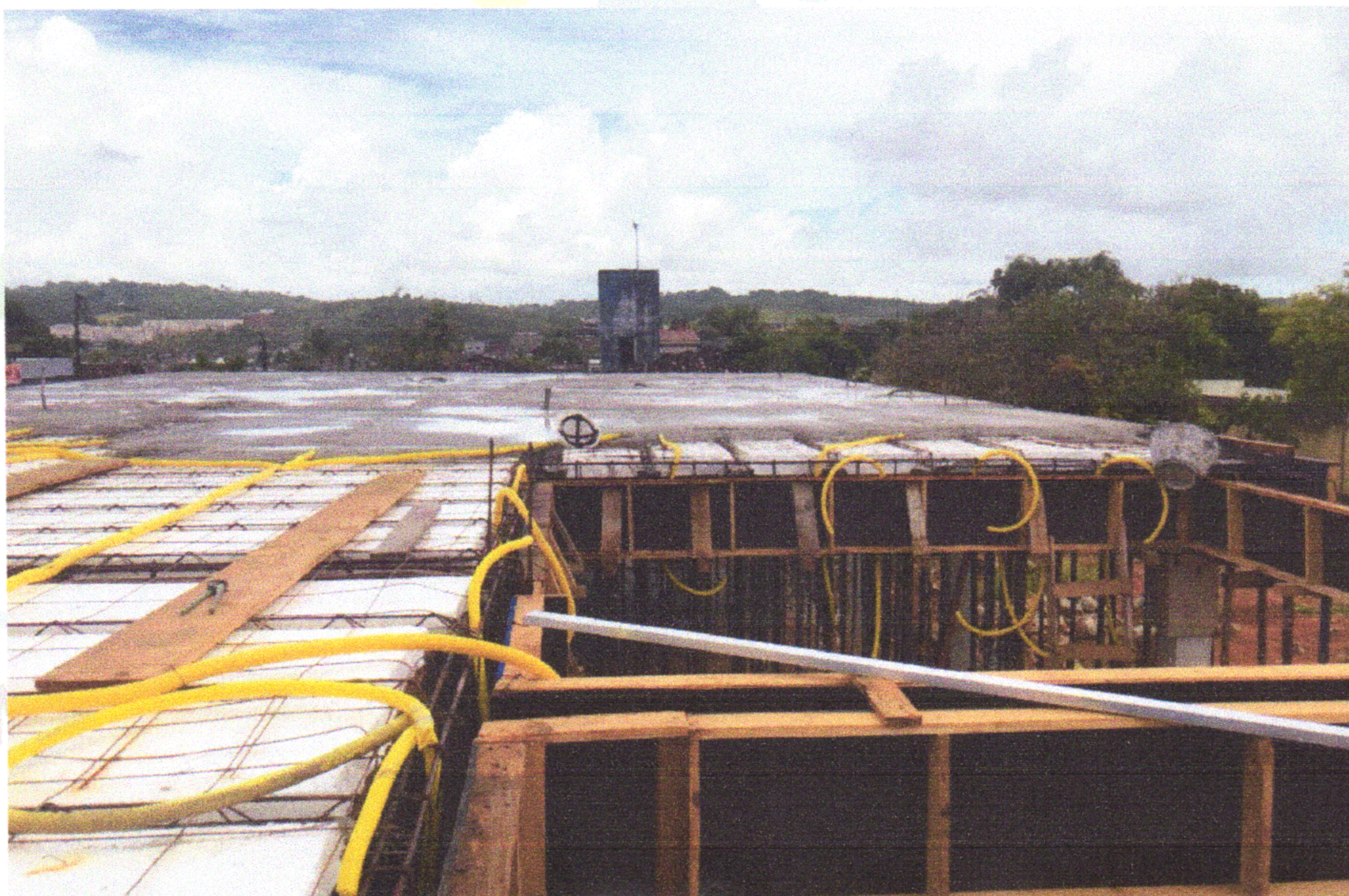
FOTO 09 (CONCRETAGEM DE VIGAS E LAJE)
