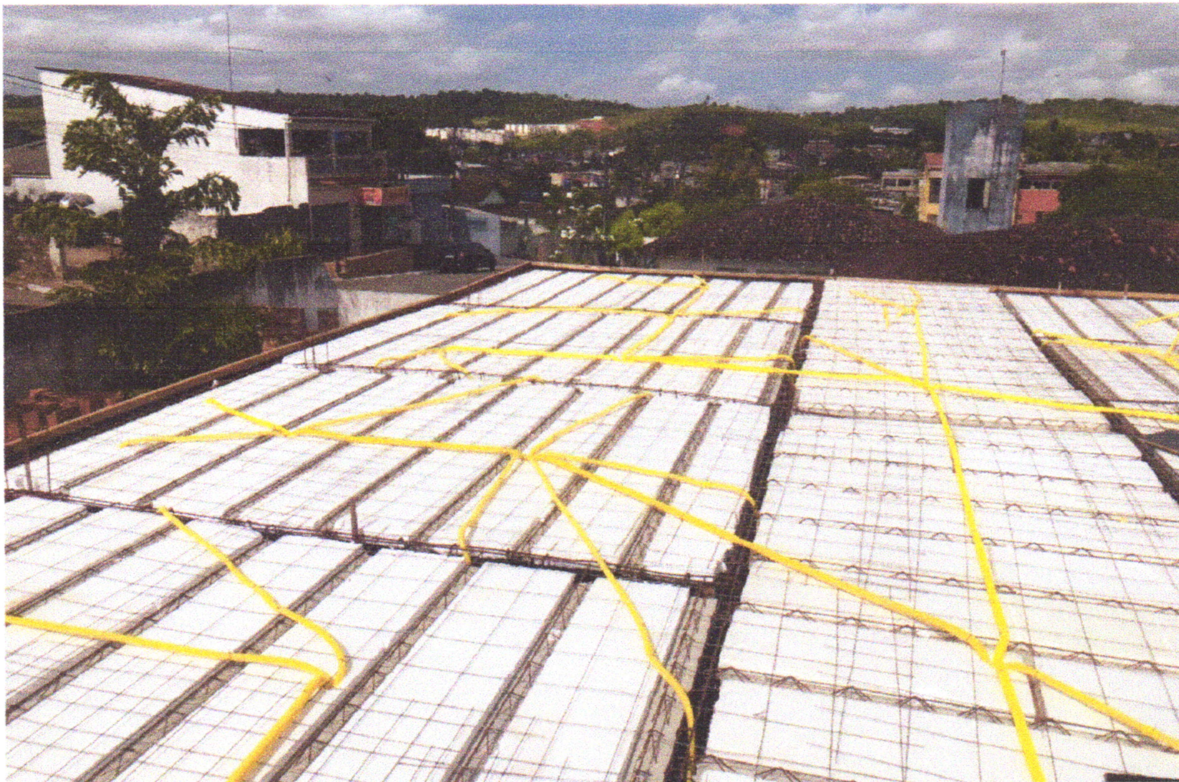
FOTO 06 (ARMAÇÃO DE VIGAS E LAJE E INSTALAÇÃO DOS ELETRODUTOS)
