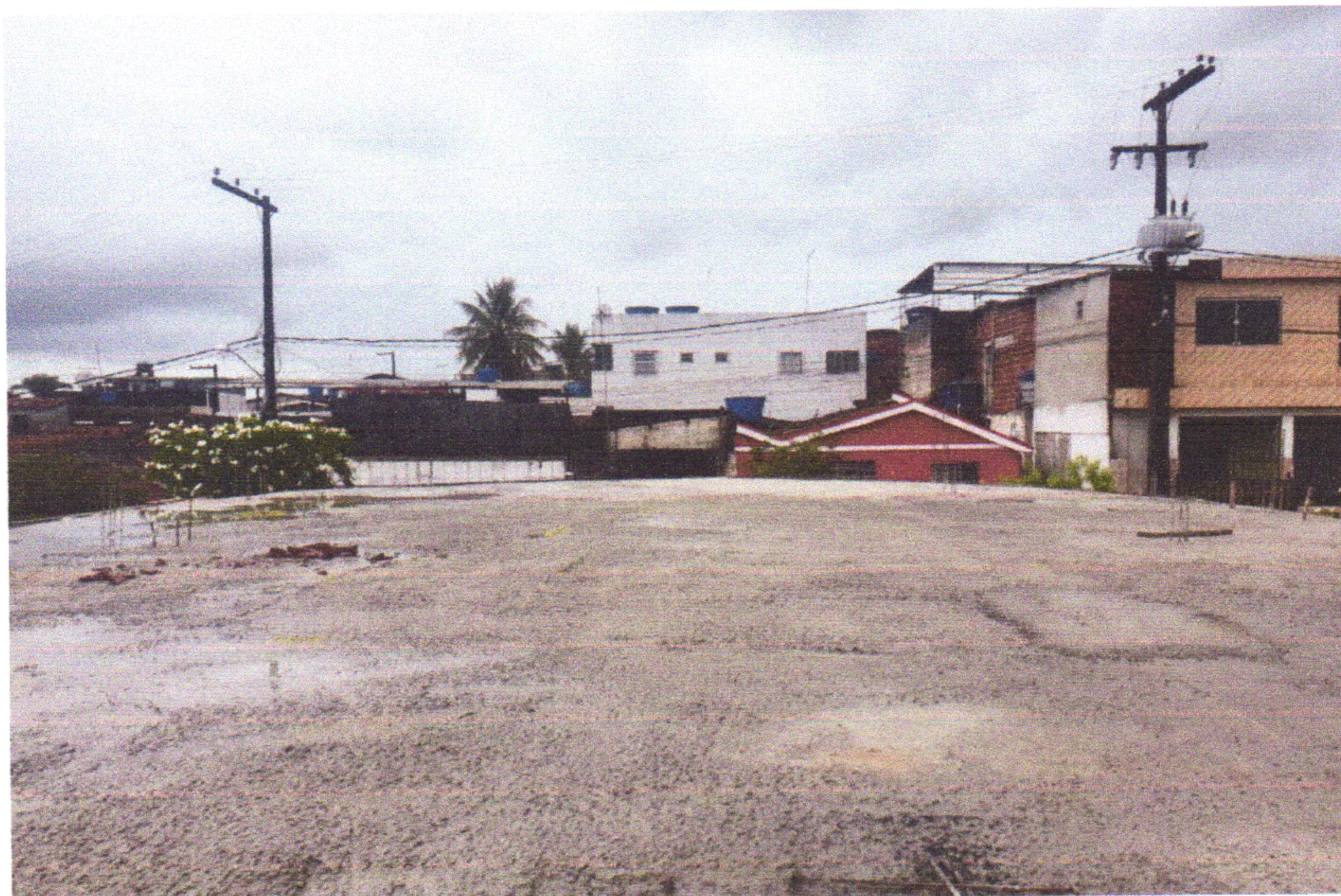
FOTO 16 (CONCRETAGEM DE VIGAS E LAJE)
