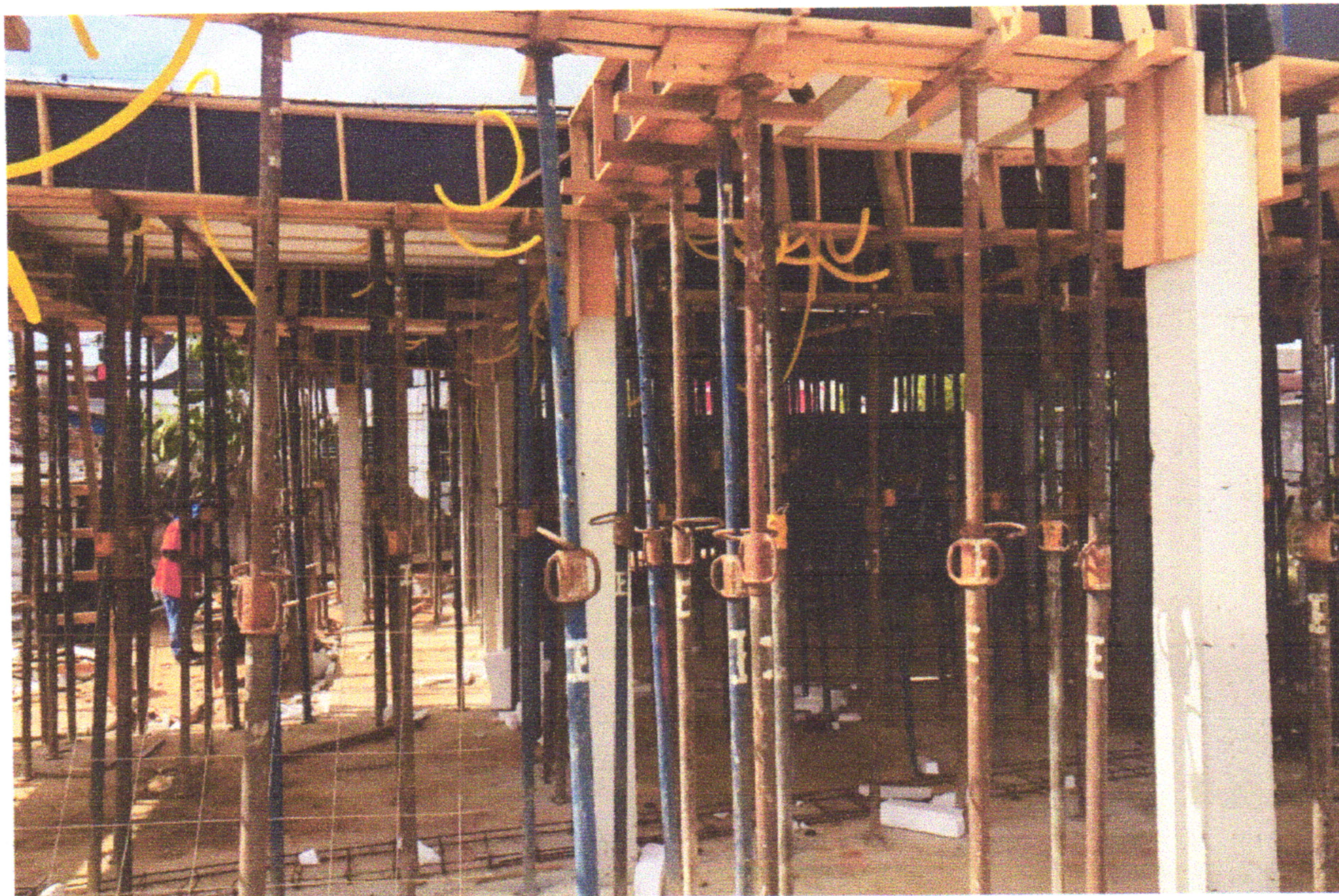
FOTO 02 (ESCORAMENTO E FÔRMA DAS VIGAS E LAJE E INSTALAÇÃO DOS ELETRODUTOS)
