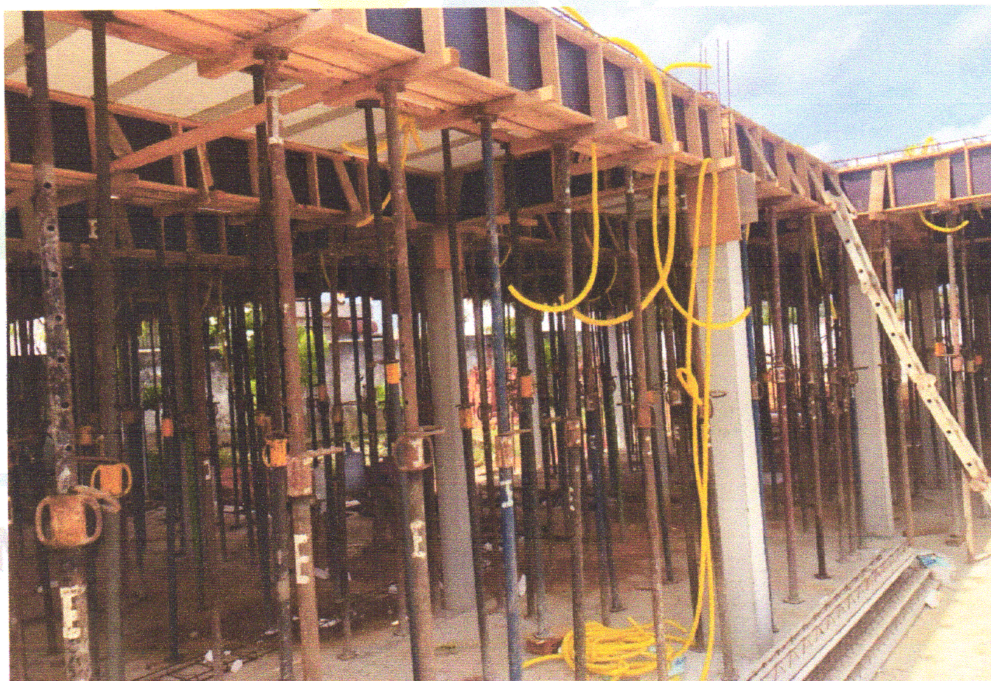
FOTO 03 (ESCORAMENTO E FÔRMA DAS VIGAS E LAJE E INSTALAÇÃO DOS ELETRODUTOS)
