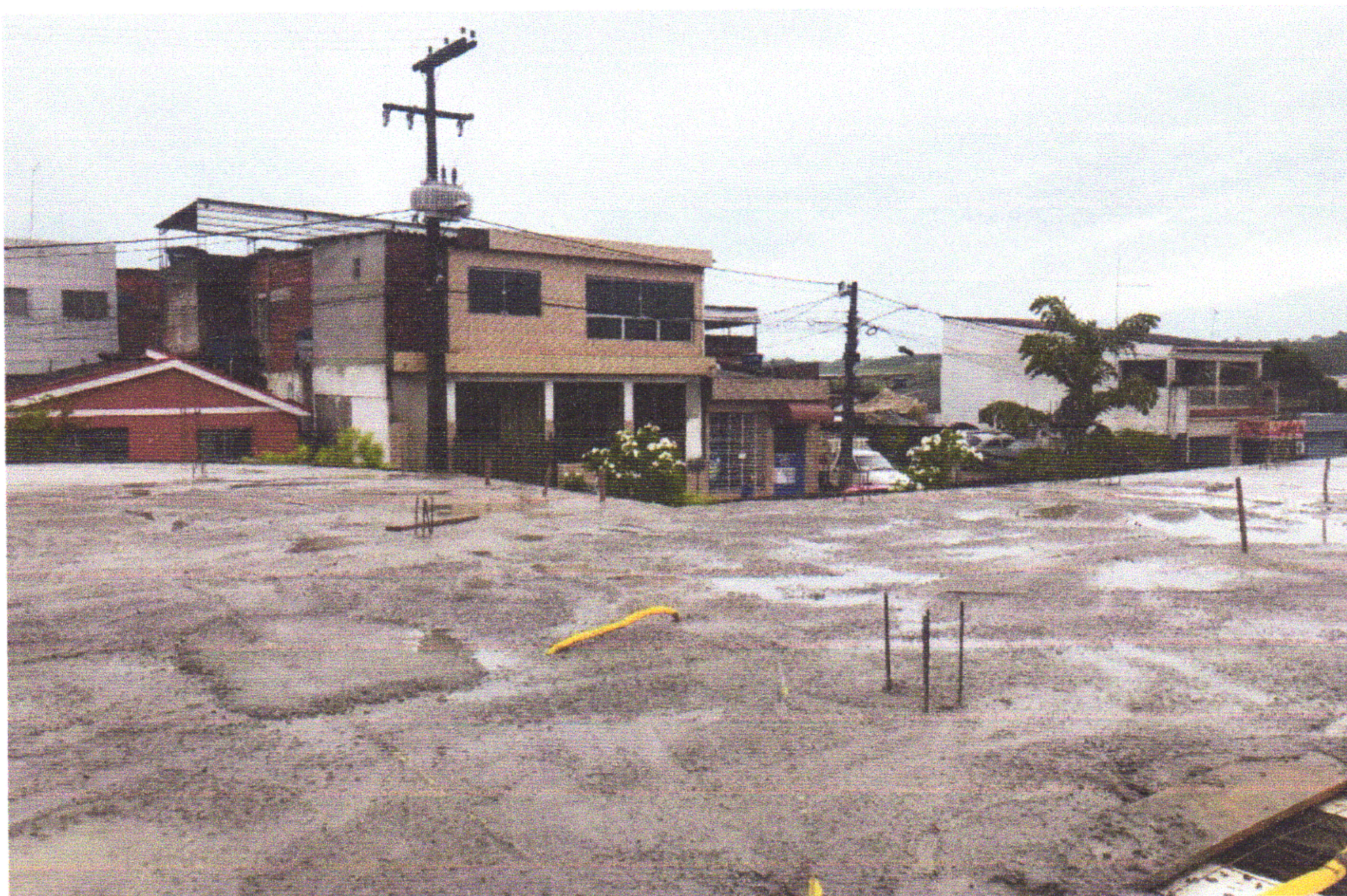
FOTO 14 (CONCRETAGEM DE VIGAS E LAJE)
