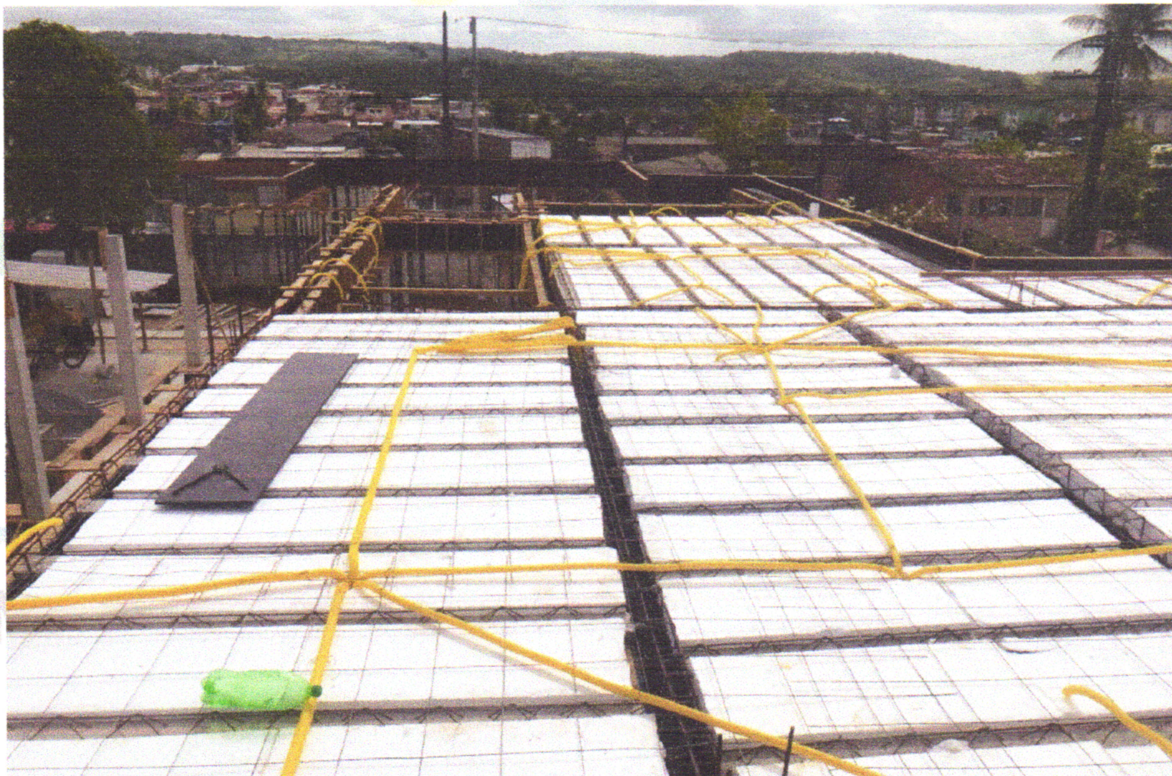
FOTO 07 (ARMAÇÃO DE VIGAS E LAJE E INSTALAÇÃO DOS ELETRODUTOS)
