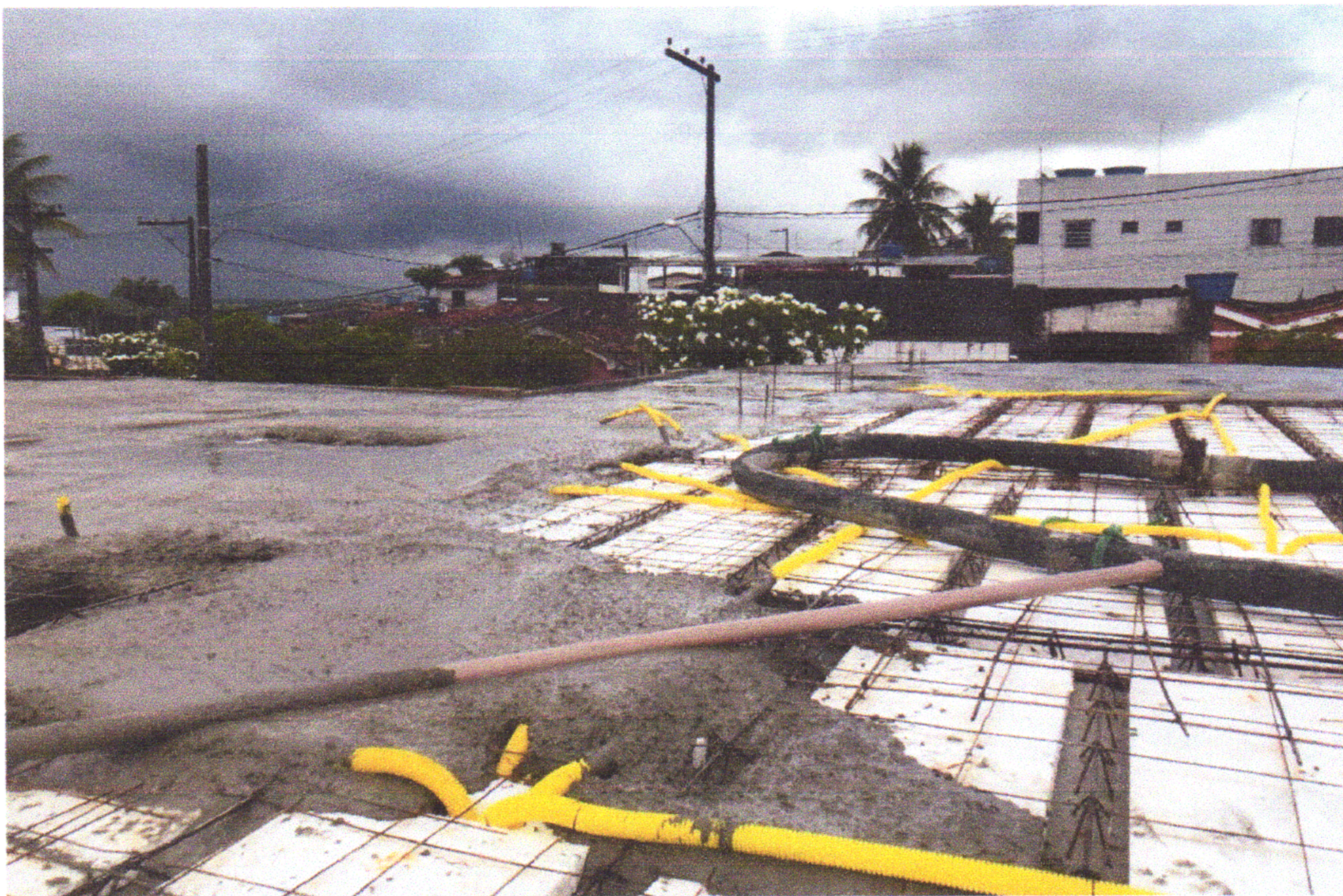
FOTO 08 (CONCRETAGEM DE VIGAS E LAJE)
