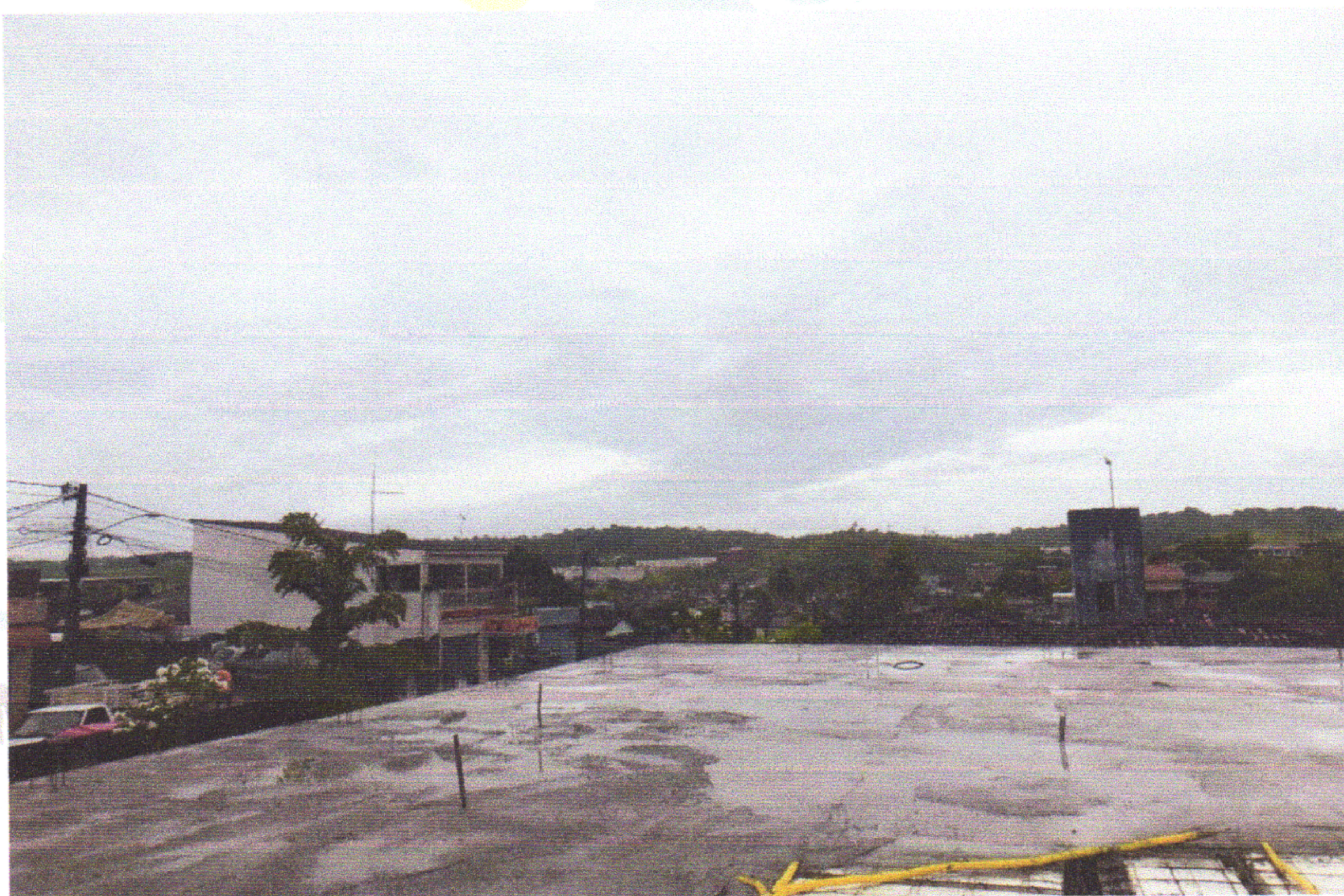
FOTO 15 (CONCRETAGEM DE VIGAS E LAJE)
