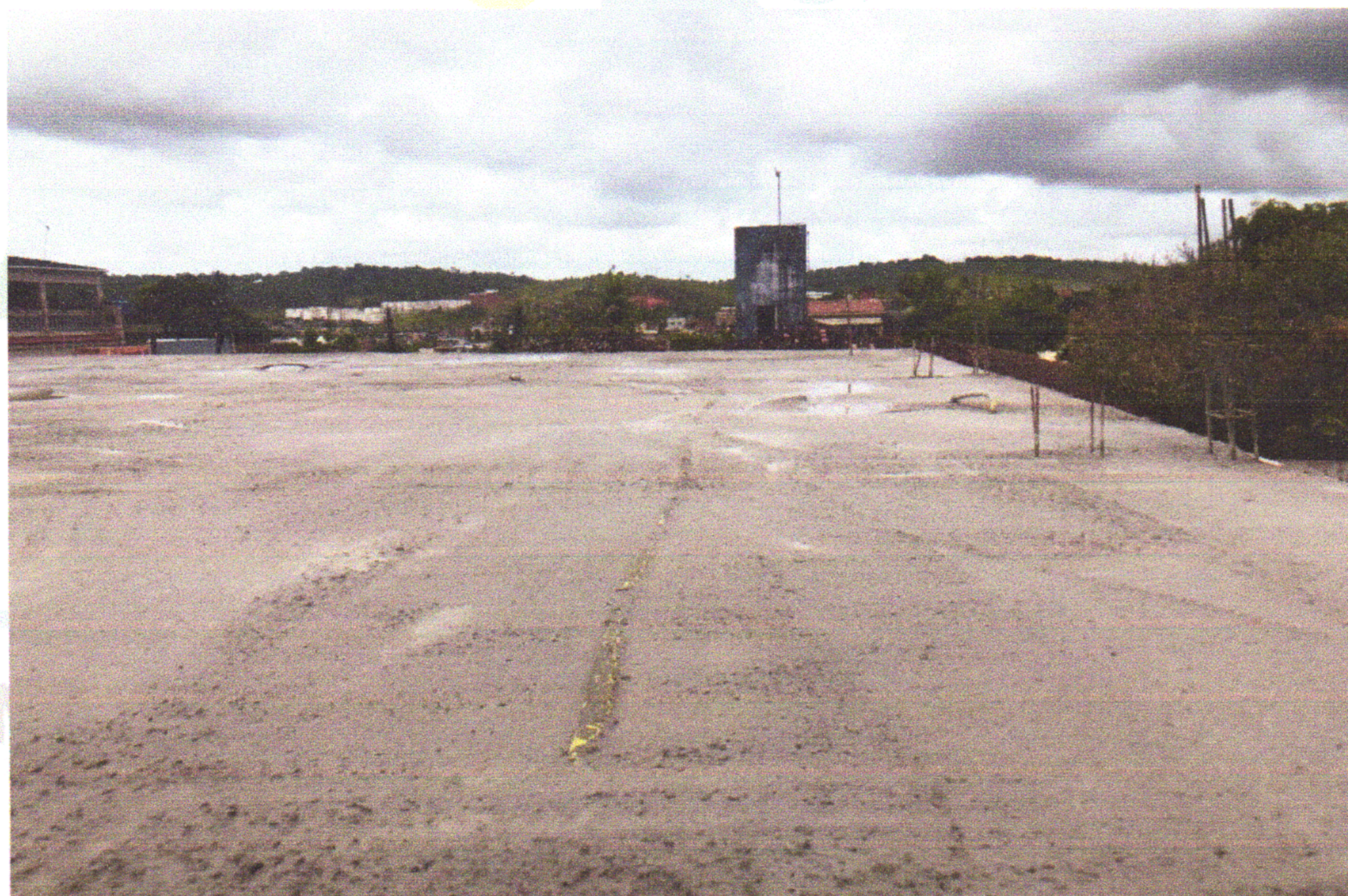
FOTO 11 (CONCRETAGEM DE VIGAS E LAJE)
