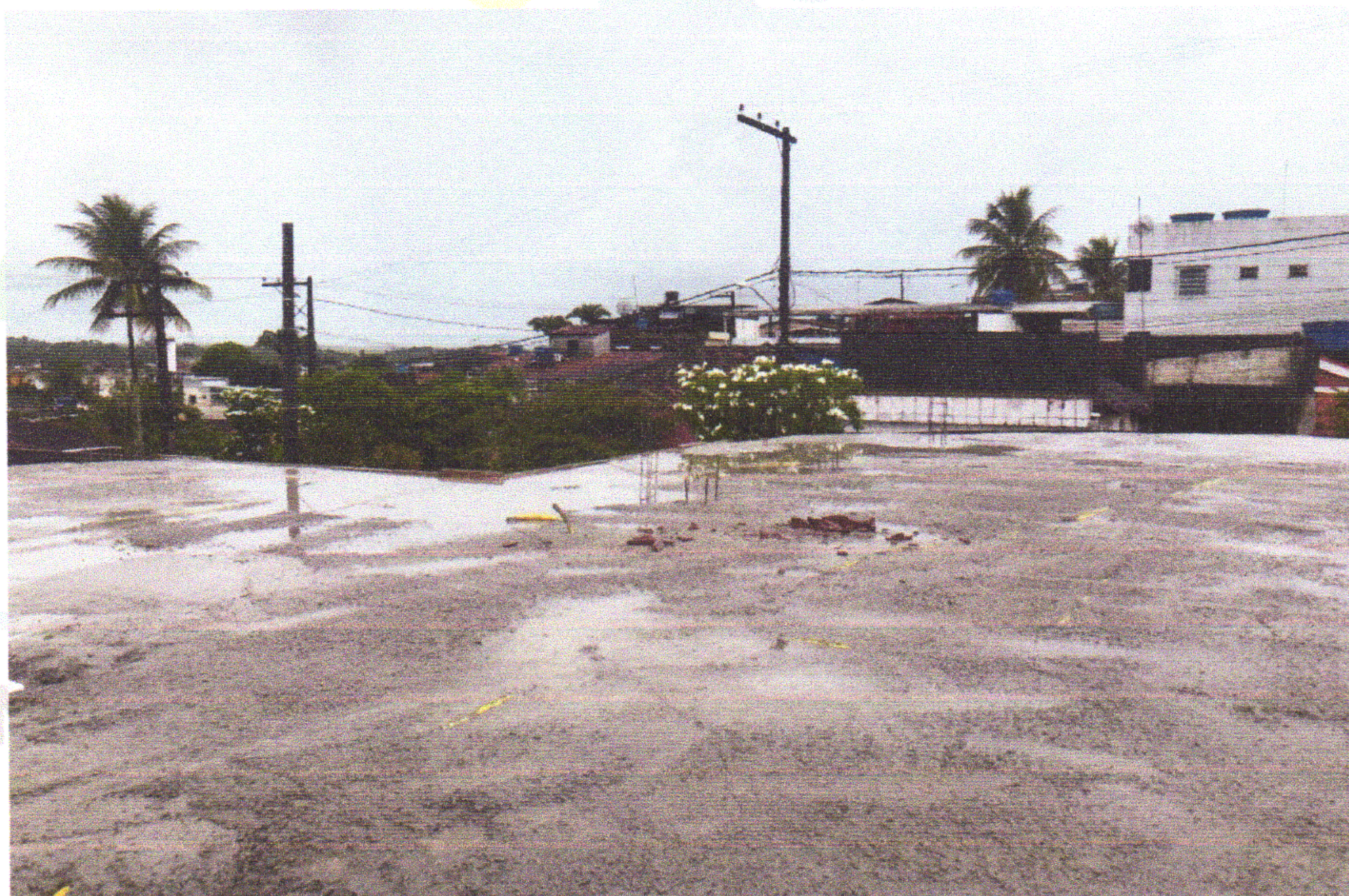
FOTO 13 (CONCRETAGEM DE VIGAS E LAJE)
