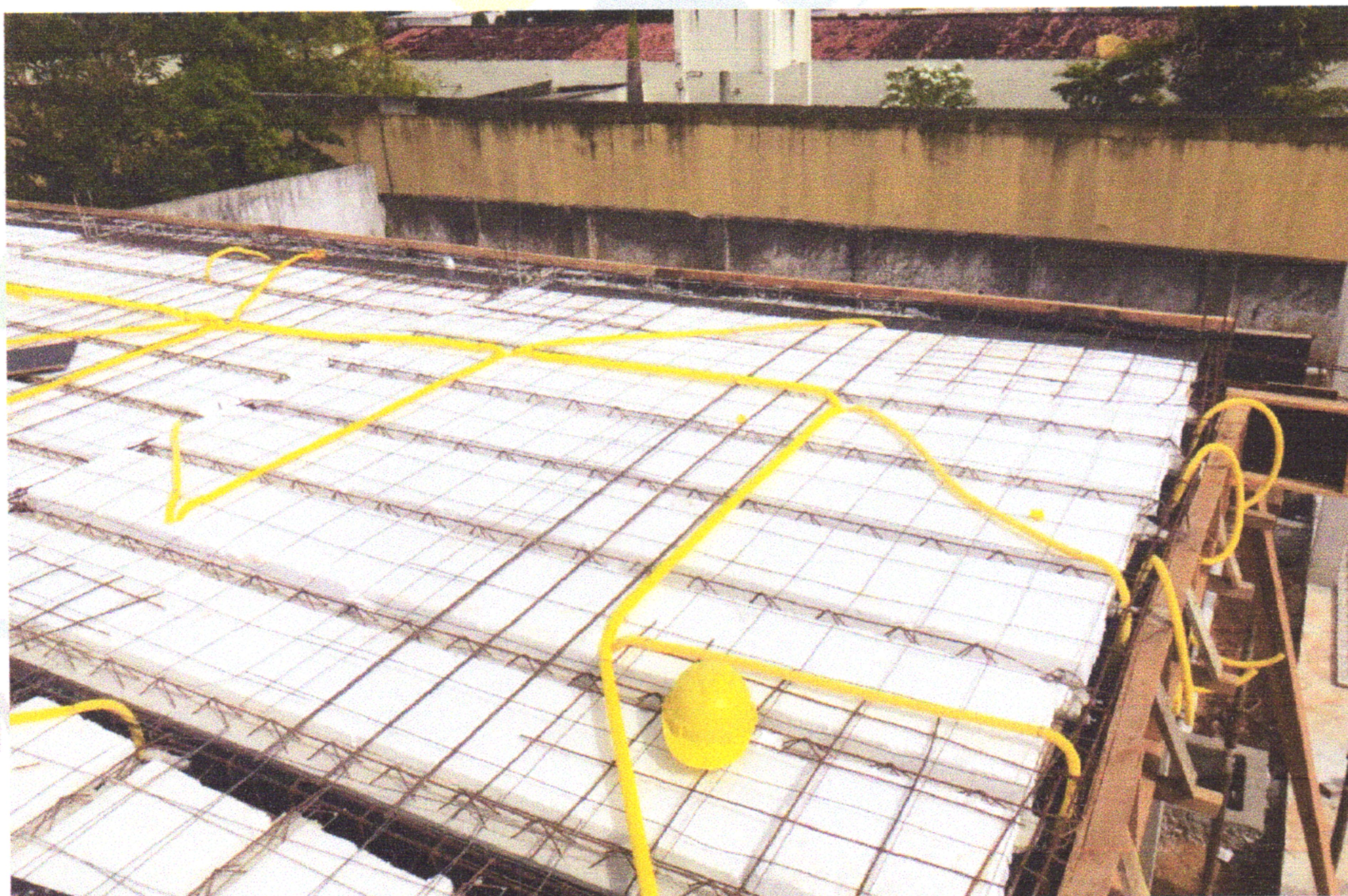
FOTO 05 (ARMAÇÃO DE VIGAS E LAJE E INSTALAÇÃO DOS ELETRODUTOS)
