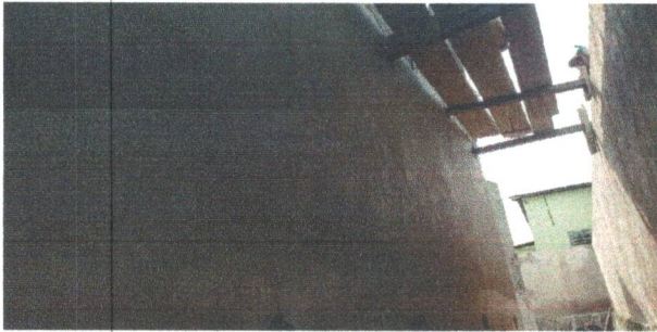
APLICAÇÃO DE MASSA ÚNICA NA FACHADA
