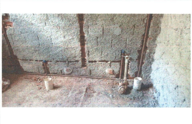
INSTALAÇÃO DE PONTOS DE CONSUMO DE ÁGUA
