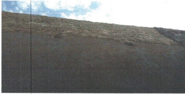
APLICAÇÃO DE MASSA ÚNICA NA FACHADA
