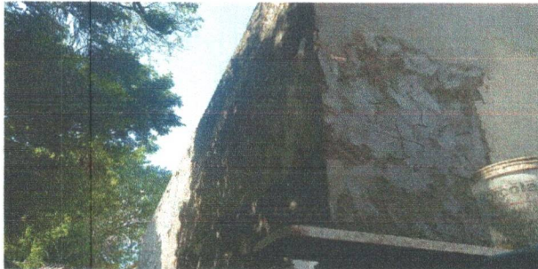
APLICAÇÃO DE MASSA ÚNICA NA FACHADA
