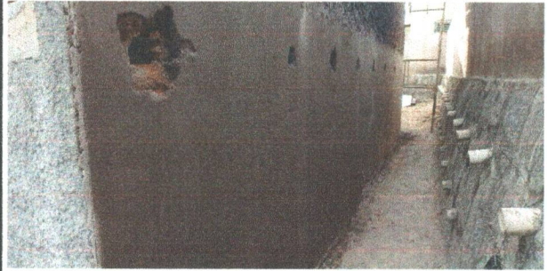
APLICAÇÃO DE MASSA ÚNICA NA FACHADA
