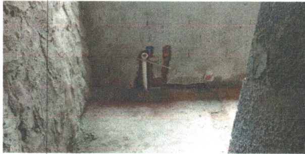
INSTALAÇÃO DE PONTOS DE CONSUMO DE ÁGUA
