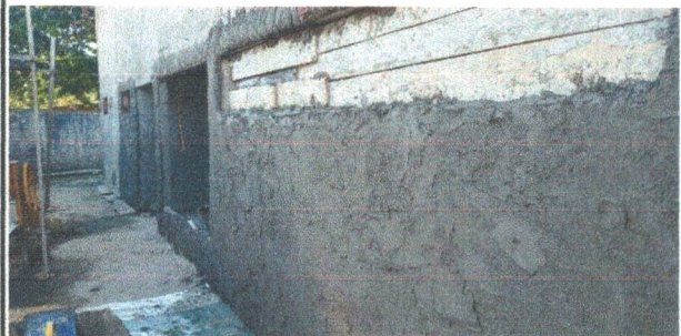
APLICAÇÃO DE MASSA ÚNICA NA FACHADA
