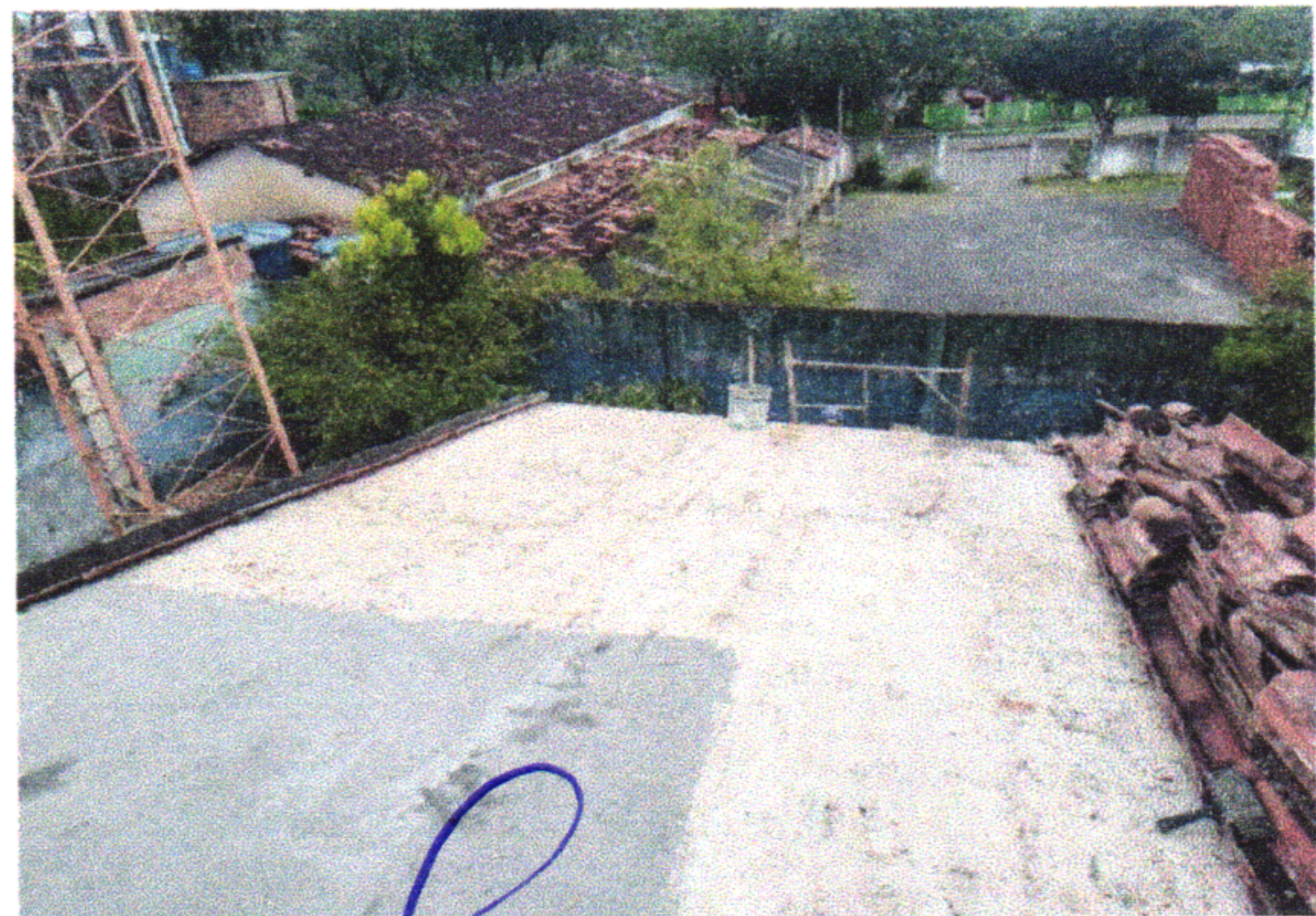
1.6.2 IMPERMEABILIZAÇÃO COM ARGAMASSA POLIMERICA
