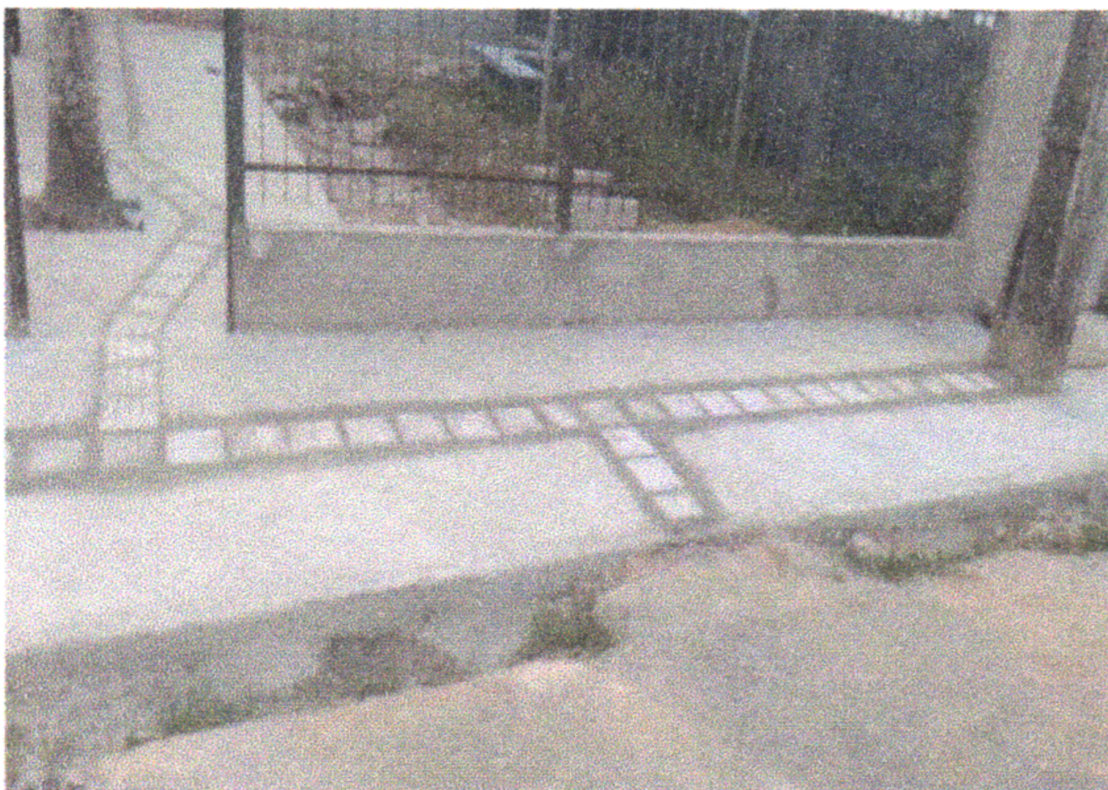
1.5.4 - EXECUÇÃO DE PASSEIO
