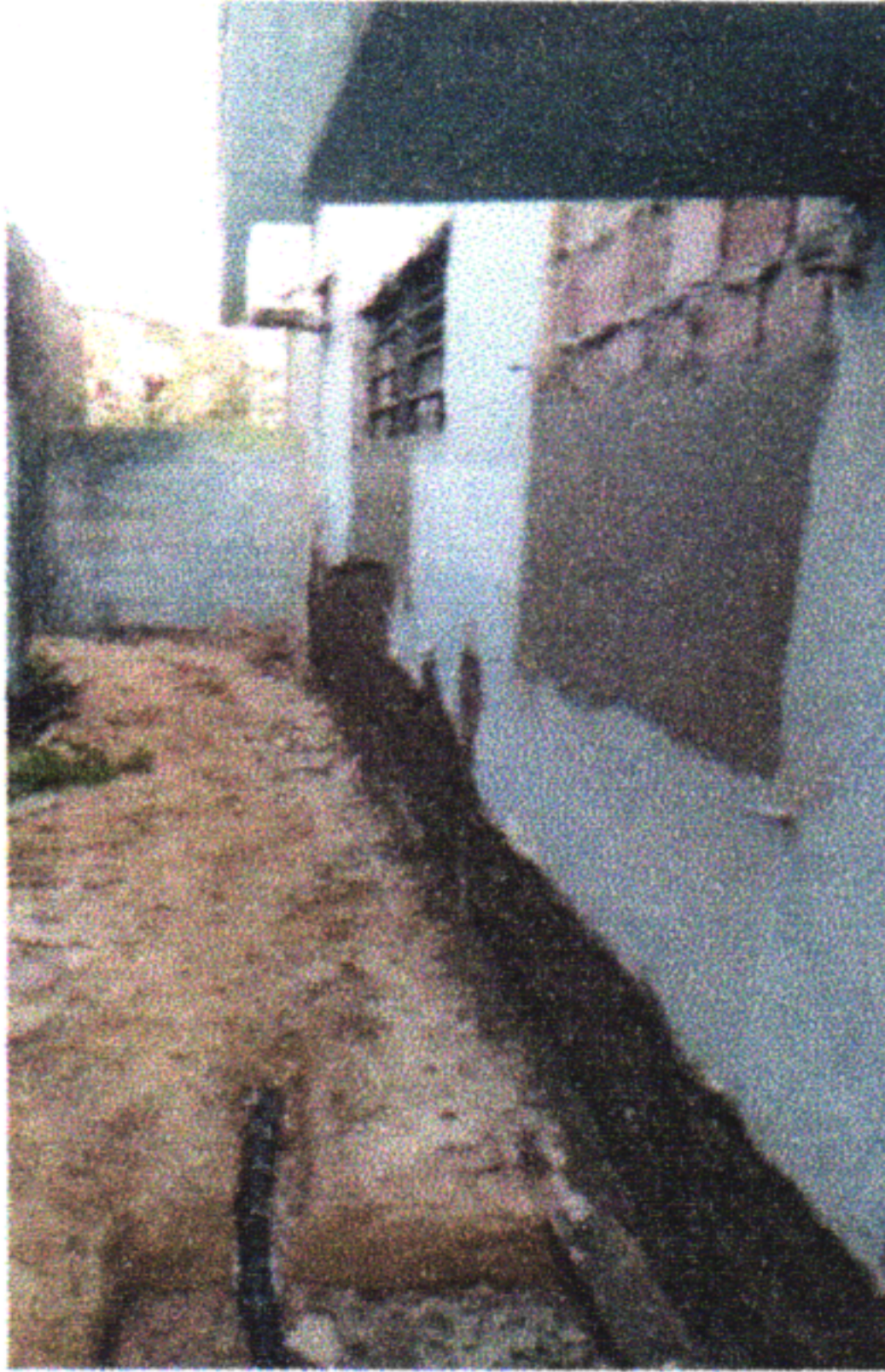
1.2.5REMOÇÃO DE JANELA
