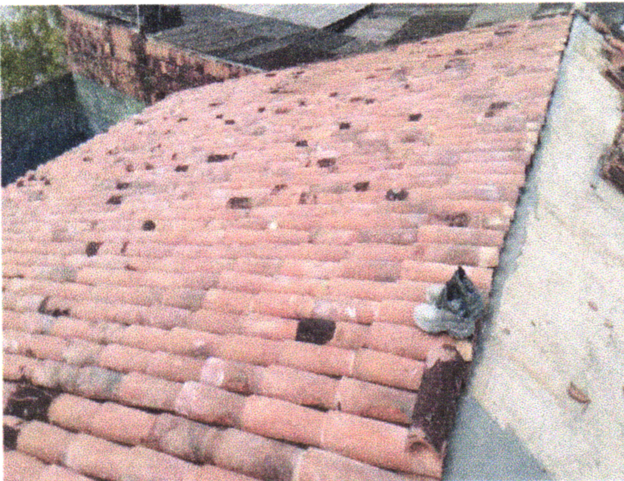
1.6.1 - RETIRADA E RELOCAÇÃO DE TELHA
