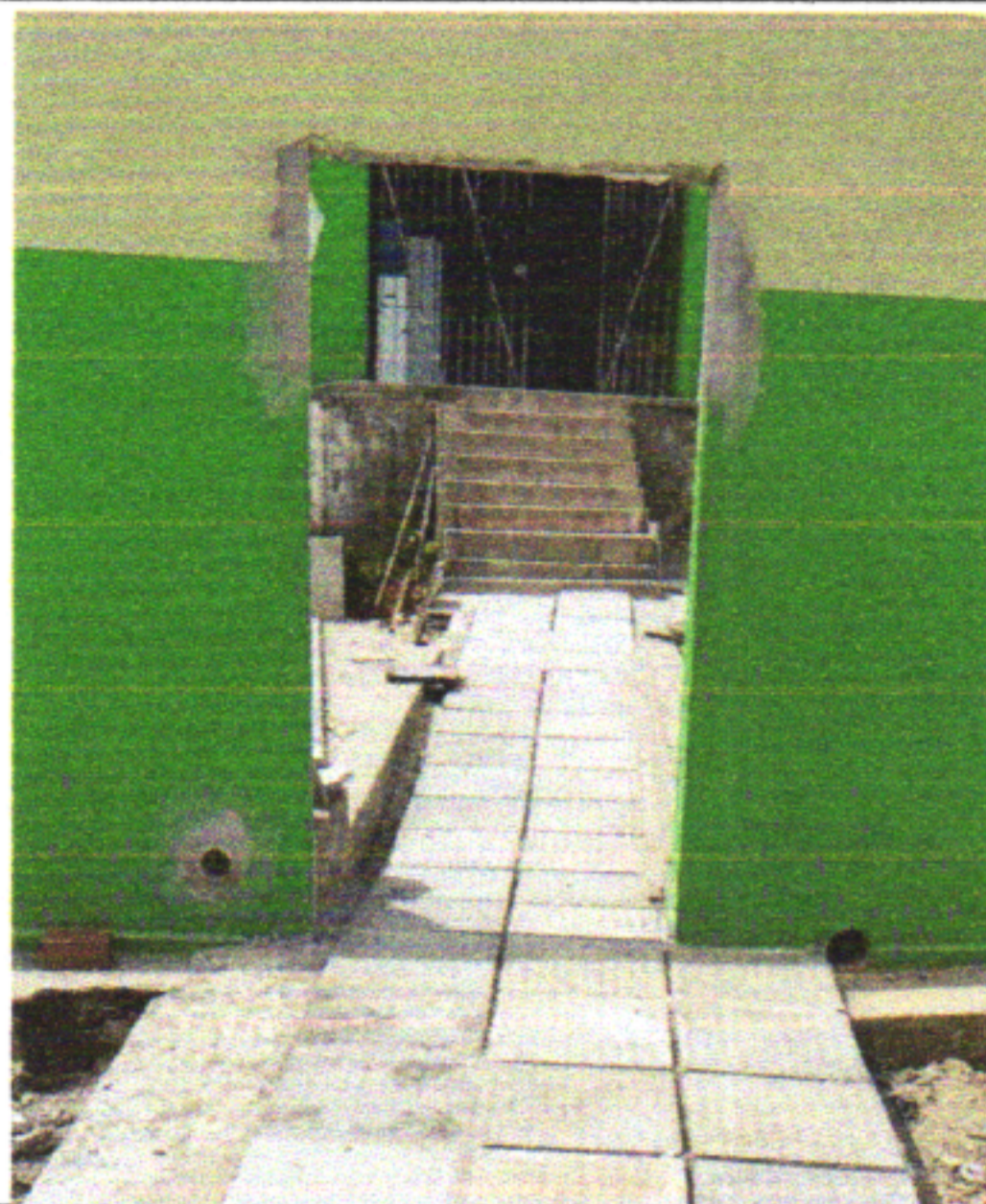
REMOÇÃO DE GRADIL DE FERRO
