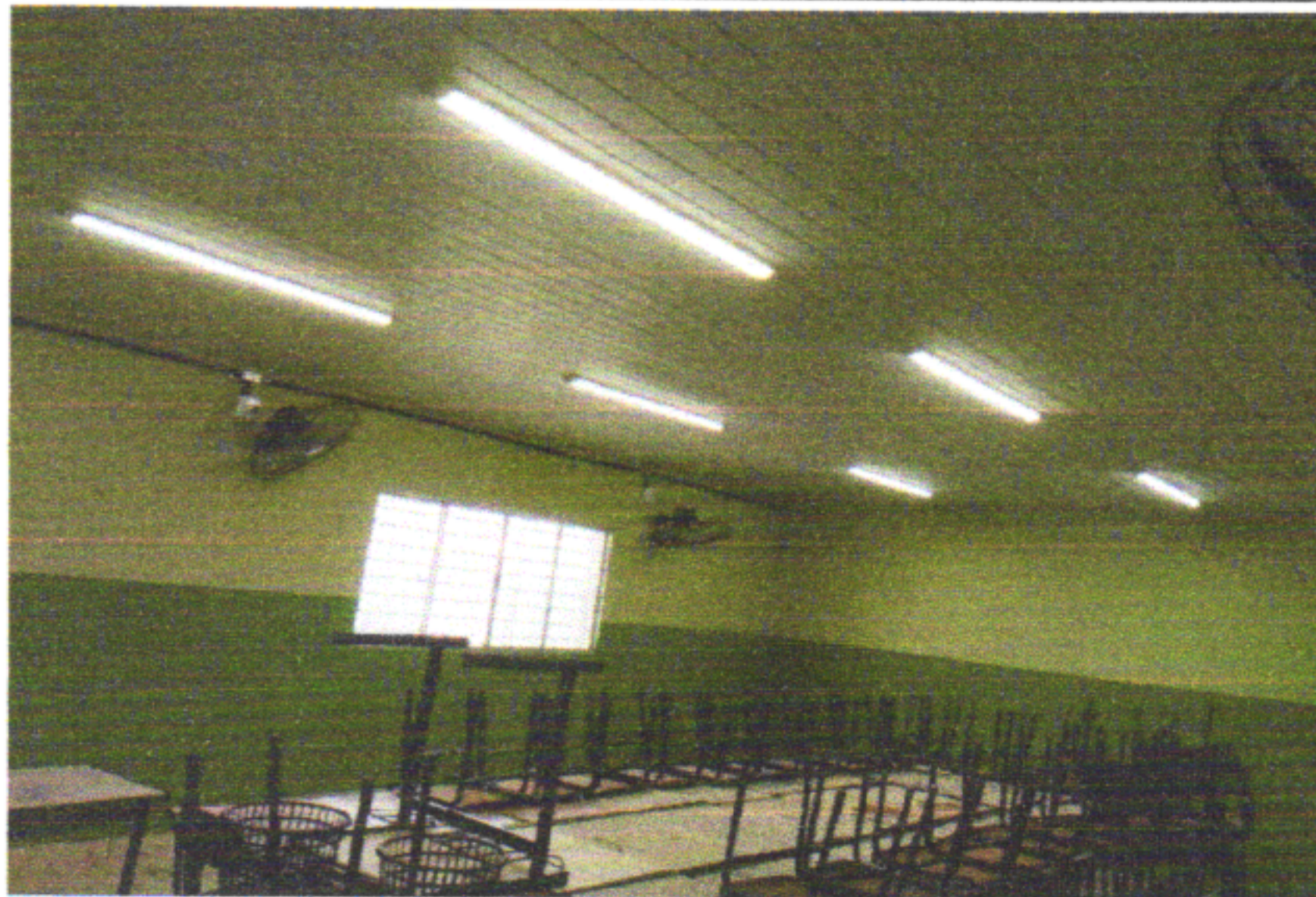
FORRO PVC, LUMINÁRIA LED TIPO SLIM, CONDULETE METÁLICO, PONTO DE AR-CONDICIONADO COM KIT ARSTOP E REVISÃO DA ESQUADRIA DE ALUMÍNIO
