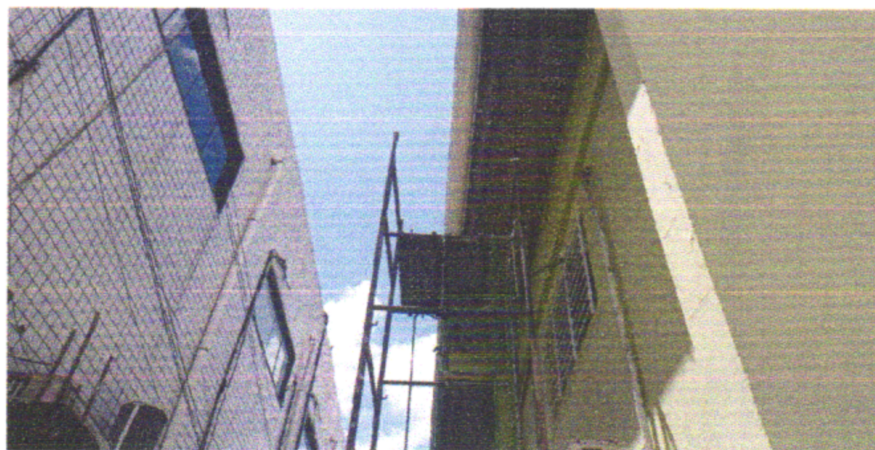
MONTAGEM E DESMONTAGEM DE ANDAIME PARA FECHAMENTO COM ALVENARIA
