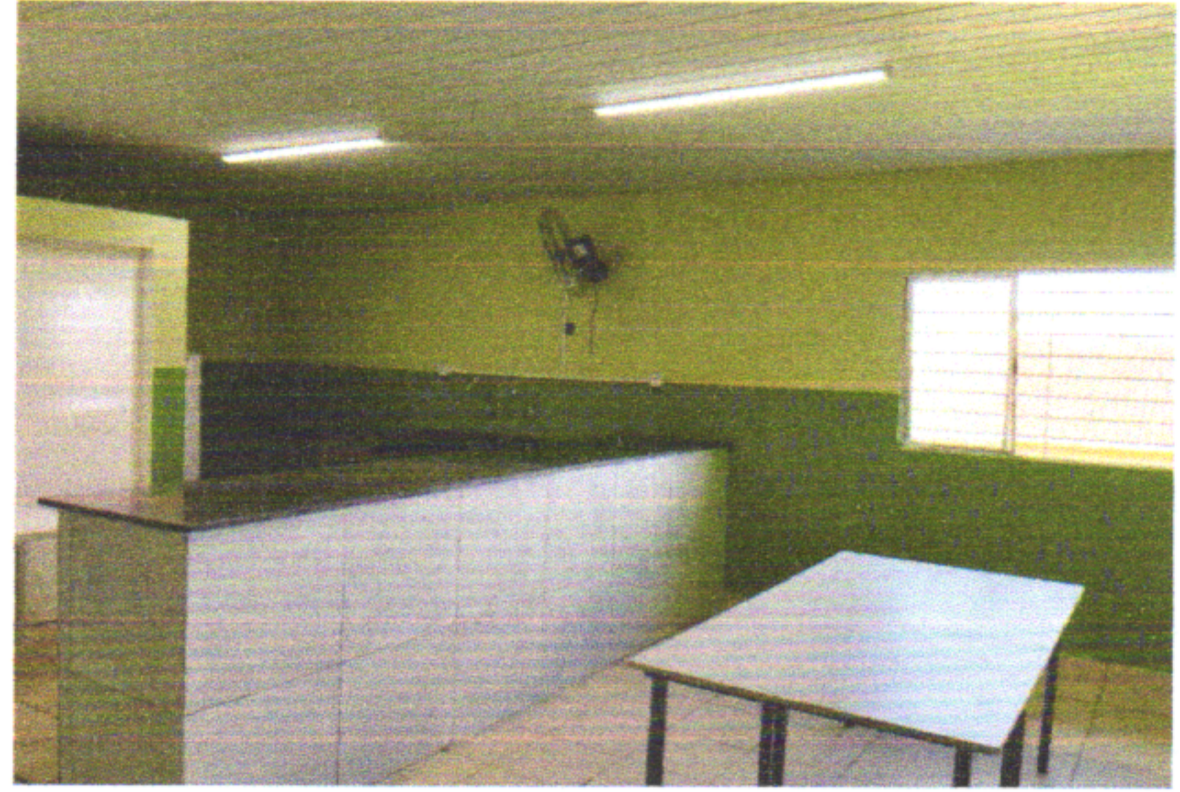
REVESTIMENTO CERÂMICO NA BANCADA DA COZINHA E ASSENTAMENTO DA BANCADA EM GRANITO
