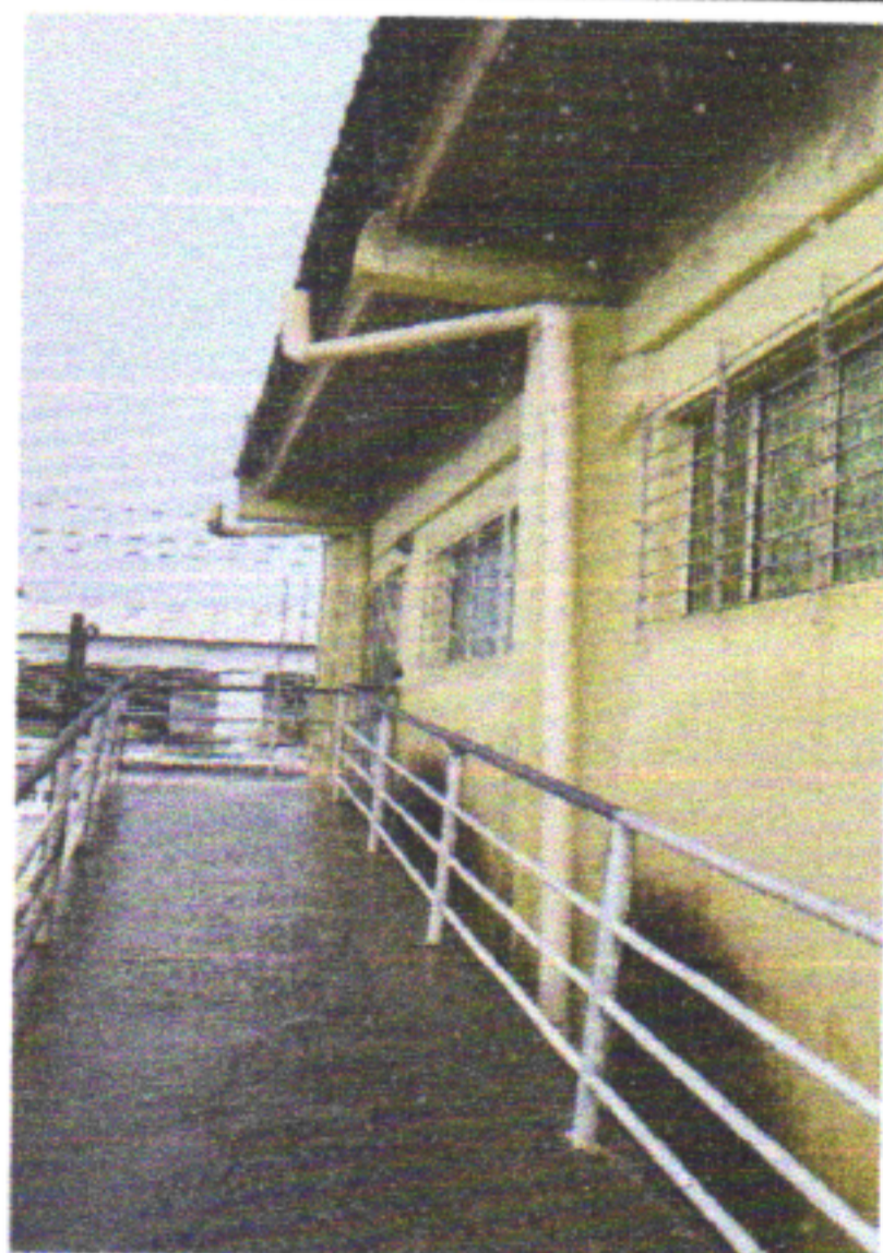
COLOCAÇÃO DE TUBO PVC DN 100 MM PARA A DESCIDA DA CALHA
