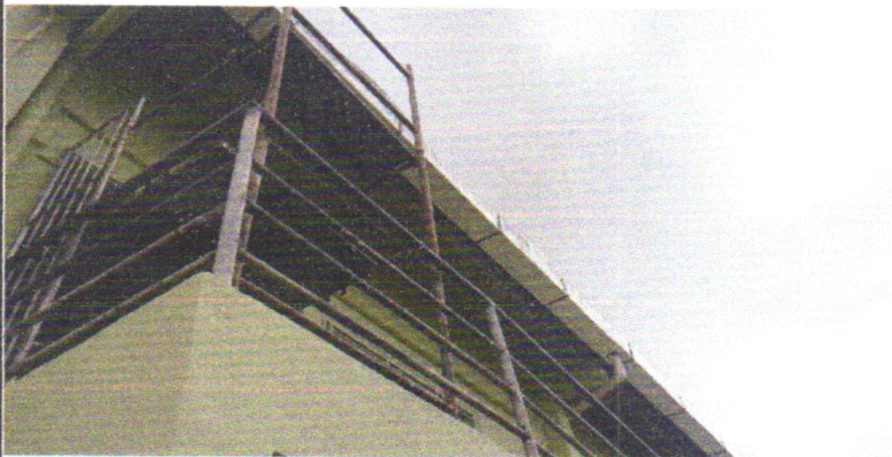
MONTAGEM E DESMONTAGEM DE ANDAIME PARA COLOCAÇÃO DA CALHA
