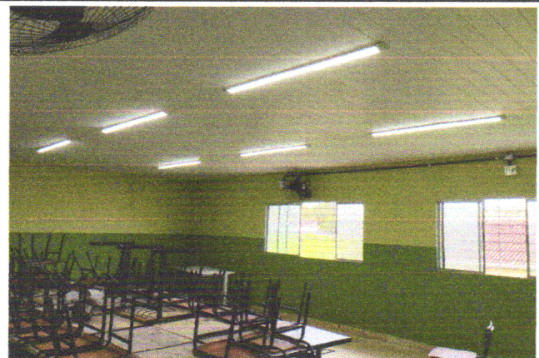
FORRO PVC, LUMINÁRIA LED TIPO SLIM, CONDULETE METÁLICO, PONTO DE AR-CONDICIONADO COM KIT ARSTOP E REVISÃO DA ESQUADRIA DE ALUMÍNIO
