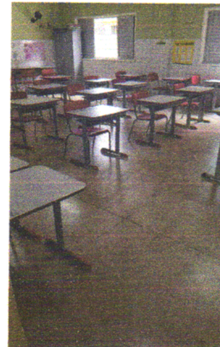
APLICAÇÃO DE RESINA NO PISO GRANILITE DAS SALAS
