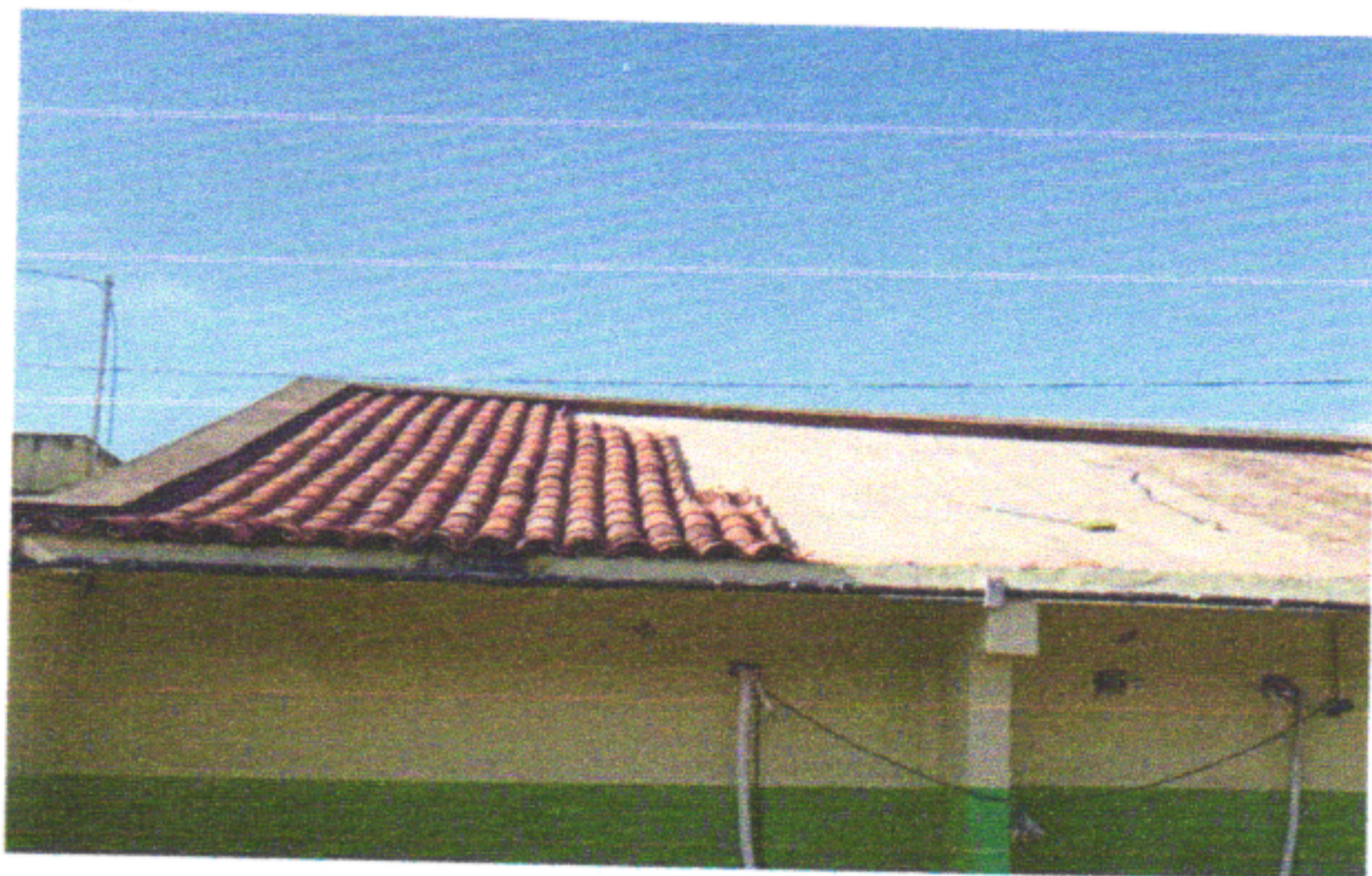
RETELHAMENTO COM TELHA CANAL
