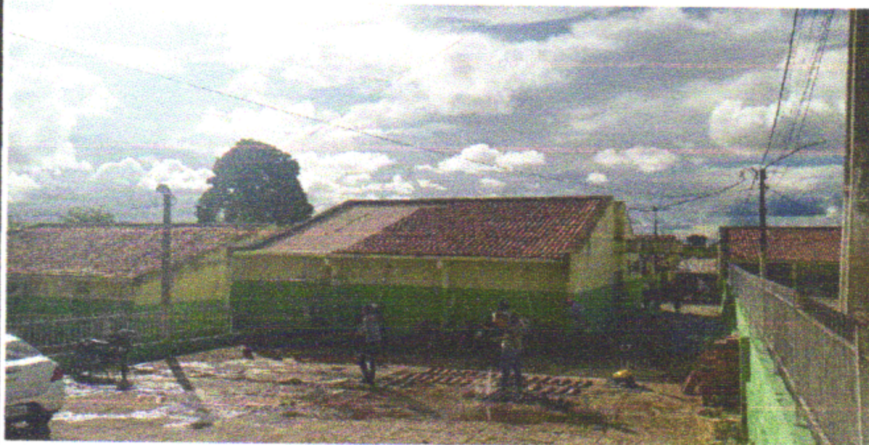
TELHAMENTO E RETELHAMENTO COM TELHA CANAL COM UTILIZAÇÃO DE ANDAIME E LAVAGEM DAS TELHAS ANTIGAS
