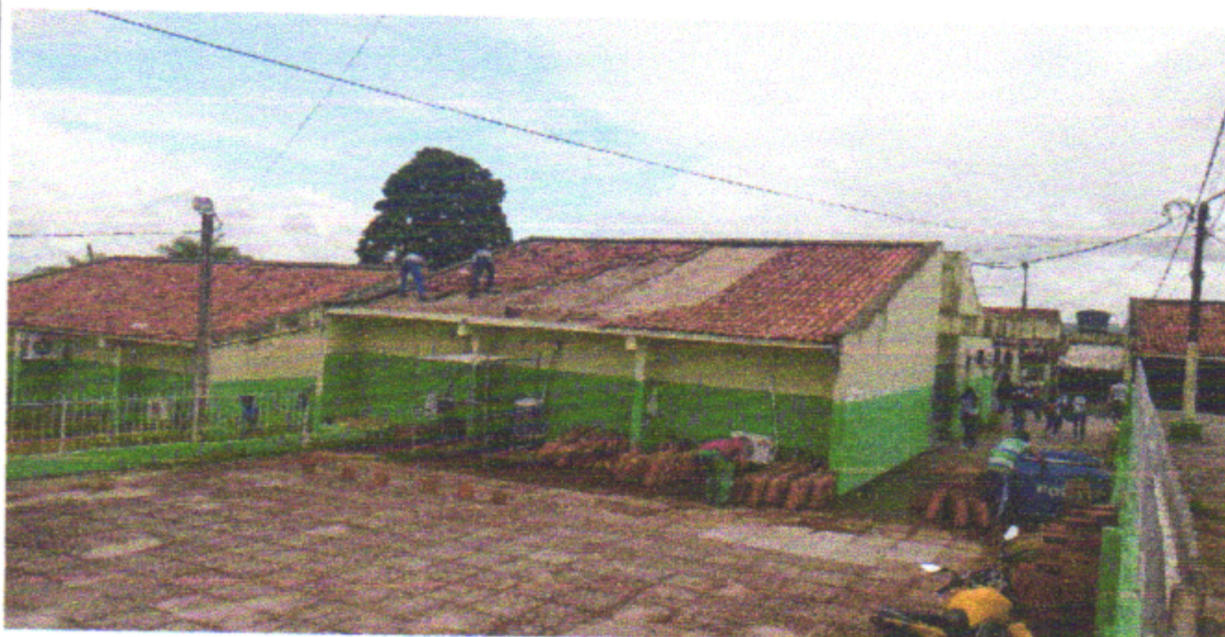
TELHAMENTO E RETELHAMENTO COM TELHA CANAL COM UTILIZAÇÃO DE ANDAIME
