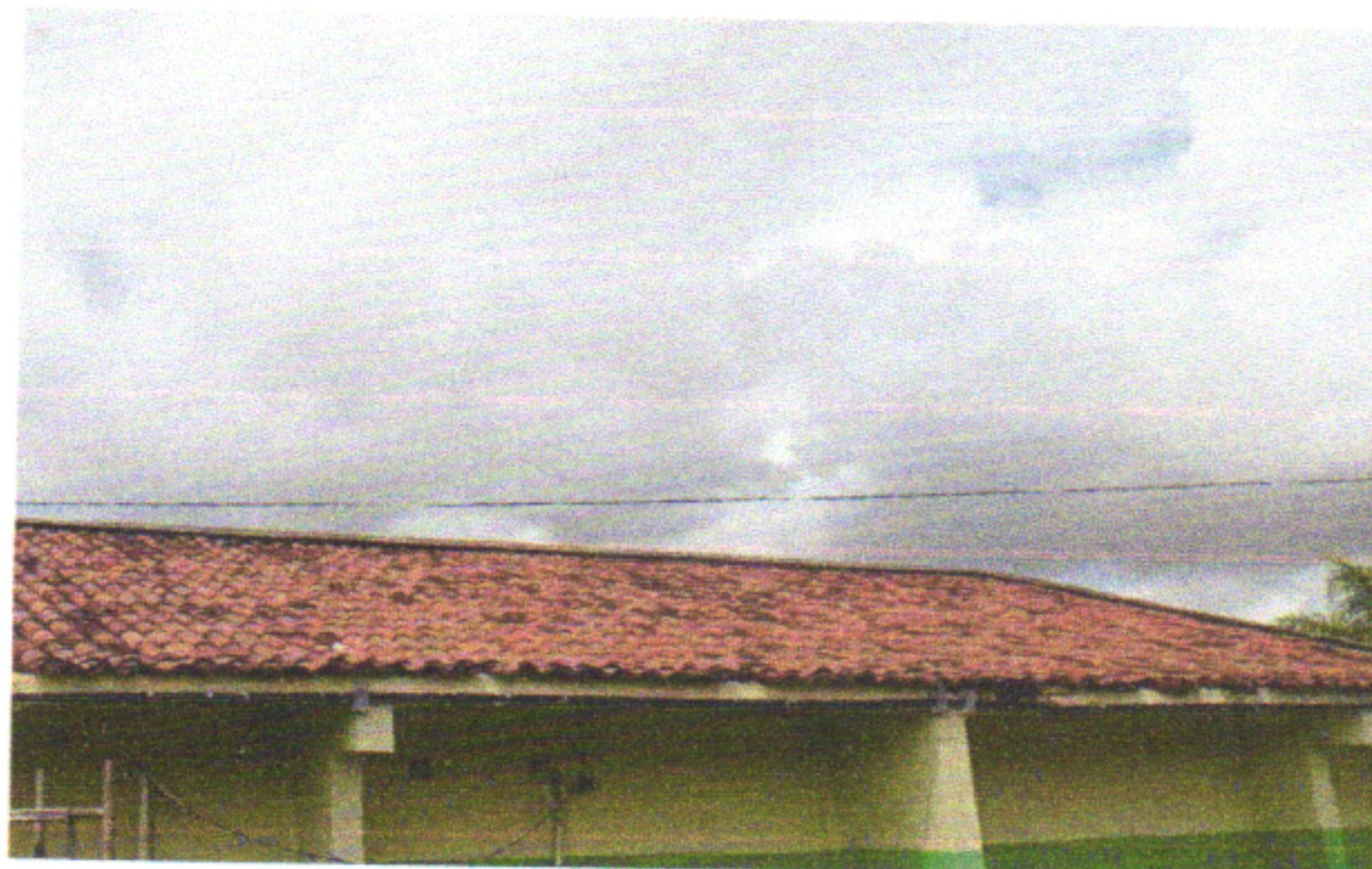
ANTES DO RETELHAMENTO
