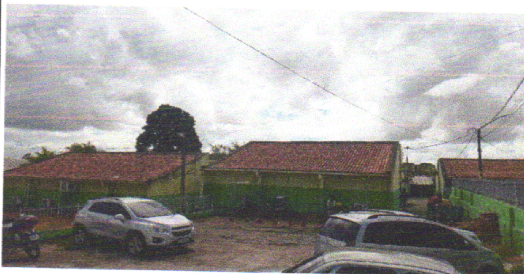
DEPOIS DO RETELHAMENTO E TELHAMENTO
