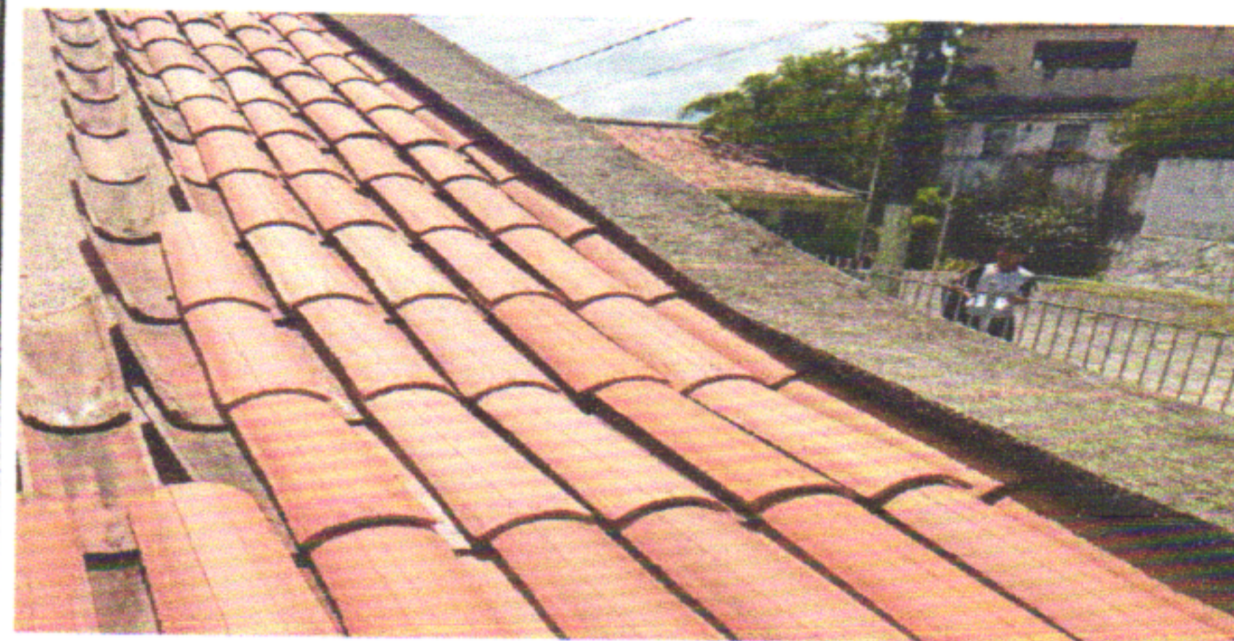
TELHAMENTO COM TELHA CANAL
