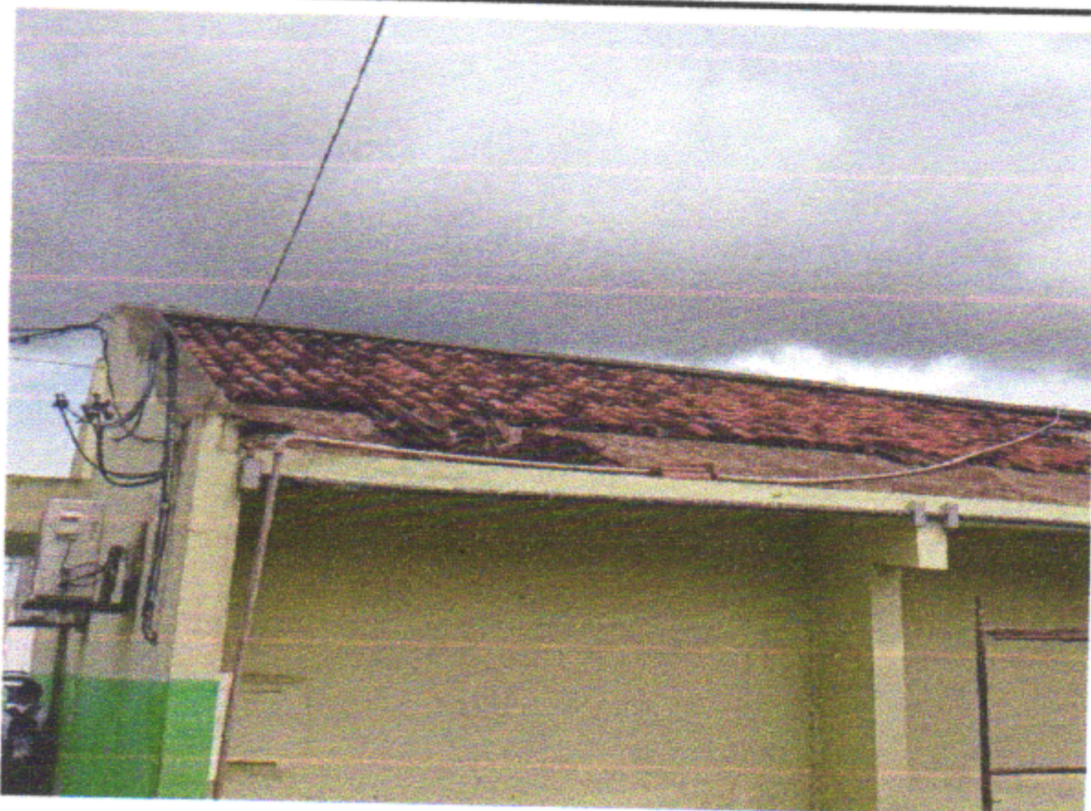
RETELHAMENTO COM TELHA CANAL
