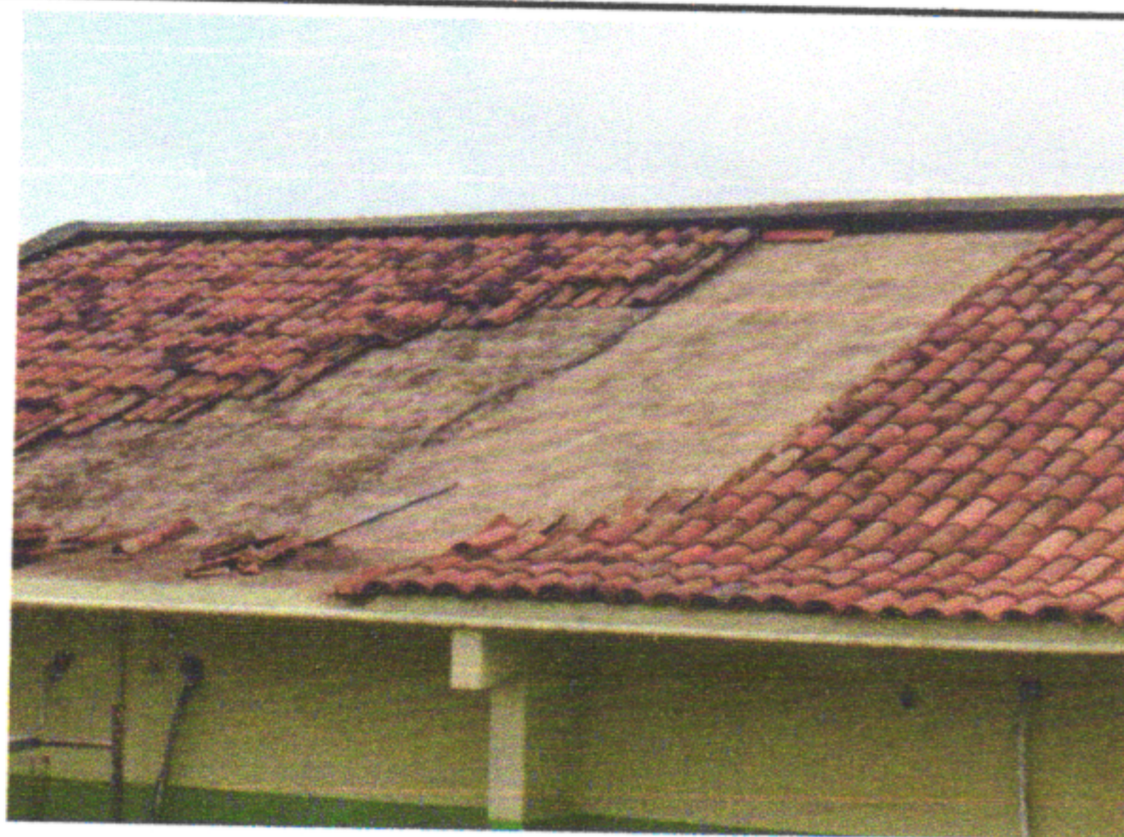
TELHAMENTO E RETELHAMENTO COM TELHA CANAL
