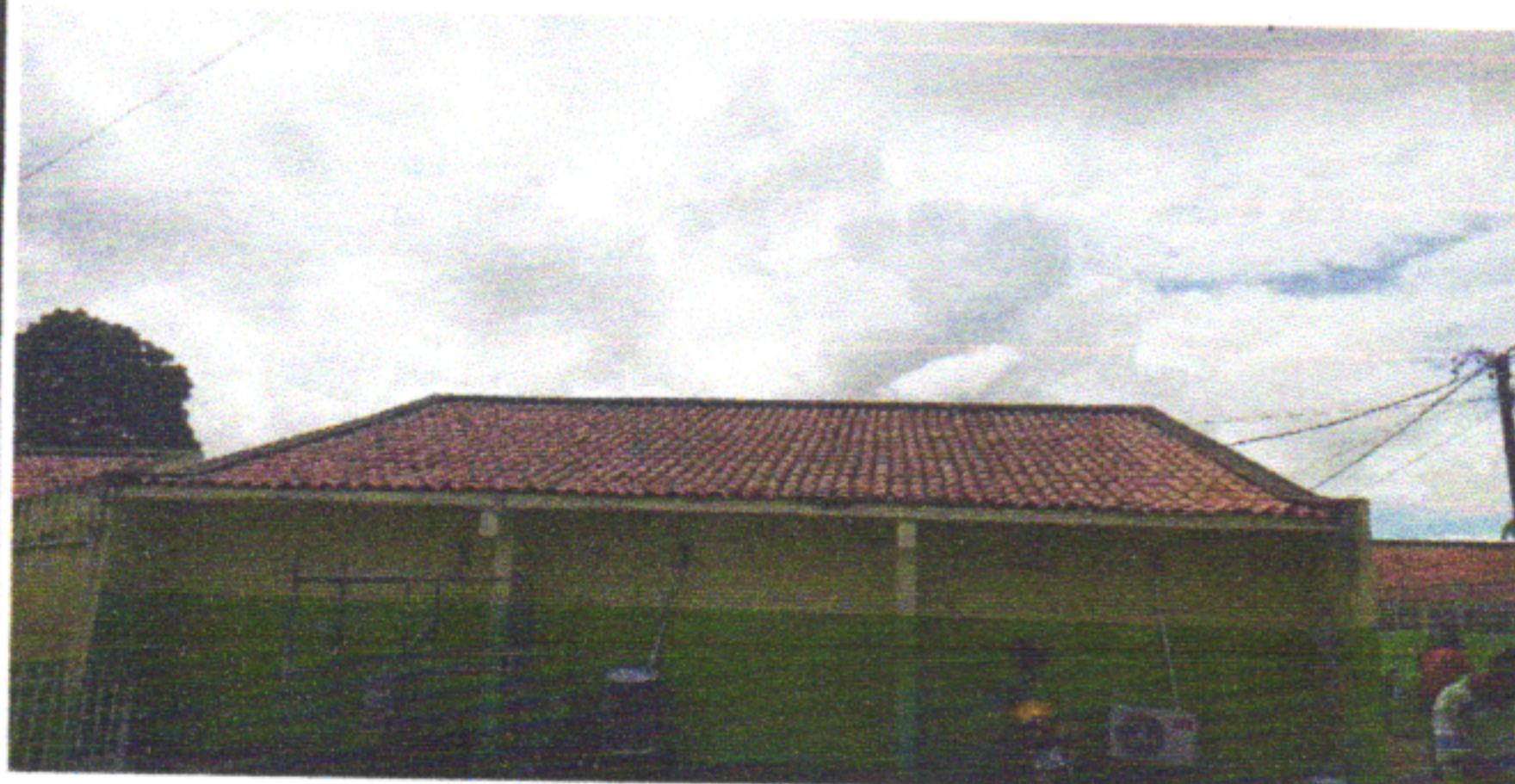
DEPOIS DO RETELHAMENTO E TELHAMENTO
