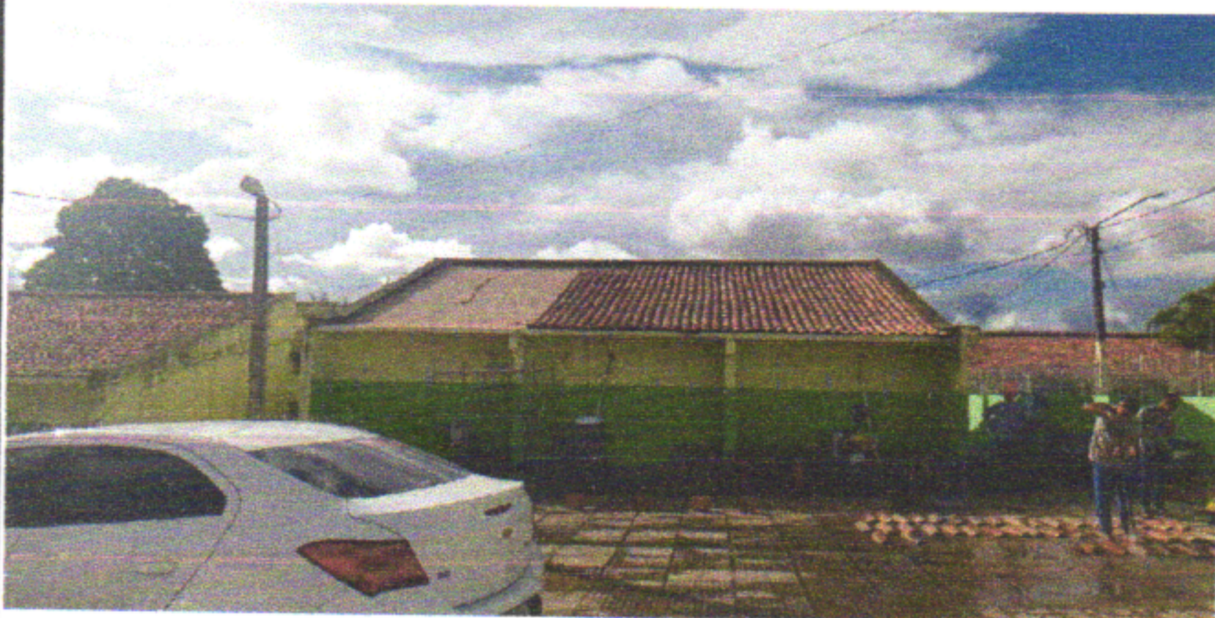
TELHAMENTO E RETELHAMENTO COM TELHA CANAL COM UTILIZAÇÃO DE ANDAIME E LAVAGEM DAS TELHAS ANTIGAS
