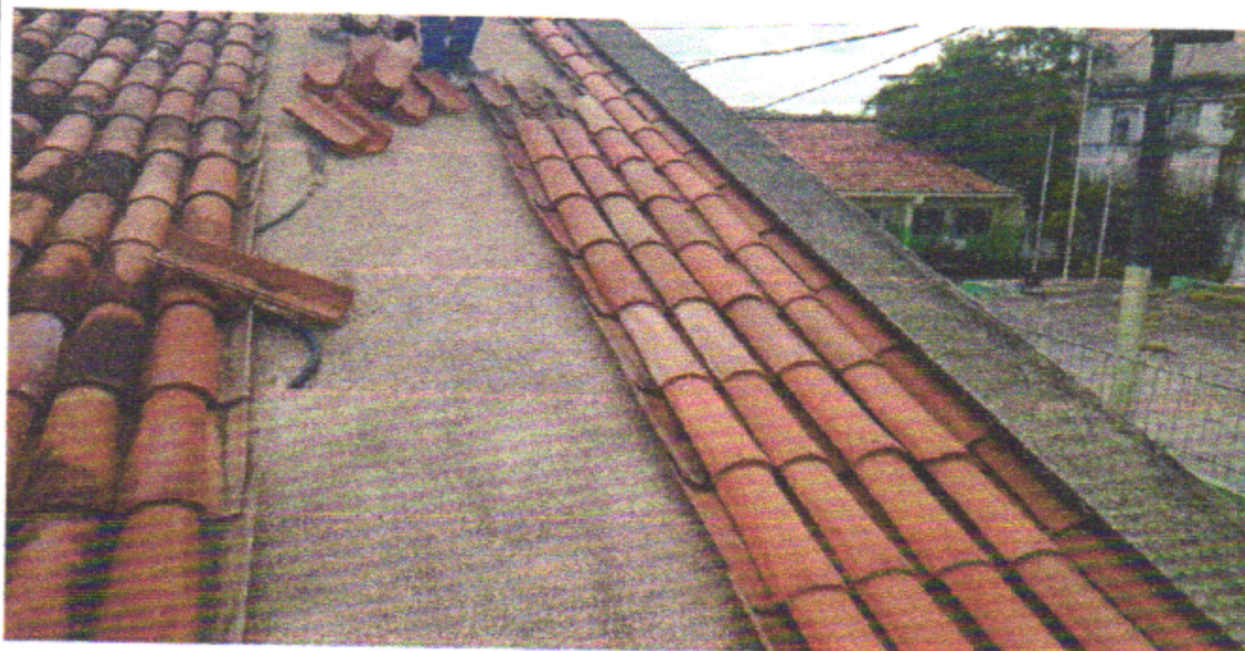
TELHAMENTO COM TELHA CANAL
