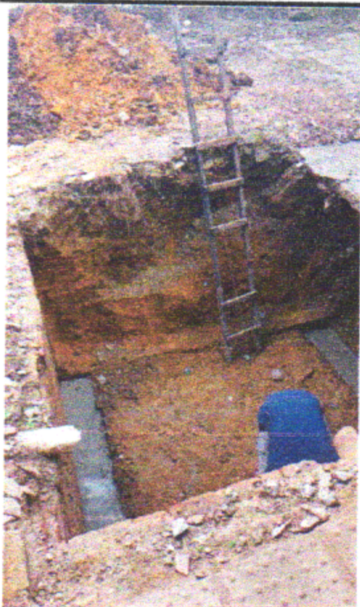
LASTRO DE CONCRETO MAGRO
