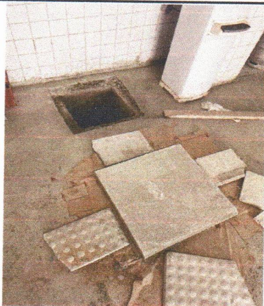
ALVENARIA, CHAPISCO E EMBOÇO
