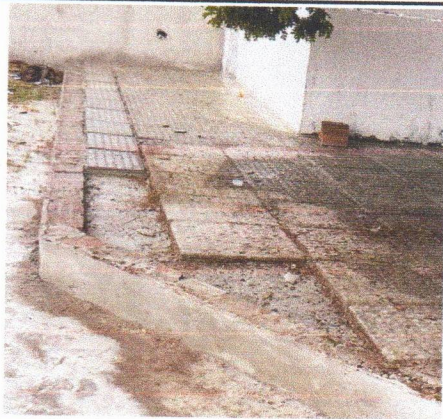
DEMOLIÇÃO DE LAJOTA E LASTRO DE CONCRETO MAGRO
