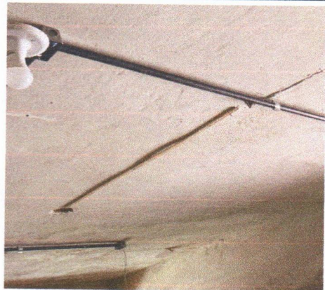
REMOÇÃO DE LUMINÁRIAS
