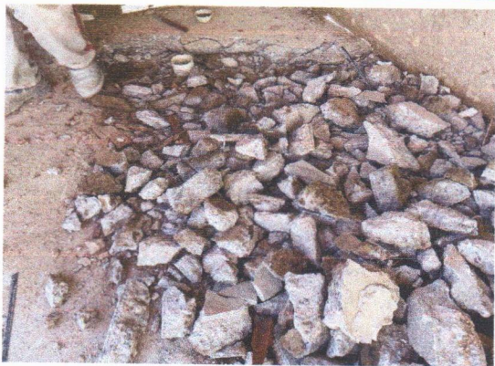
DEMOLIÇÃO DE PISO
