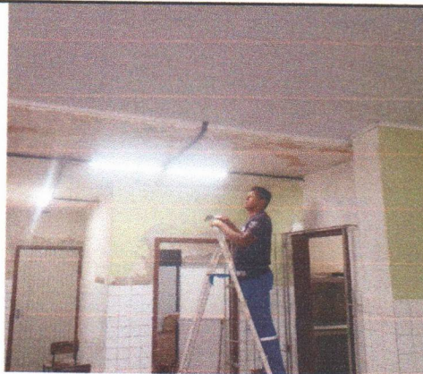
REMOÇÃO DE PINTURA
