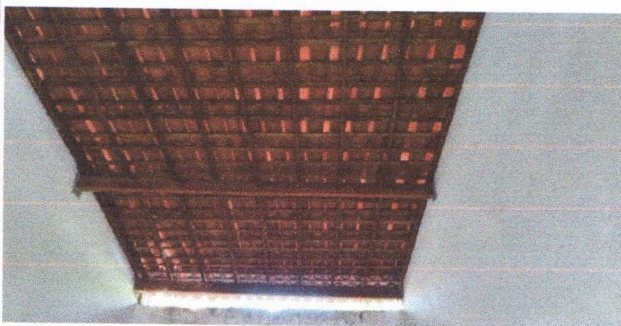
UTILIZAÇÃO DE ANDAIME PARA A COBERTA DO WC MASCULINO
