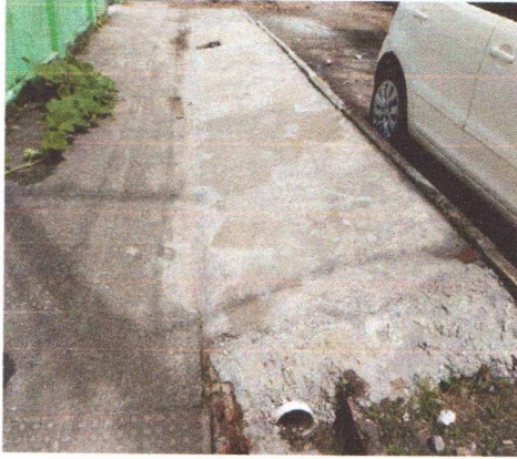
EXECUÇÃO DE CALÇADA NA ENTRADA DA ESCOLA, COM CAIXA DE PASSAGEM PARA ÁGUA PLUVIAL
