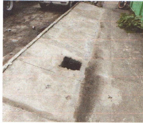
EXECUÇÃO DE CALÇADA NA ENTRADA DA ESCOLA, COM CAIXA DE PASSAGEM PARA ÁGUA PLUVIAL
