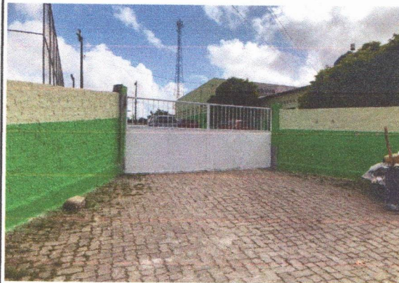
APLICAÇÃO, LIXAMENTO E PINTURA EM SUPERFÍCIES METÁLICAS
