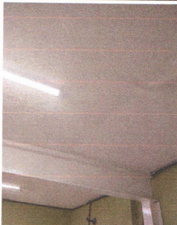
APLICAÇÃO DE PINTURA NO TETO
