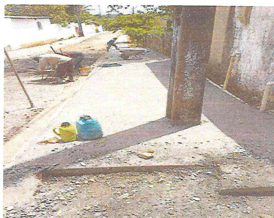
RUA ALAMEDA DO GIRASSOL (E0 à E21+5,00) - TIÚMA
