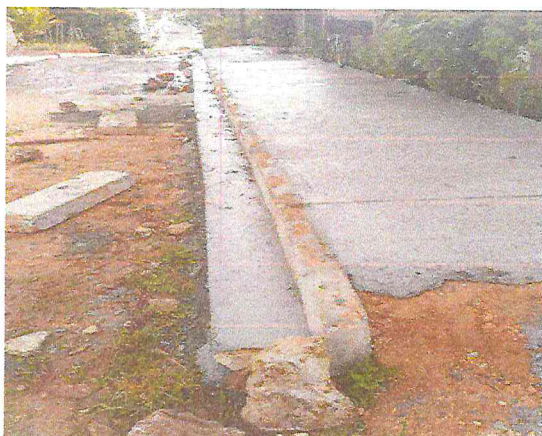
RUA ALAMEDA DO GIRASSOL (E0 à E21+5,00) - TIÚMA
