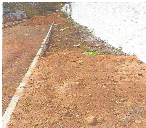
RUA ALAMEDA DO GIRASSOL (E0 à E21+5,00) - TIÚMA
