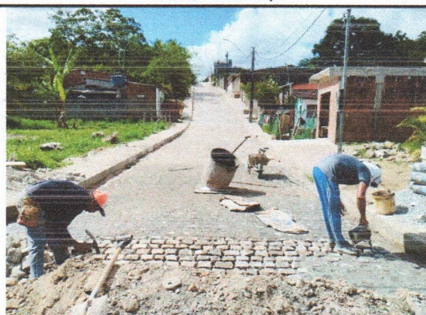
RUA BUIQUE - PAVIMENTAÇÃO
