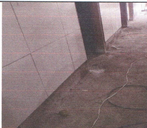
EXECUÇÃO DE PILARES EM CONTRATO
