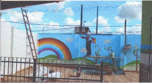
EXECUÇÃO DE GRADIL COM MURETA
