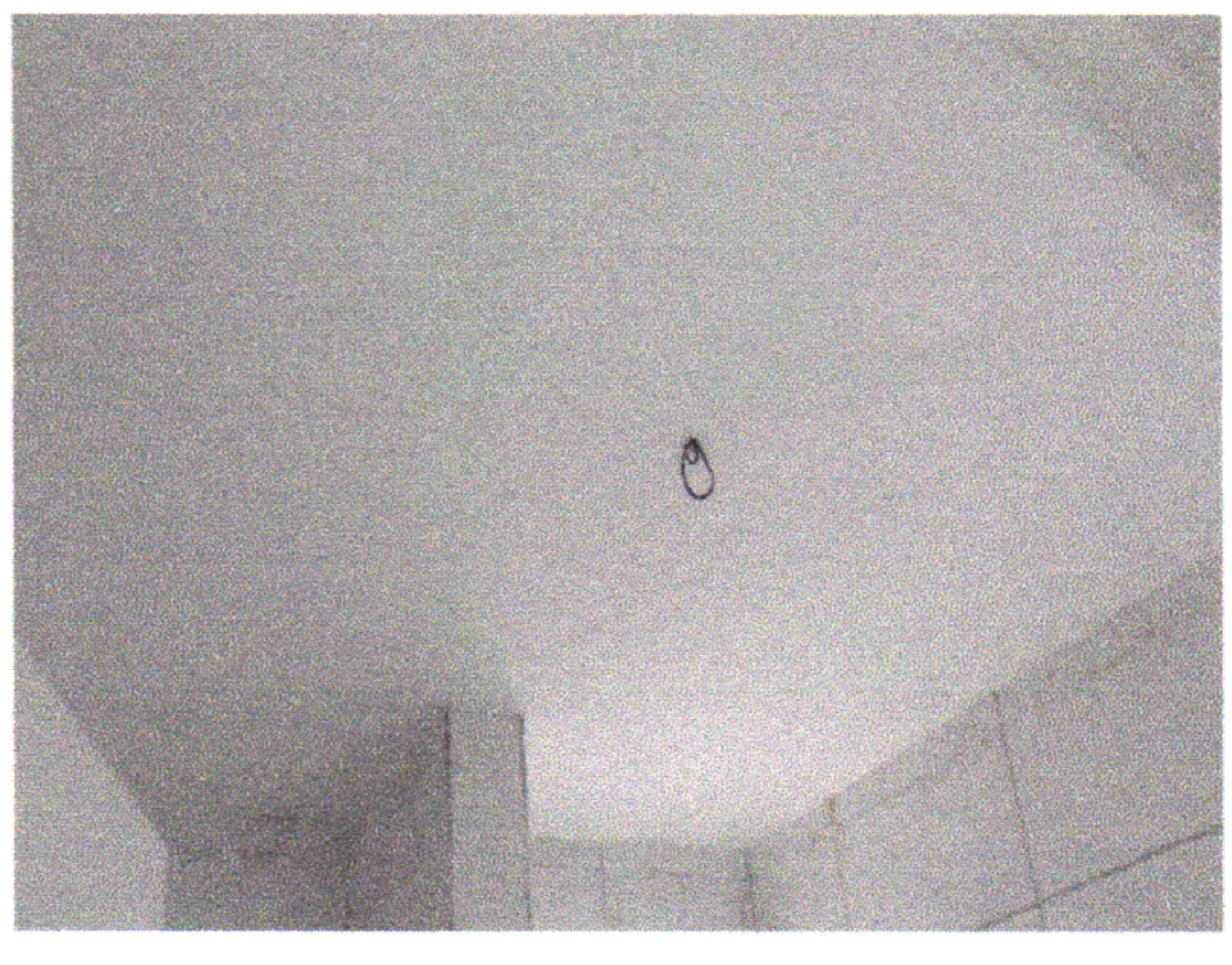
1.14.4 - APLICAÇÃO DE MASSA EM TETO
