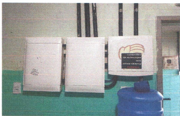
ESCOLA MUNICIPAL CLODOALDO GOMES DE ARAUJO ( ELÉTRICA: SUBSTITUIÇÃO DO CABEAMENTO E QUADRO DE DISTRIBUIÇÃO PARA 36 DISJUNTORES )
