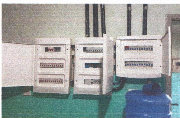
ESCOLA MUNICIPAL CLODOALDO GOMES DE ARAUJO ( ELÉTRICA: SUBSTITUIÇÃO DO CABEAMENTO E QUADRO DE DISTRIBUIÇÃO PARA 36 DISJUNTORES )
