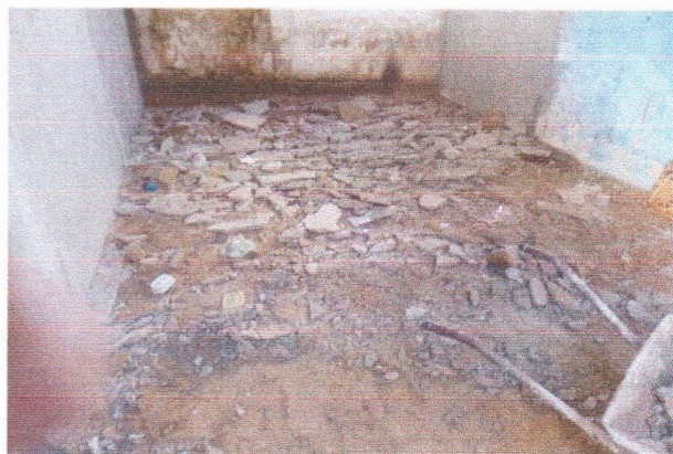
ESCOLA MUNICIPAL SENADOR FRANCISCO GOMES DE ARAÚJO - DEMOLIÇÃO DO PISO CIMENTADO
