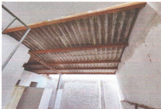
ESCOLA MUNICIPAL INÁCIO GOMES DA SILVA - ESTRUTURA DE MADEIRA PARA COBERTA DE FIBROCIMENTO
