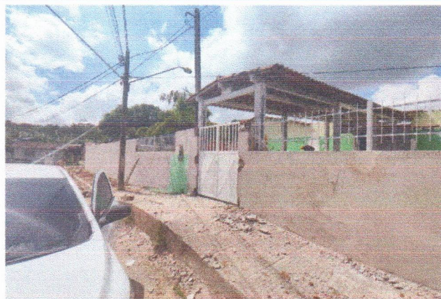
ESCOLA MUNICIPAL ERCINA LAPENDA - PORTÃO DE ENTRADA EM FERRO DUAS FOLHAS (PORTÃO PEDESTRE) E GRADIL EM FERRO
