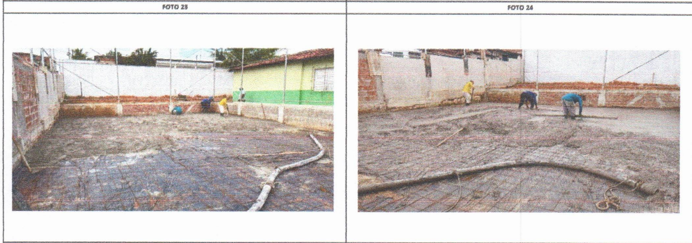
ESCOLA MUNICIPAL ERCINA LAPENDA - PISO EM CONCRETO ARMADO DA QUADRA
