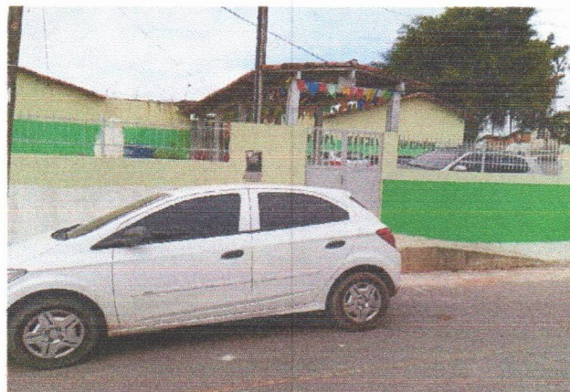
ESCOLA MUNICIPAL ERCINA LAPENDA - GRADIL EM FERRO
