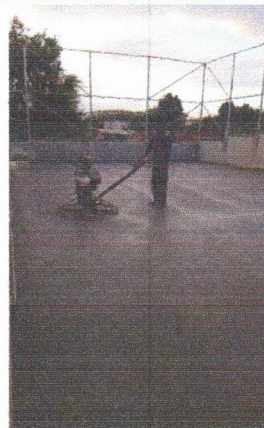
ESCOLA MUNICIPAL ERCINA LAPENDA - PISO EM CONCRETO ARMADO DA QUADRA
