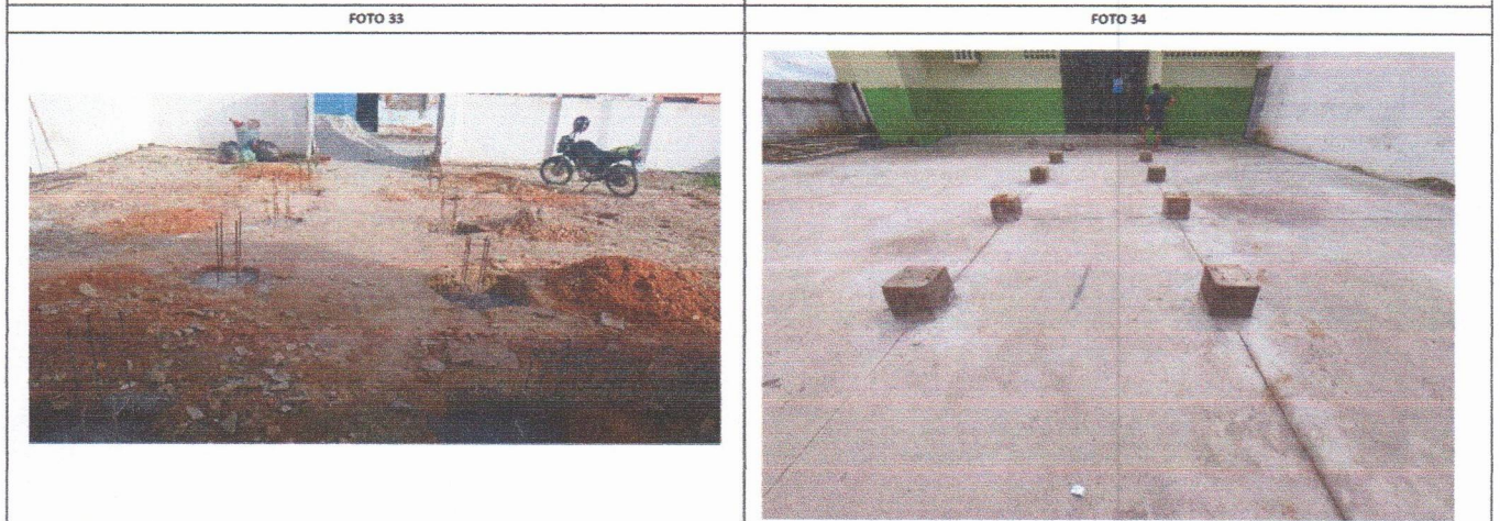
ESCOLA MUNICIPAL INÁCIO GOMES DA SILVA - SAPATAS DA PASSARELA DA ENTRADA
