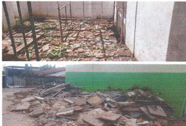
ESCOLA MUNICIPAL INÁCIO GOMES DA SILVA - DEMOLIÇÕES DA OBRA
