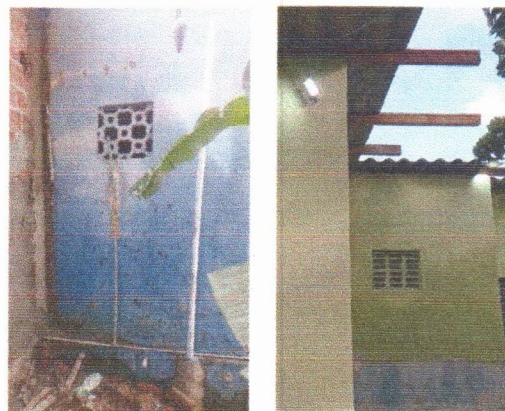
ESCOLA MUNICIPAL SENADOR FRANCISCO GOMES DE ARAÚJO - DEMOLIÇÃO E ASSENTAMENTO DE COBOGÓ
