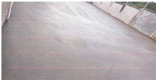
ESCOLA MUNICIPAL ERCINA LAPENDA - PISO EM CONCRETO ARMADO DA QUADRA
