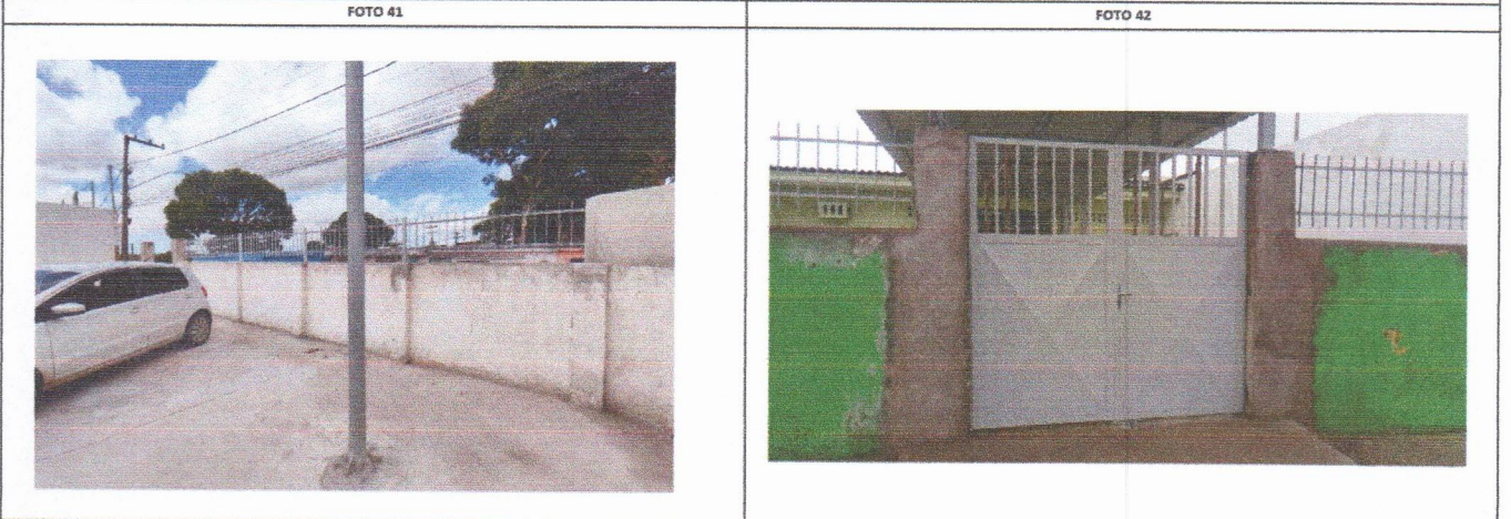
ESCOLA MUNICIPAL INÁCIO GOMES DA SILVA - GRADIL EM FERRO ESCOLA MUNICIPAL INÁCIO GOMES DA SILVA - PORTÃO EM FERRO DUAS FOLHAS (ENTRADA DE PEDESTRE) E GRADIL EM FERRO
