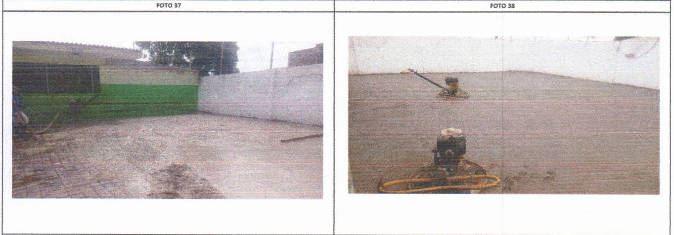
ESCOLA MUNICIPAL INÁCIO GOMES DA SILVA - PISO DA QUADRA EM CONCRETO ARMADO ESCOLA MUNICIPAL INÁCIO GOMES DA SILVA - PISO DA QUADRA EM CONCRETO ARMADO
