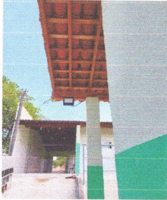
ESCOLA MUNICIPAL FRANCISCO TAVARES - ELÉTRICA
