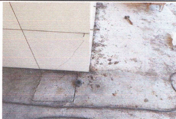
ESCOLA MUNICIPAL FRANCISCO TAVARES - ELÉTRICA
