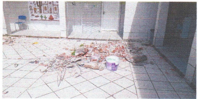
ESCOLA MUNICIPAL ERCINA LAPENDA - DEMOLIÇÃO DA LAJE DA CISTERNA
