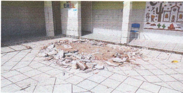
ESCOLA MUNICIPAL ERCINA LAPENDA - DEMOLIÇÃO DE CONCRETO
