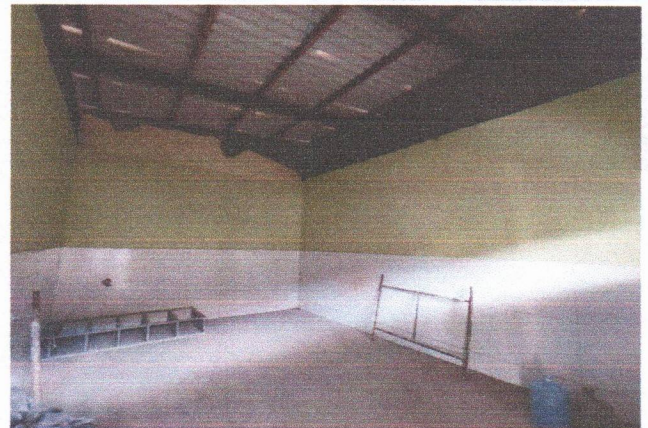
ESCOLA MUNICIPAL CLODOALDO GOMES DE ARAÚJO - ESTRUTURA DE MADEIRA E TELHAMENTO COM TELHA ONDULADA DE FIBROCIMENTO
