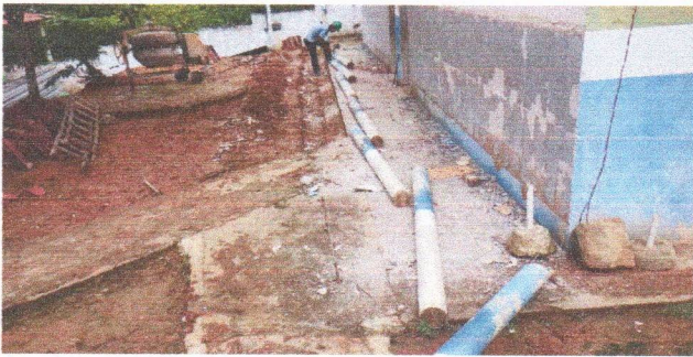
ESCOLA MUNICIPAL FRANCISCO TAVARES - DEMOLIÇÃO DE CONCRETO (PILARES)
