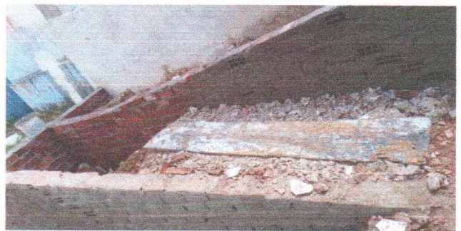
ESCOLA MUNICIPAL SENADOR FRANCISCO GOMES DE ARAÚJO - ASSENTAMENTO DE BLOCO CERÂMICO PARA A RAMPA DA ENTRADA
