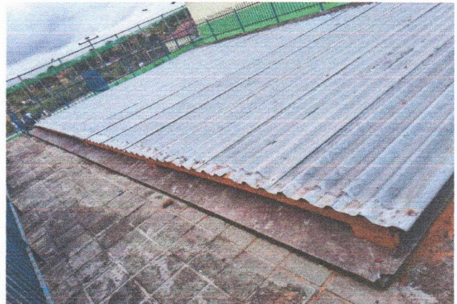
ESCOLA MUNICIPAL TIRADENTES - ESTRUTURA DE MADEIRA PARA APOIO DAS TELHAS
