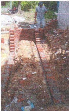
ESCOLA MUNICIPAL SENADOR FRANCISCO GOMES DE ARAÚJO - ASSENTAMENTO DE BLOCO CERÂMICO PARA A RAMPA DA ENTRADA
