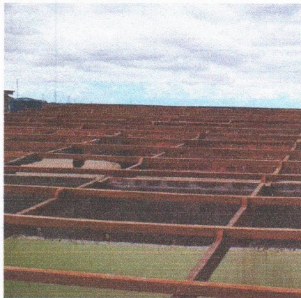
ESCOLA MUNICIPAL CLODOALDO GOMES DE ARAÚJO - ESTRUTURA DE MADEIRA NA COBERTA
