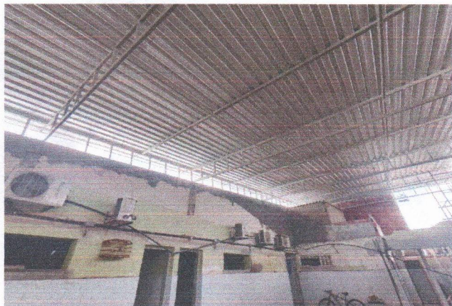
ESCOLA MUNICIPAL CLODOALDO GOMES DE ARAÚJO - ESTRUTURA DE COBERTA METÁLICA TRELIÇADA E TELHAMENTO COM TELHA METÁLICA
