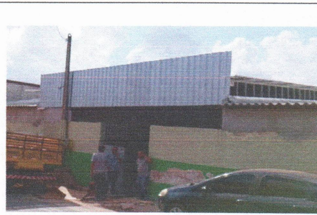
ESCOLA MUNICIPAL CLODOALDO GOMES DE ARAÚJO - ESTRUTURA DE COBERTA METÁLICA TRELIÇADA E TELHAMENTO COM TELHA METÁLICA
