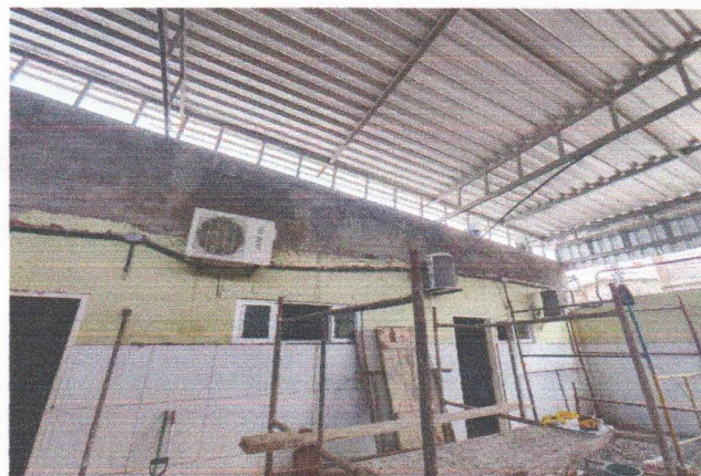
ESCOLA MUNICIPAL CLODOALDO GOMES DE ARAÚJO - ESTRUTURA DE COBERTA METÁLICA TRELIÇADA E TELHAMENTO COM TELHA METÁLICA
