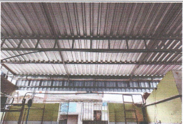
ESCOLA MUNICIPAL CLODOALDO GOMES DE ARAÚJO - ESTRUTURA DE COBERTA METÁLICA TRELIÇADA E TELHAMENTO COM TELHA METÁLICA
