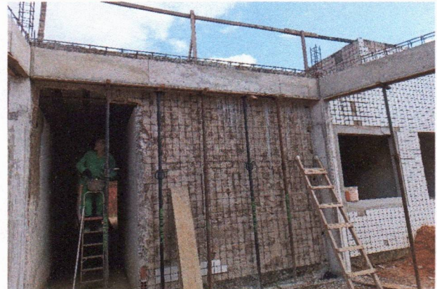
7.1 CONCRETO PILAR E VIGA
