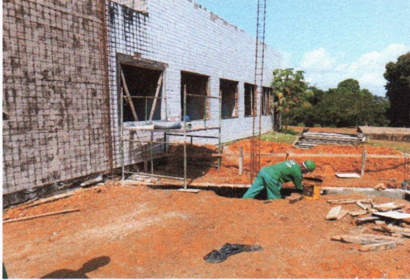
10.2 - IMPERMEABILIZAÇÃO DE SUPERFICIE (VIGA BALDRAME)
