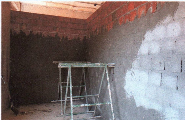
8.1 - ALVENARIA DE VEDAÇÃO E= 9CM
