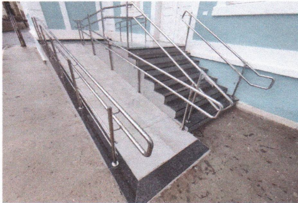
NOVA CALÇADA, RAMPA E ESCADARIA COM REVESTIMENTO CERÂMICO E ACABAMENTO EM GRANITO (PREFEITURA SEDE)
