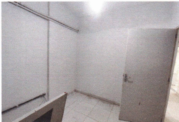
SELADOR E EMASSAMENTO NAS PAREDES (ANEXO LATERAL)
