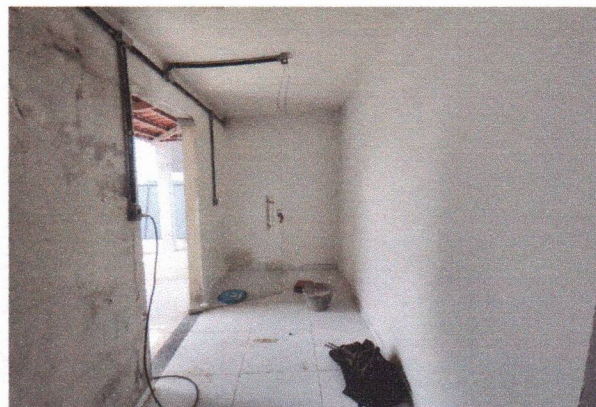
SELADOR E EMASSAMENTO NAS PAREDES E TETO (ANEXO LATERAL)
