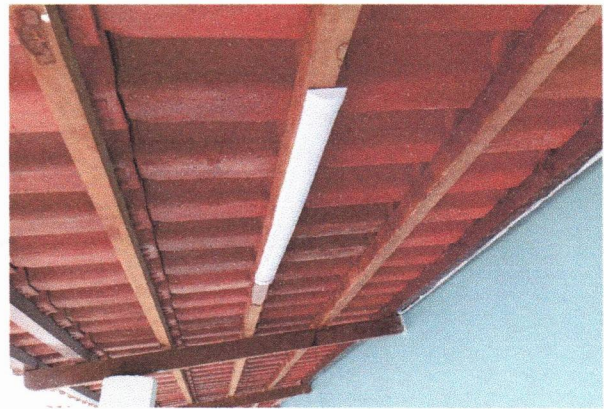
LUMINÁRIA LED (ANEXO LATERAL)
