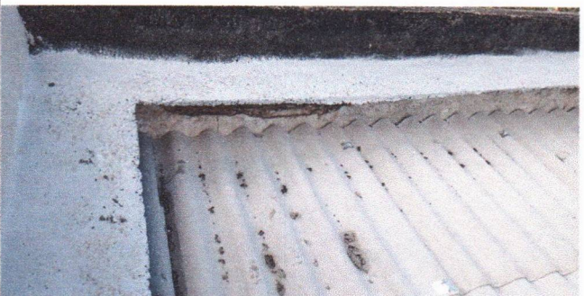
IMPERMEABILIZAÇÃO NA COBERTA (PREFEITURA SEDE)
