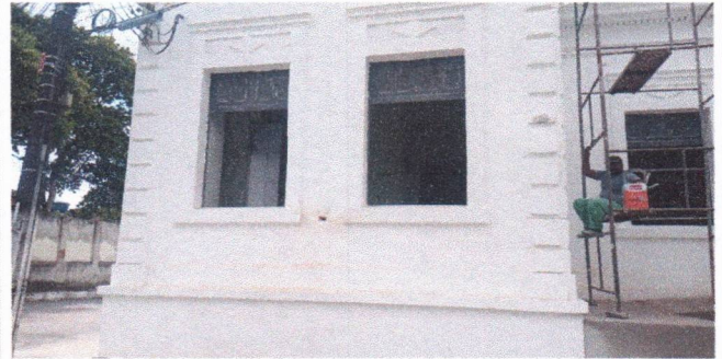
APLICAÇÃO DE SELADOR E MASSA ACRÍLICA (PREFEITURA SEDE)
