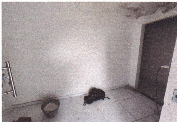
SELADOR E EMASSAMENTO NAS PAREDES (ANEXO LATERAL)
