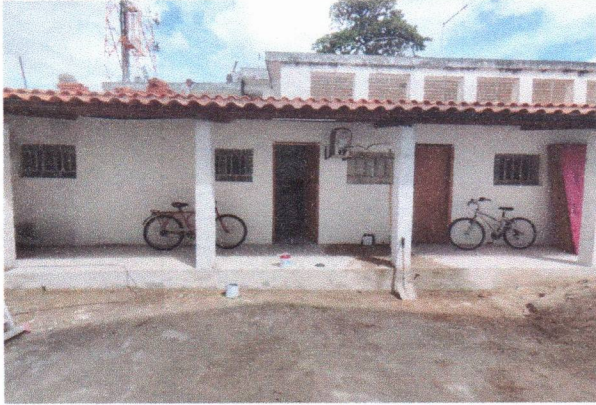
APLICAÇÃO DE SELADOR E MASSA ACRÍLICA (ANEXO LATERAL)
