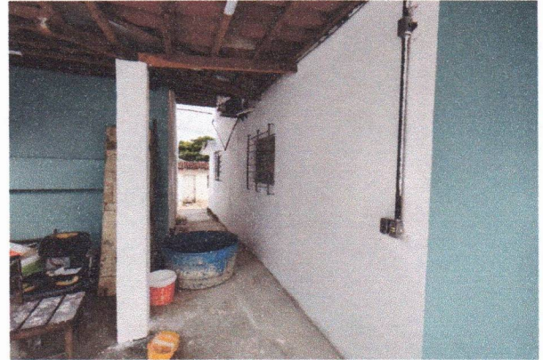
APLICAÇÃO DE MASSA ACRÍLICA E PINTURA NAS PAREDES (ANEXO LATERAL)
