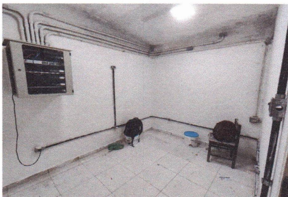
SELADOR E EMASSAMENTO NAS PAREDES (ANEXO LATERAL)
