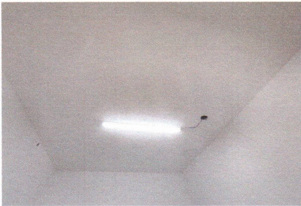
LUMINÁRIA LED (ANEXO LATERAL)
