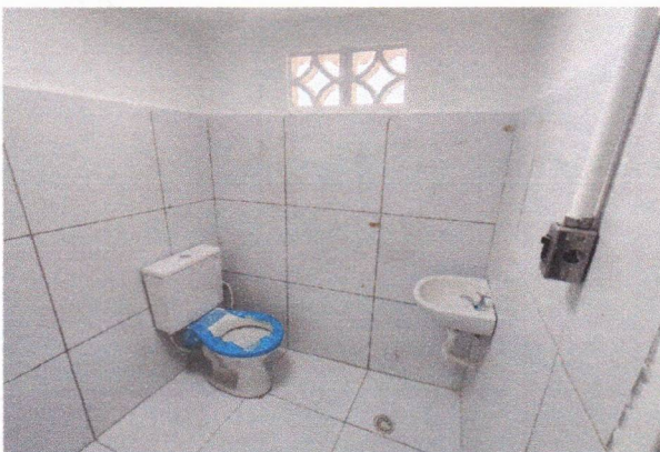
INSTALAÇÃO DE RALO, VASO SANITÁRIO E LAVATÓRIO COMPLETO (ANEXO LATERAL)
