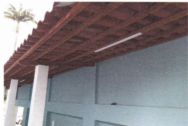
LUMINÁRIA LED (ANEXO LATERAL)
