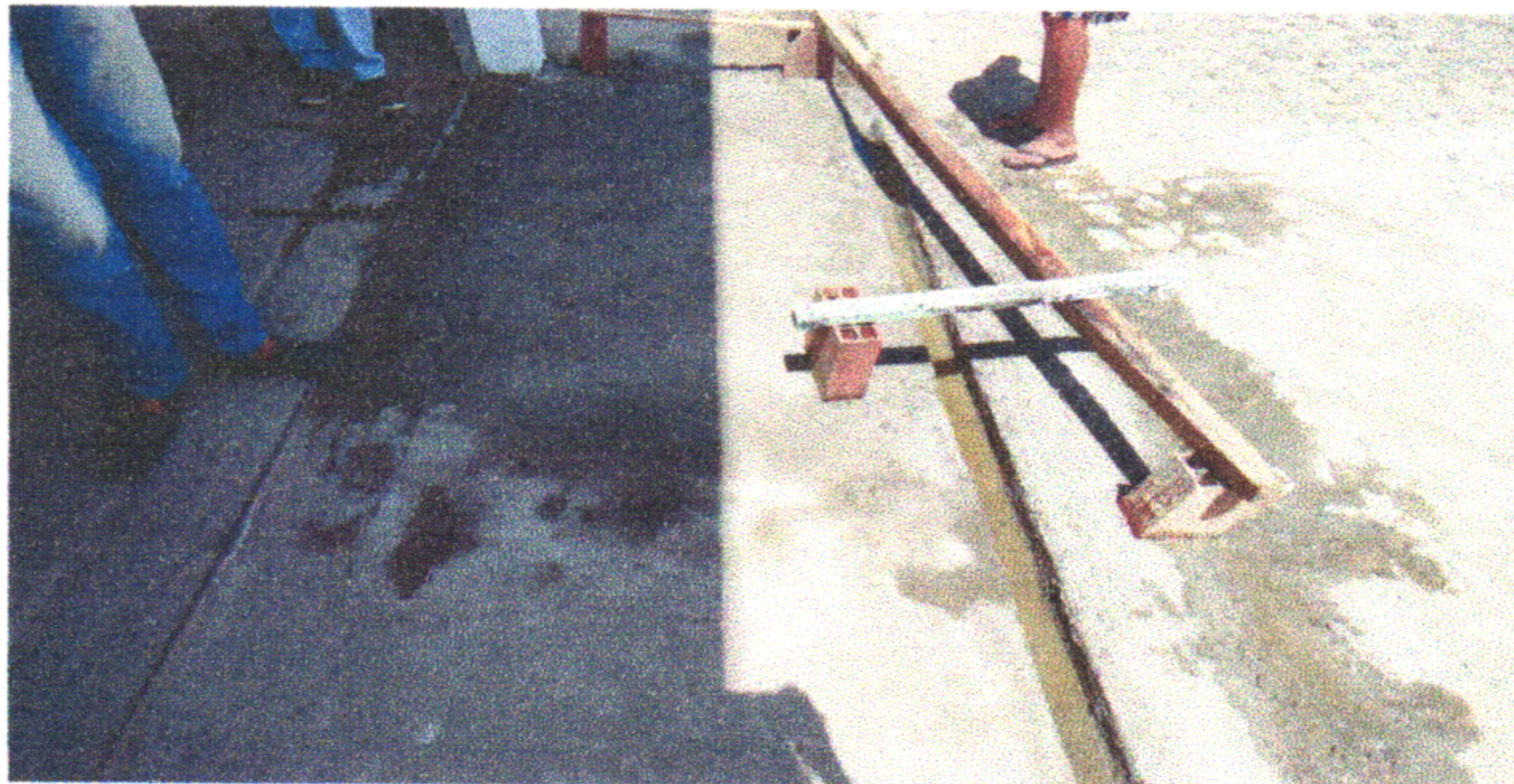
DEMOLIÇÃO DA ANTIGA CALÇADA, LASTRO E RAMPA EM CONCRETO
