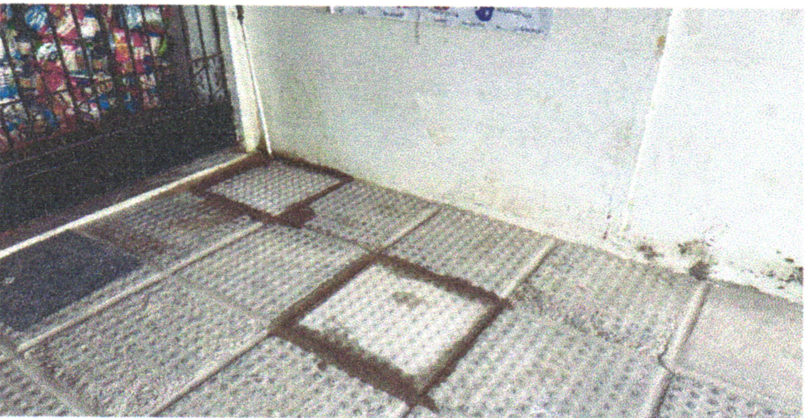
SUBSTITUIÇÃO DE LAJOTAS
