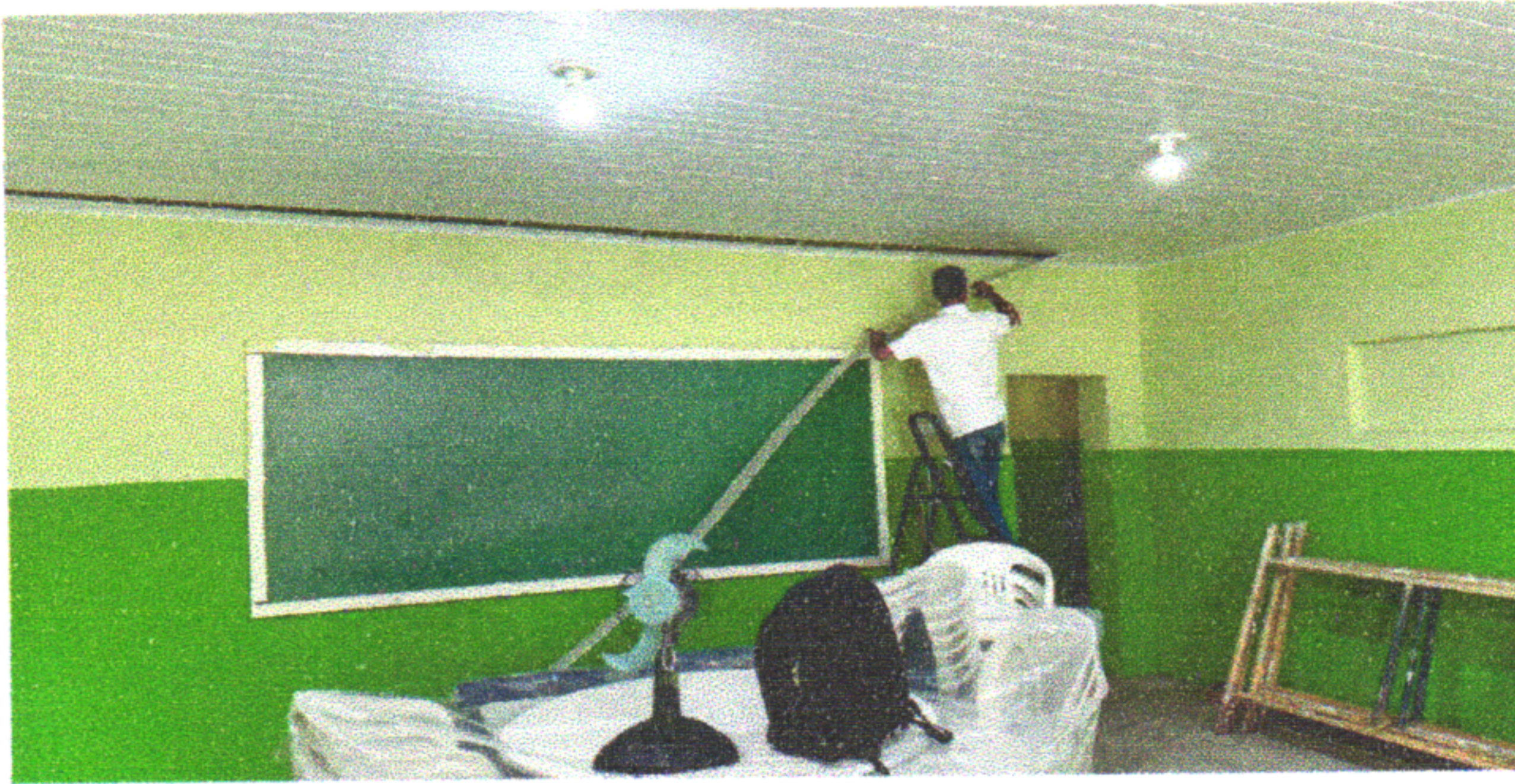
REMOÇÃO DO FORRO DE PVC E DAS LUMINÁRIAS
