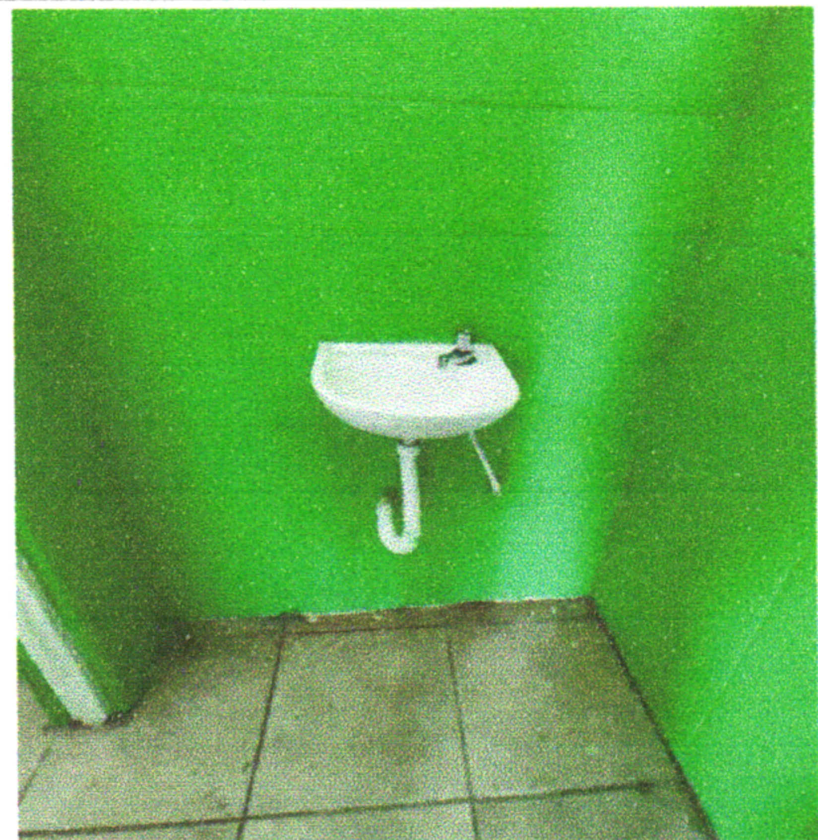
PONTO DE ESGOTO DO LAVATÓRIO, SUBSTITUIÇÃO DA TORNEIRA, SIFÃO, VÁLVULA E ENGATE, PINTURA ACRÍLICA NAS PAREDES
