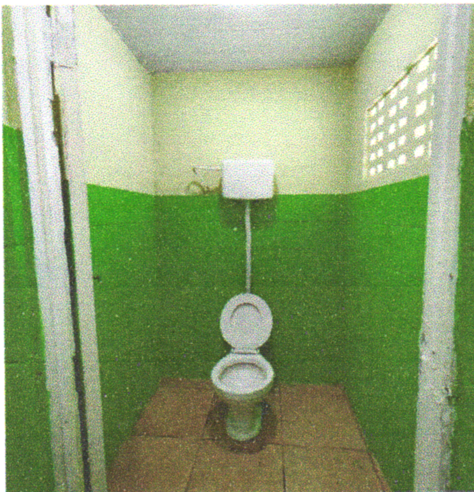
SUBSTITUIÇÃO DO ASSENTO SANITÁRIO, DA DESCARGA SUSPensa COMPLETA E PINTURA ACRÍLICA NAS PAREDES
