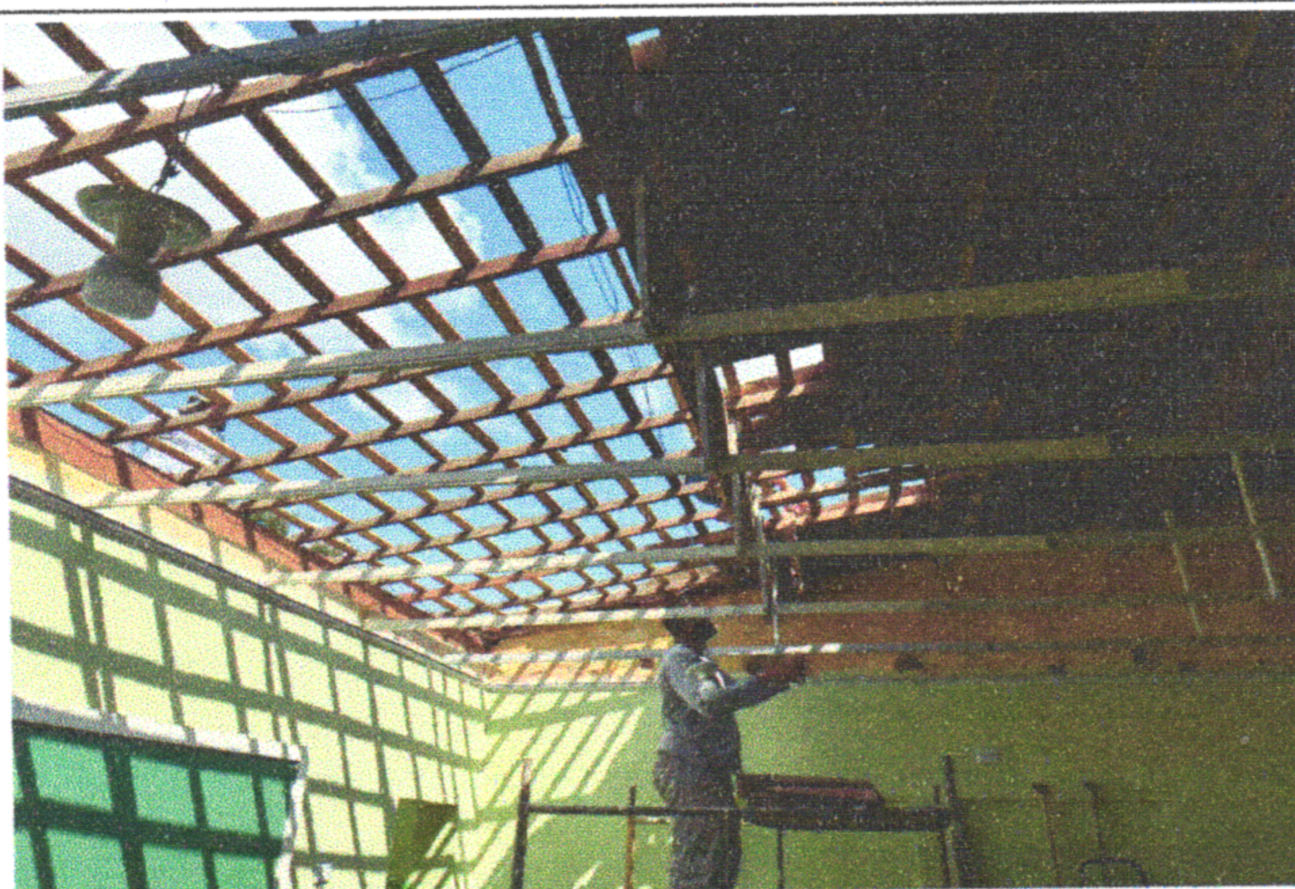
REMOÇÃO DAS TELHAS, DAS INSTALAÇÕES ELÉTRICAS, DO FORRO DE PVC E UTILIZAÇÃO DE ANDAIME
