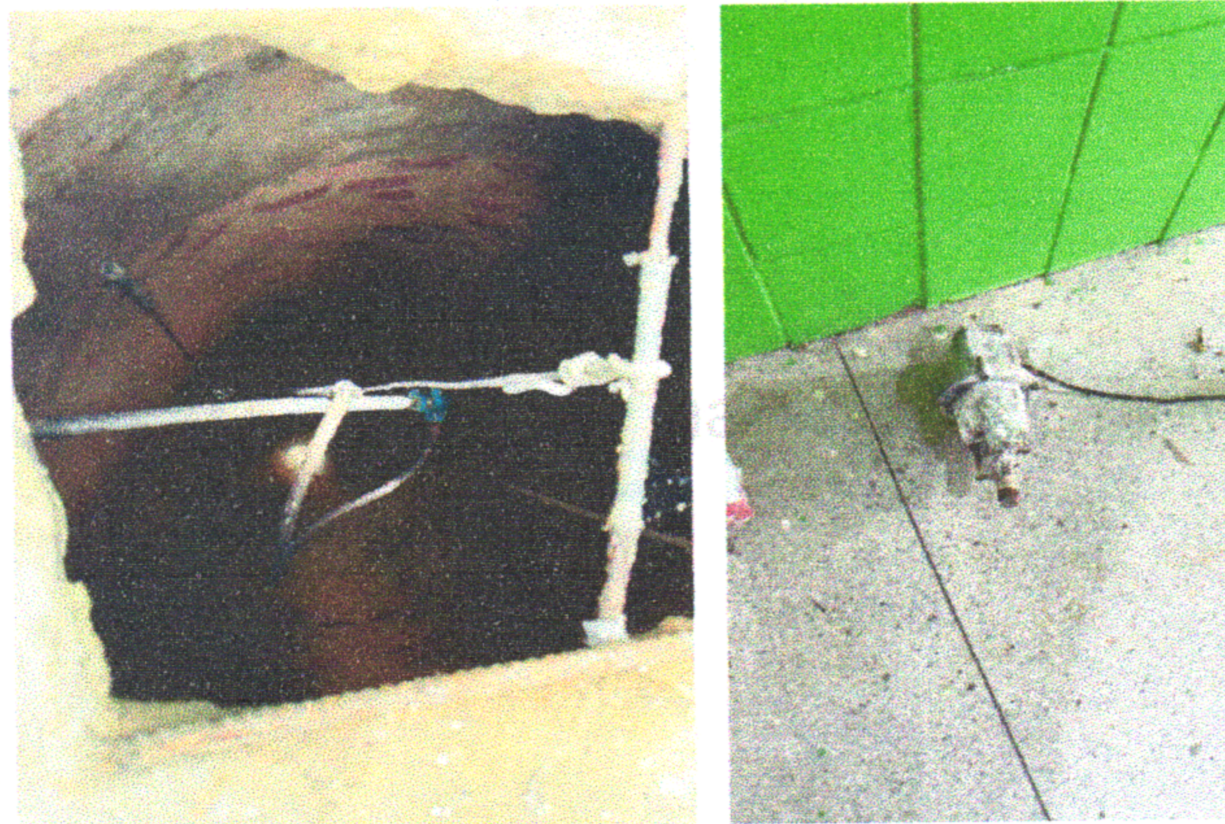
REMOÇÃO DO CABO QUE ALIMENTA A BOMBA SUBMERSA E REMOÇÃO DA BOMBA SUBMERSA
