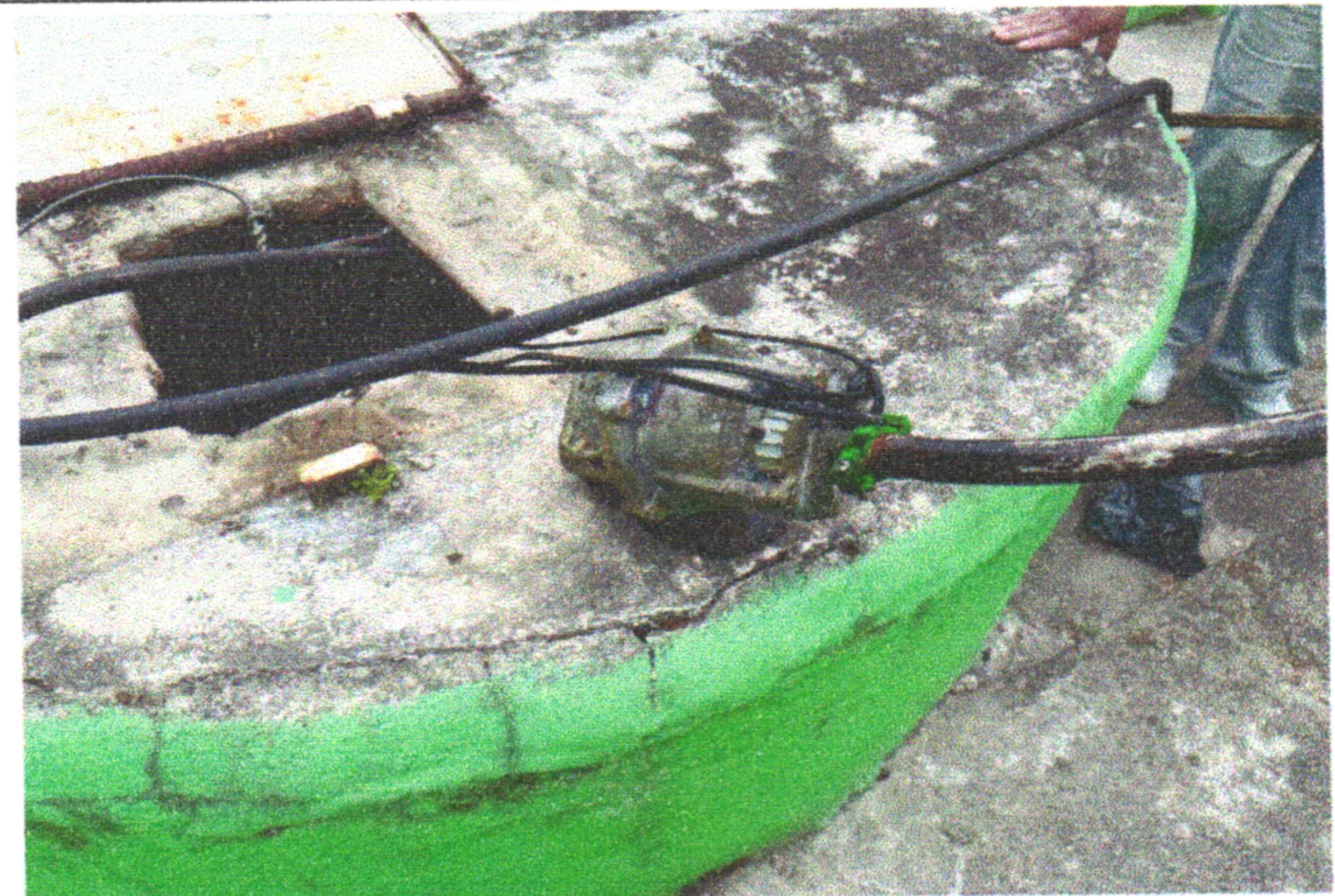
SUBSTITUIÇÃO DO CABO E DA BOMBA SUBMERSA
