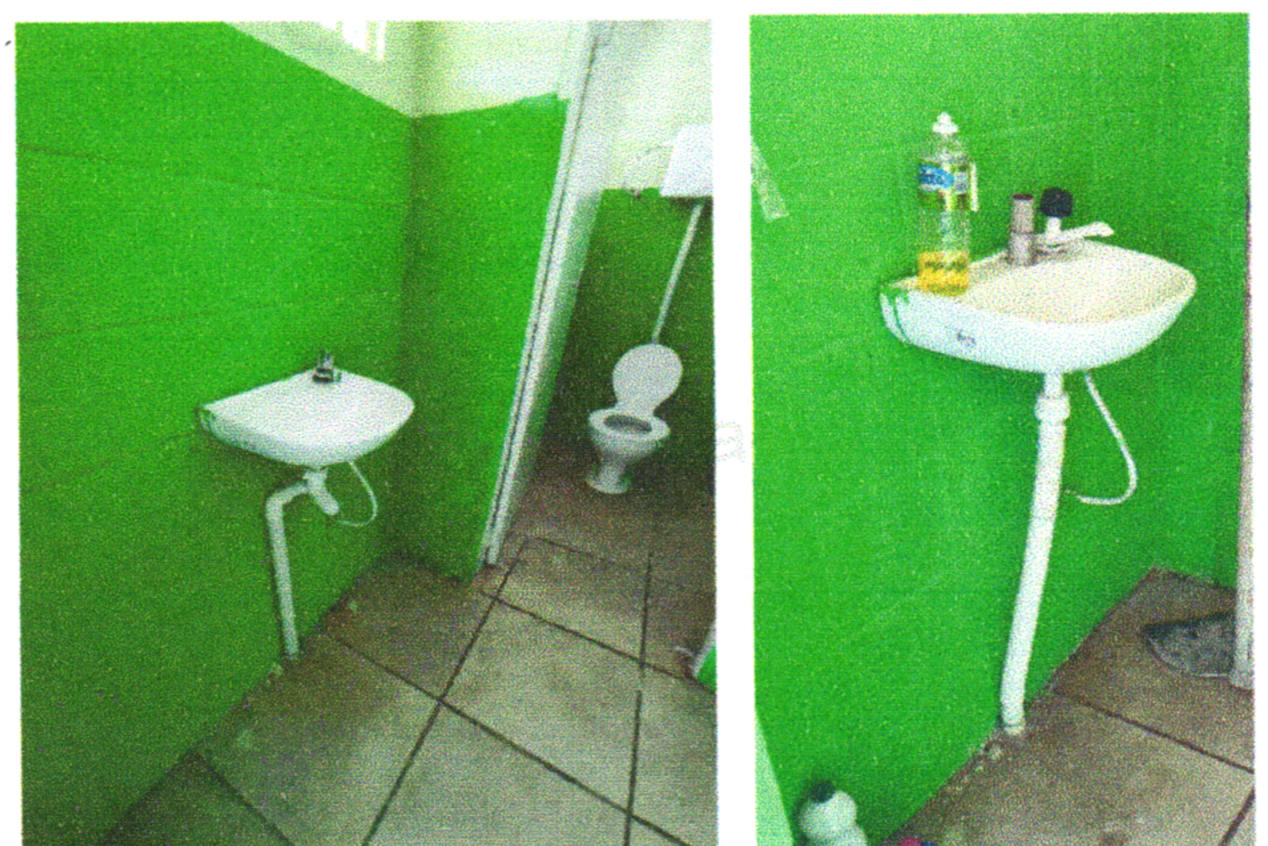
PONTO DE ESGOTO DO LAVATÓRIO, SUBSTITUIÇÃO DA TORNEIRA, SIFÃO, VÁLVULA E ENGATE, PINTURA ACRÍLICA NAS PAREDES
