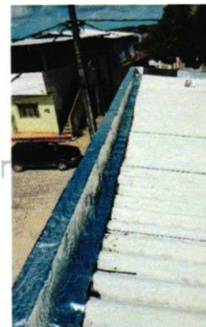
TELHA DE FIBROCIMENTO, RUFO E MANTA ASFALTICA
