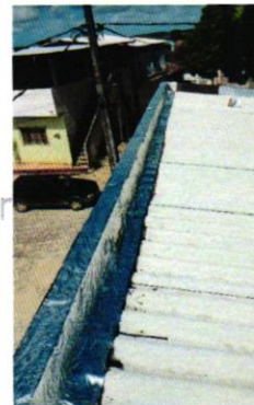
TELHA DE FIBROCIMENTO, RUFO E MANTA ASFÁLTICA
